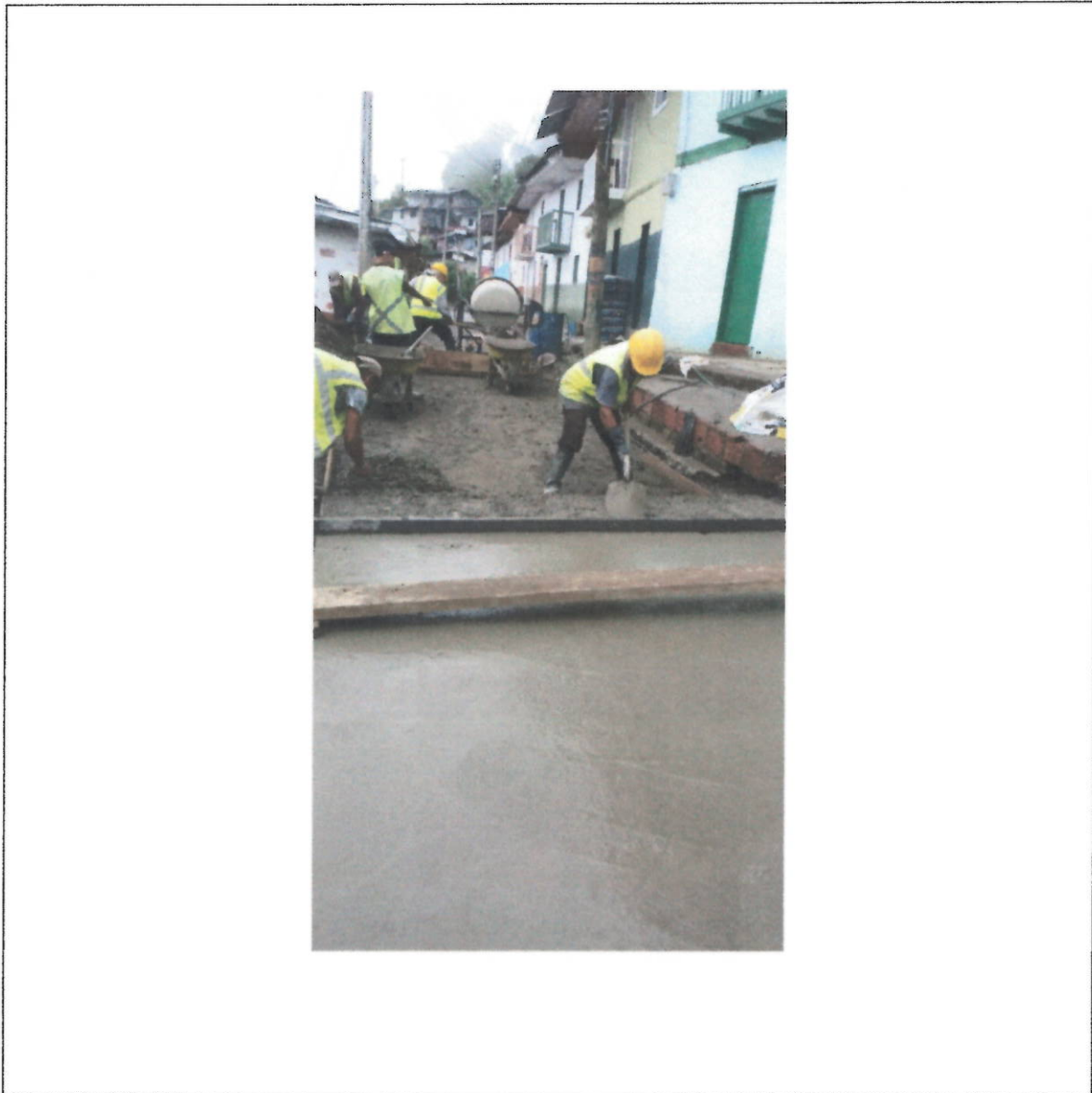
Vaciado de concreto el playon - Salamina
