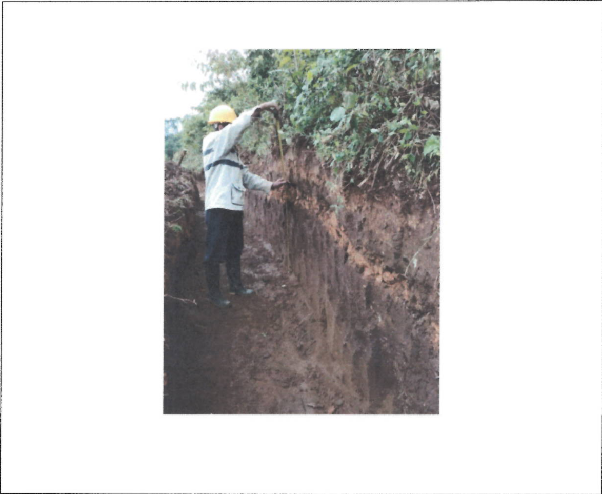
Excavaciones para tubería acueducto sector aguas frias - Neira
