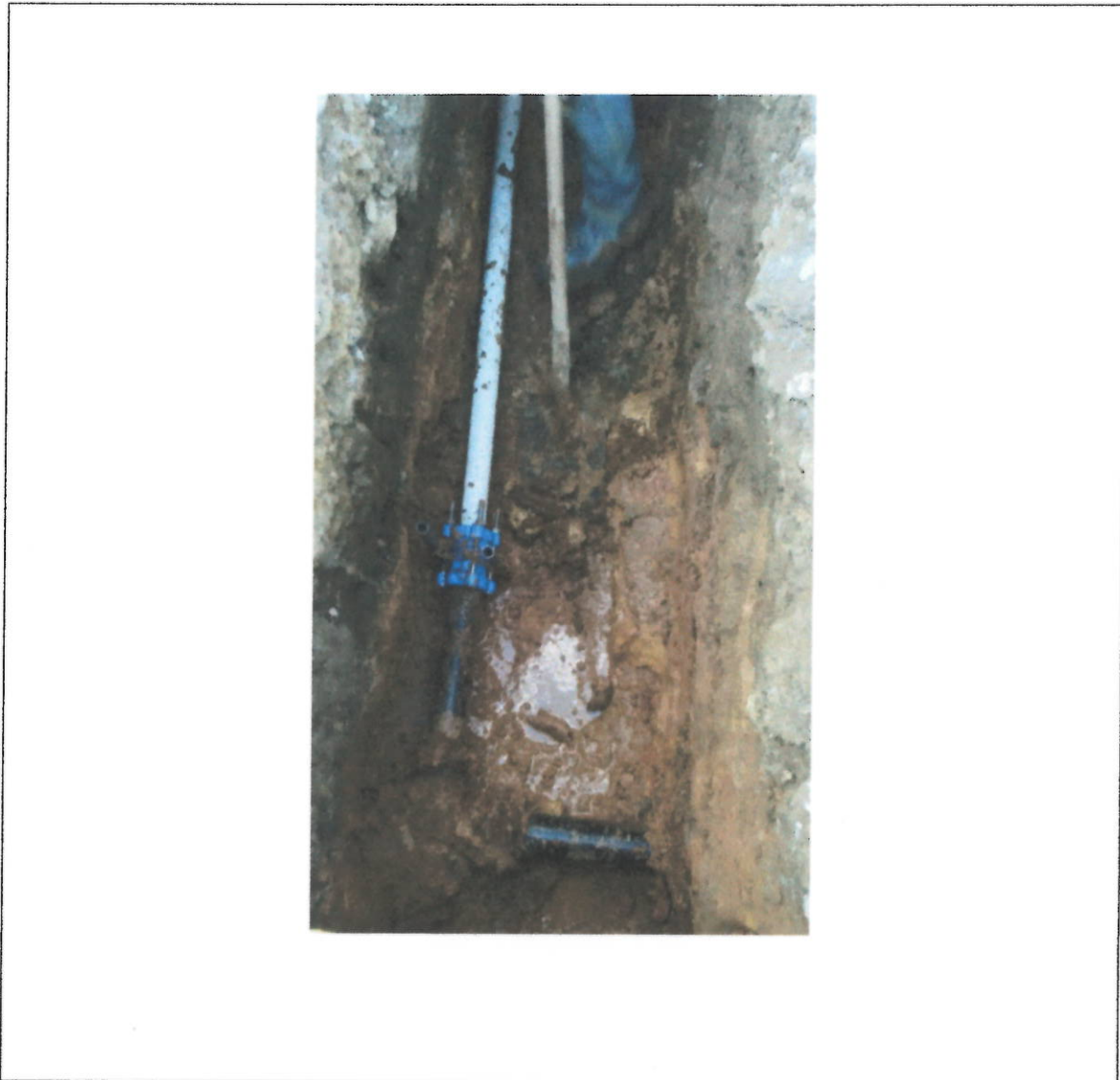
Instalación tubería de acueducto calle 10 entre 4 y 5 - Aguadas
