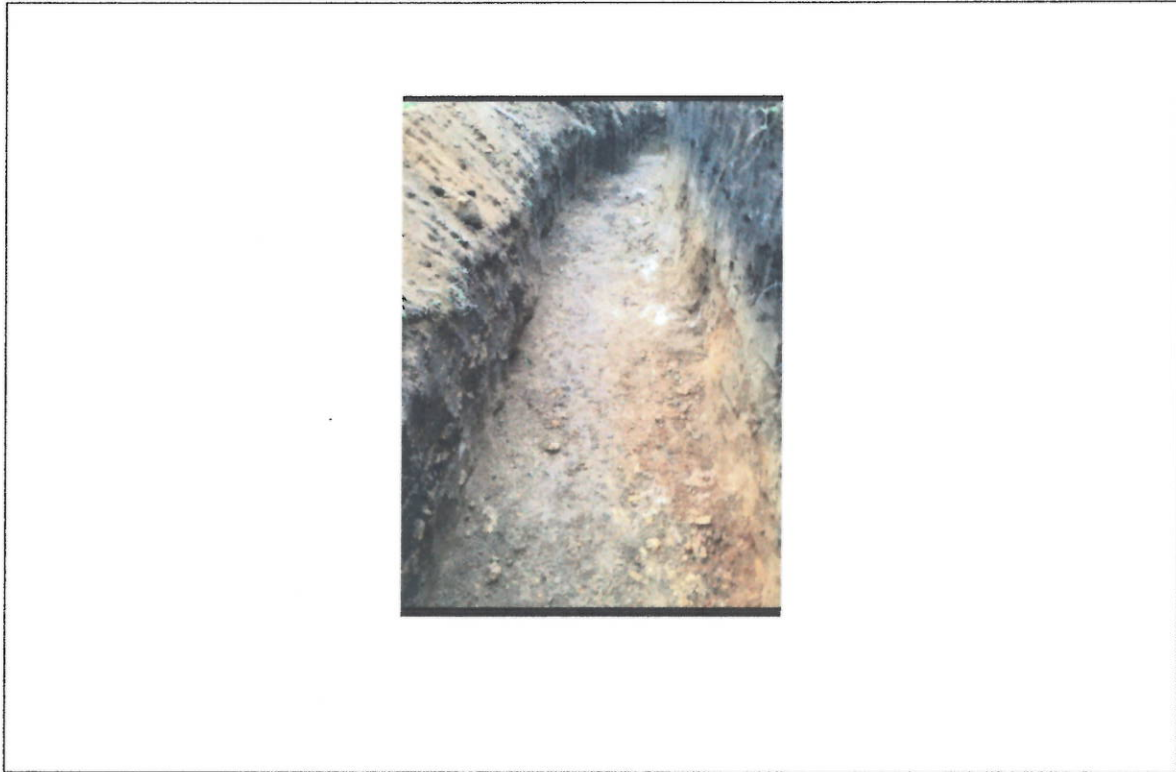
Excavación para tubería sector aguas frias - Neira
