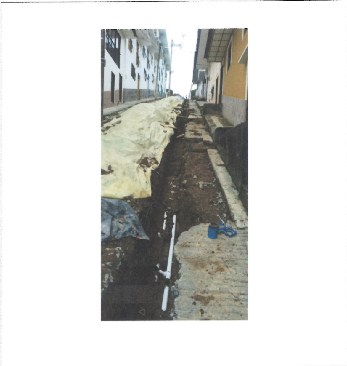
Instalación tubería PVC 2" carrera 7 entre calles 8 y 9 - Aguadas
