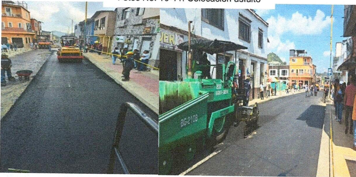
Fotos No. 10-11: Colocación asfalto
