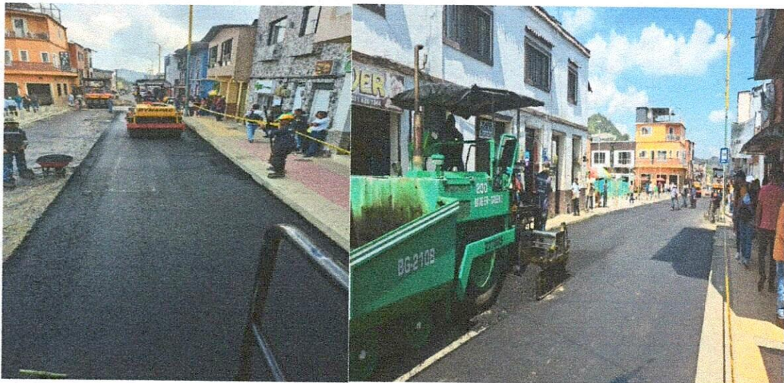
Fotos No. 10-11: Colocación asfalto
