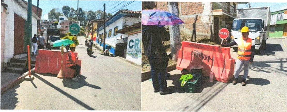
Fotos No. 2-3: Controladores de tránsito
