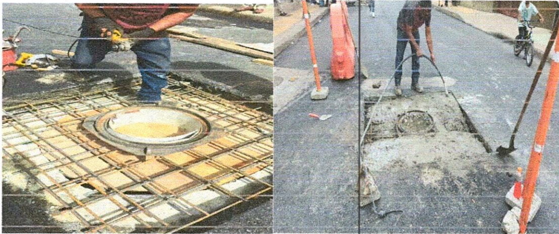
Fotos No. 12-13: Acero de refuerzo y realce camaras
