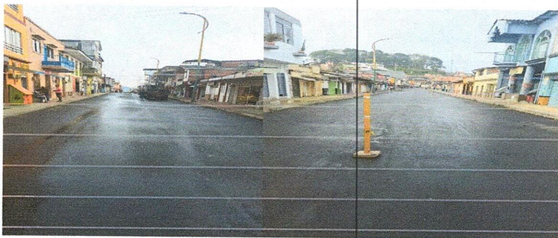
Fotos No. 4-5: Aspecto general via pavimentada
