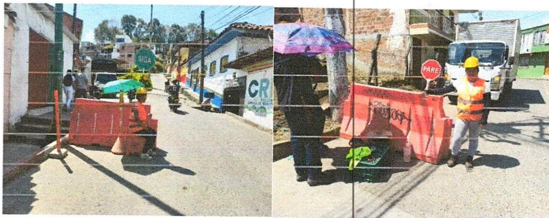
Fotos No. 2-3: Controladores de tránsito
