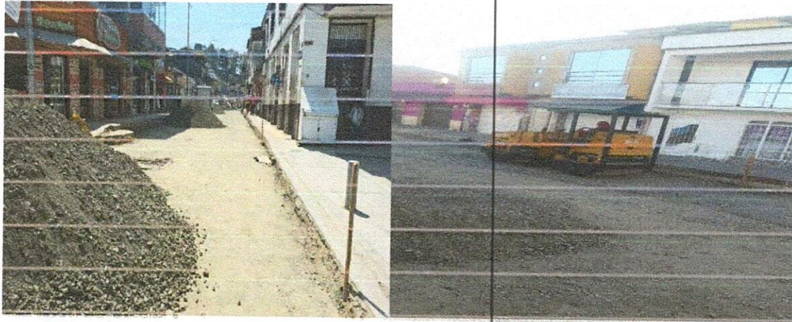
Fotos No. 6-7: Toma de densidades de Base granular
