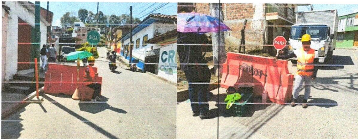
Fotos No. 2 3: Controladores de tránsito
