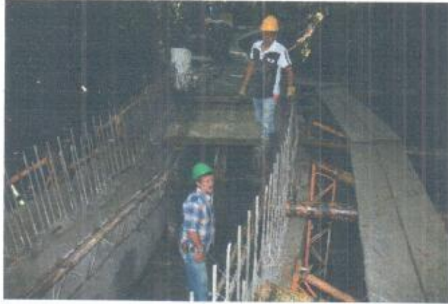
Preparación y fundida losa superior 4° tramo
