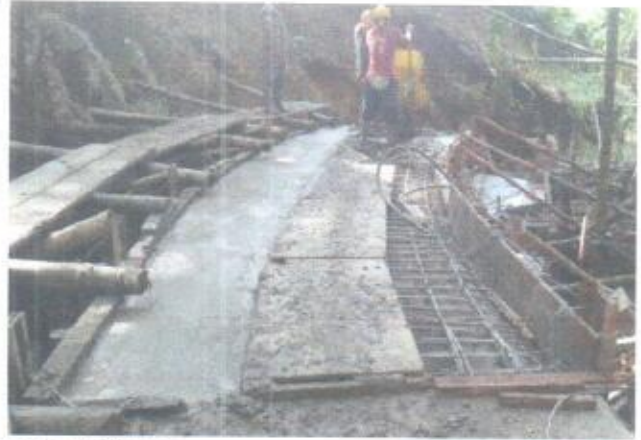
Preparación y fundida losa superior 4° tramo
