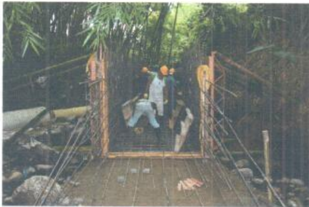
Instalación de acero dejando traslapos para el siguiente tramo y fijación cinta PVC para sello
