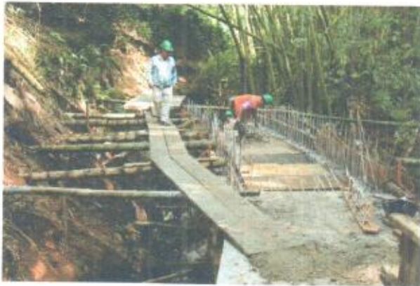
Fundida losa superior 2º tramo e inicio encofrado 3º tramo y colocación de acero de refuerzo
