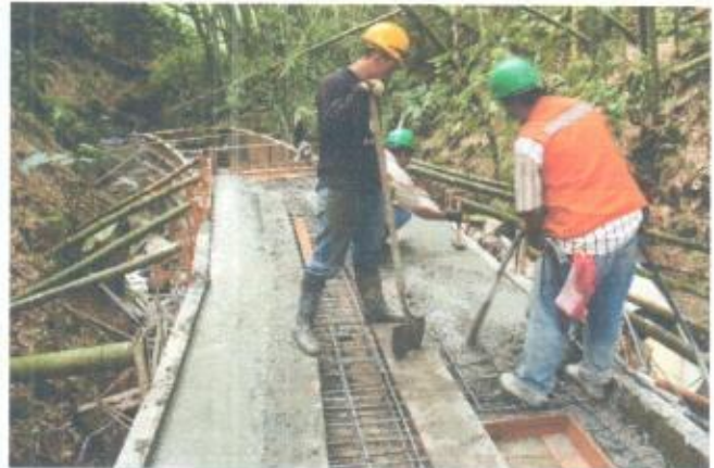
Retiro formaleta interior del primer tramo y fundida de losa superior
