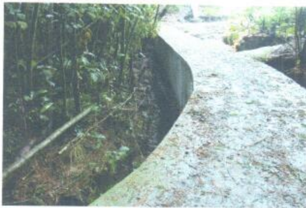
Construcción filtro 30x40 con tubería 100 mm a ambos costados del inicio del boxculvert
