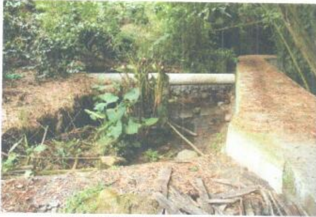
Inicio del Boxculvert y zona de emposamiento de las aguas, de las que se solicita corrección
