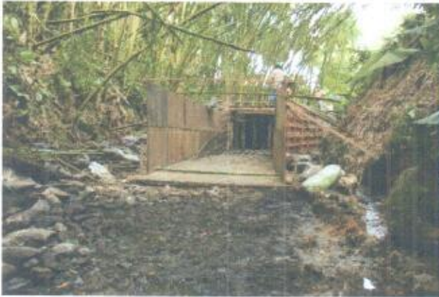
Instalación formaleta segundo tramo e inicio instalación acero de refuerzo
