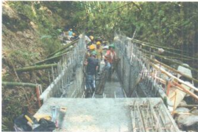
Retiro formaleta interior del primer tramo y fundida de losa superior
