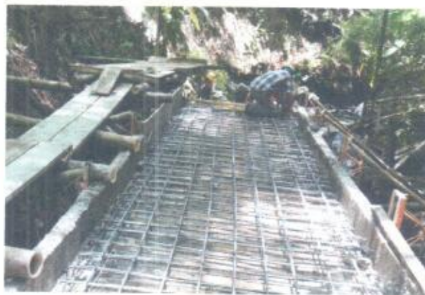
Preparación superficie de apoyo 4º tramo y preparación fundida losa superior 3º tramo.
