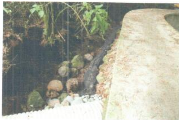
Construcción filtro 30x40 con tubería 100 mm a ambos costados del inicio del boxculvert
