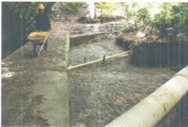
Cubrimiento con afirmado del área del pedraplén y fundida de paredes y losa de piso del 2° cuerpo
