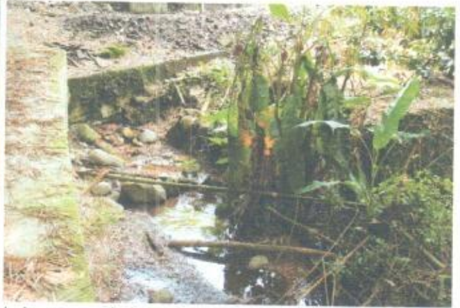
Inicio del Boxculvert y zona de emposamiento de las aguas, de las que se solicita corrección
