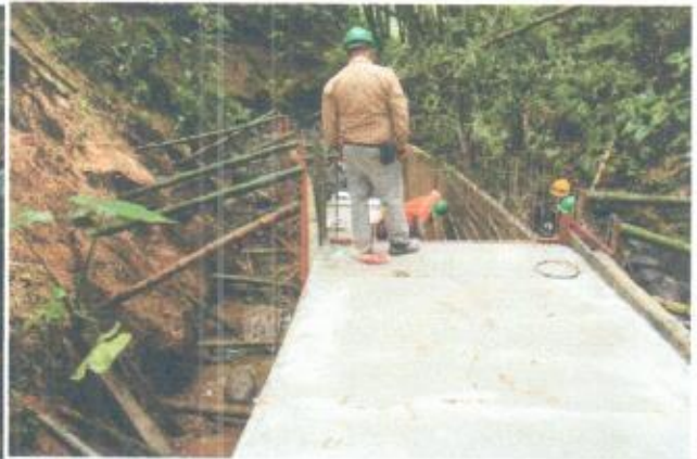
Instalación formaleta segundo tramo e inicio instalación acero de refuerzo
