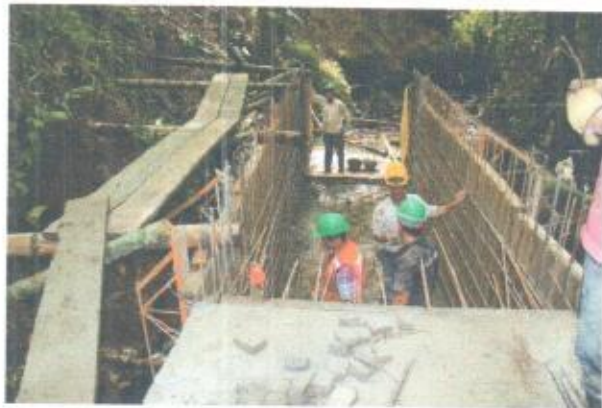
Fundida losa superior 2º tramo e inicio encofrado 3º tramo y colocación de acero de refuerzo
