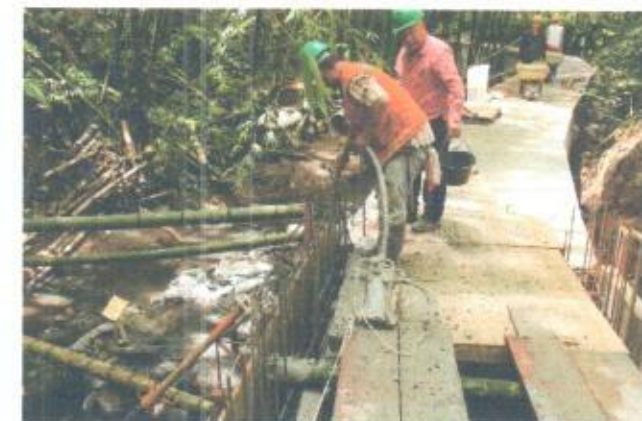
Cubrimiento con afirmado del área del pedraplén y fundida de paredes y losa de piso del 2° cuerpo
