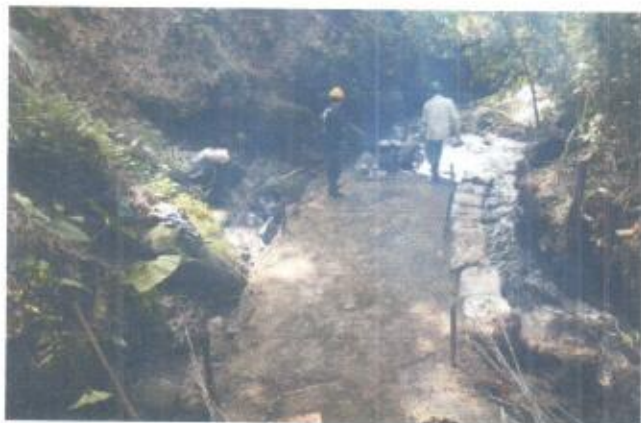
Preparación superficie de apoyo 4º tramo y preparación fundida losa superior 3º tramo.
