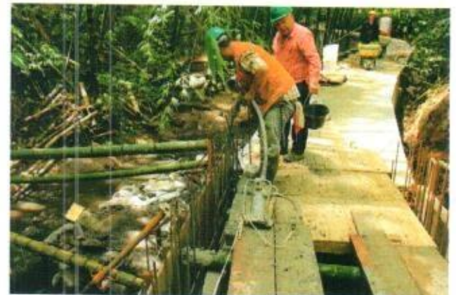
Cubrimiento con afirmado del área del pedraplén y fundida de paredes y losa de piso del 2° cuerpo
