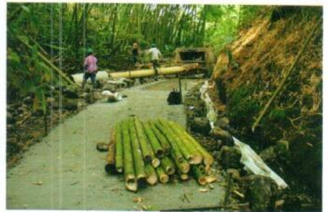
Proceso de compactación del afirmado y fundida de solado de limpieza
