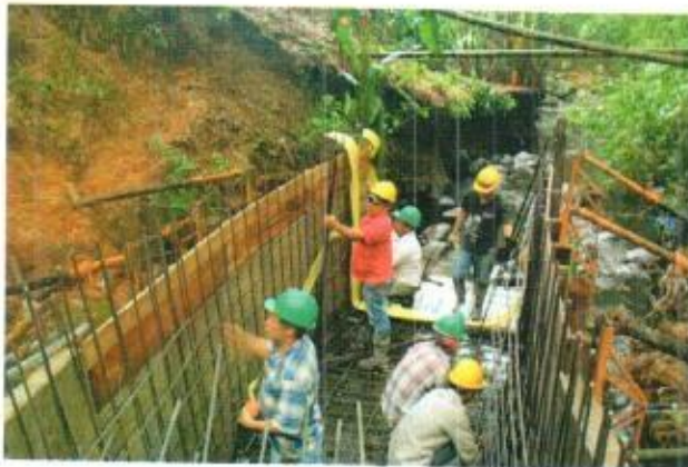
Instalación acero de refuerzo último tramo del box e instalación de cinta PVC
