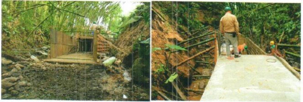
Instalación formaleta segundo tramo e inicio instalación acero de refuerzo
