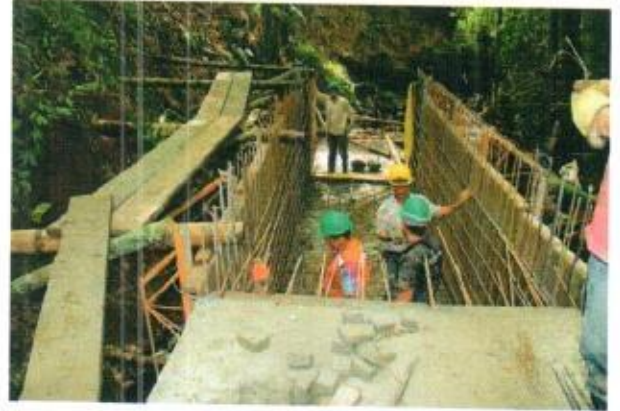
Fundida losa superior 2° tramo e inicio encofrado 3er tramo y colocación de acero de refuerzo
