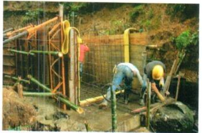
Instalación acero de refuerzo último tramo del box e instalación de cinta PVC
