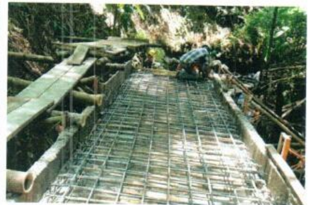
Preparación superficie de apoyo 4° tramo y preparación fundida losa superior 3er tramo.
