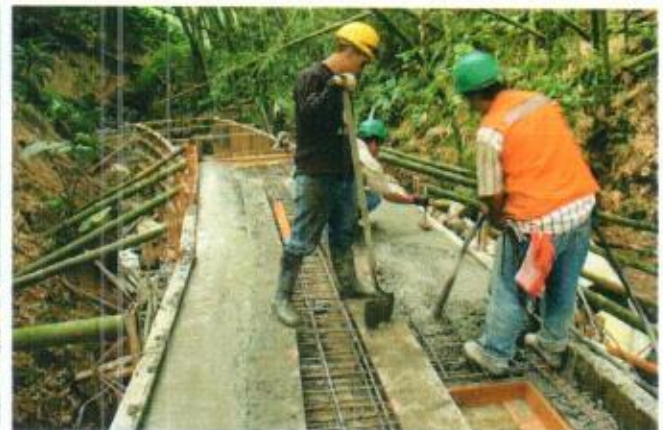
Retiro formaleta interior del primer tramo y fundida de losa superior
