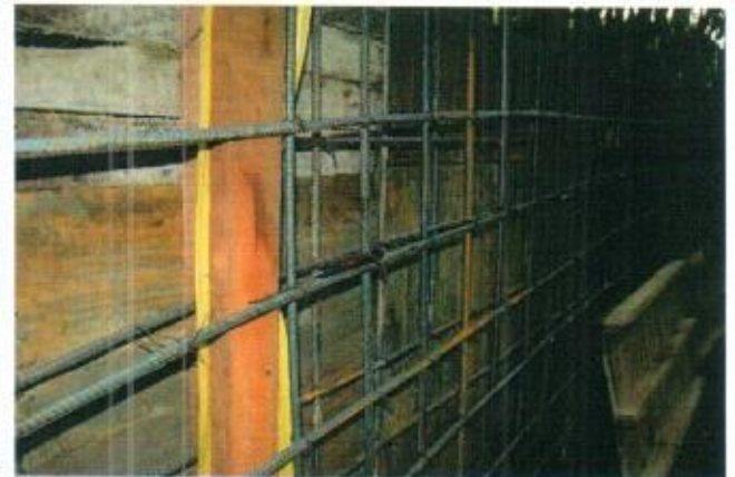
Instalación de acero dejando traslapos para el siguiente tramo y fijación cinta PVC para sello
