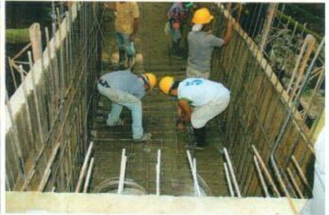
Colocación de formaleta e instalación de acero de refuerzo
