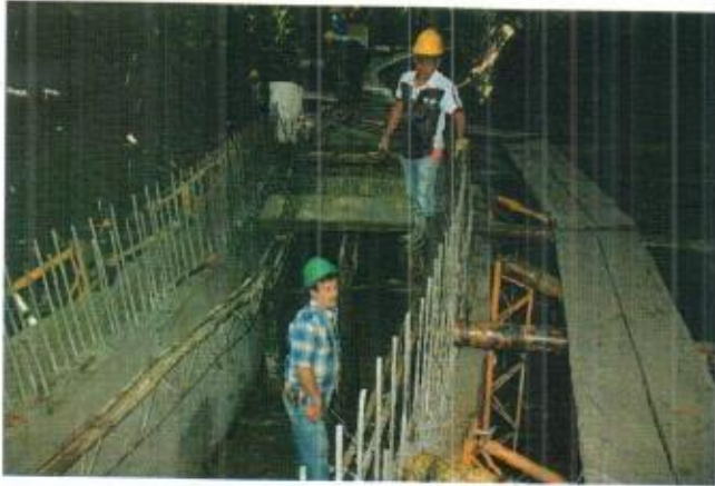
Preparación y fundida losa superior 4° tramo
