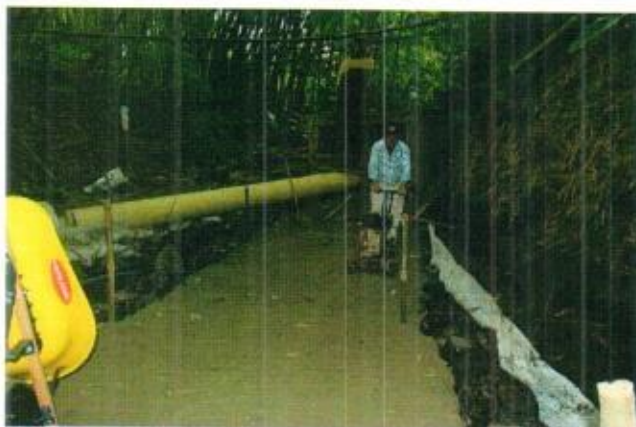
Proceso de compactación del afirmado y fundida de solado de limpieza
