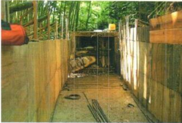
Colocación de formaleta e instalación de acero de refuerzo
