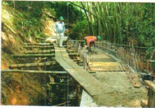
Fundida losa superior 2° tramo e inicio encofrado 3er tramo y colocación de acero de refuerzo
