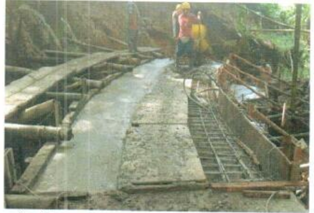
Preparación y fundida losa superior 4° tramo
