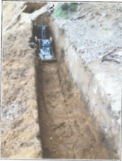
Llenos con material de sitio entre las cámaras C33c a C33a con equipo mecánico
