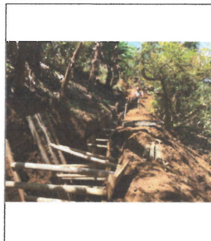
Entibados en excavaciones superiores a los 1.50 m. entre las cámaras C34 a C33c
