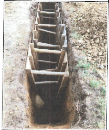
Entibas de las zanjas entre las cámaras C33a a C33
