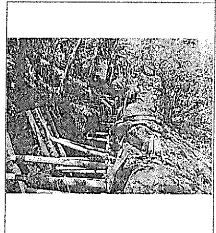
Enlizados en excavaciones superiores a los 1.50 m. entre las cámaras C34 a C33c
