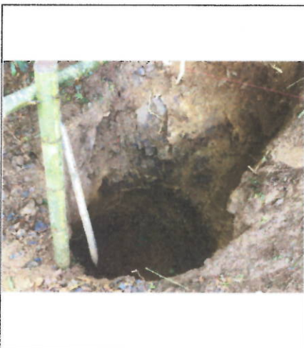
Excavación para cámara C34 100% conglomerado
