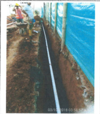
- Instalación de tubería 3" PVC - Presión en acueducto.
