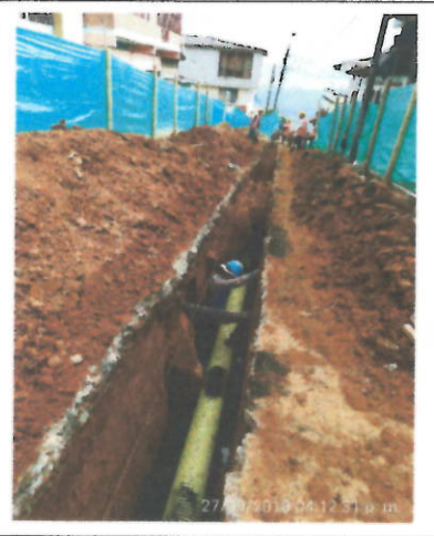
- Instalación de tubería Novafort corrugada 12".
