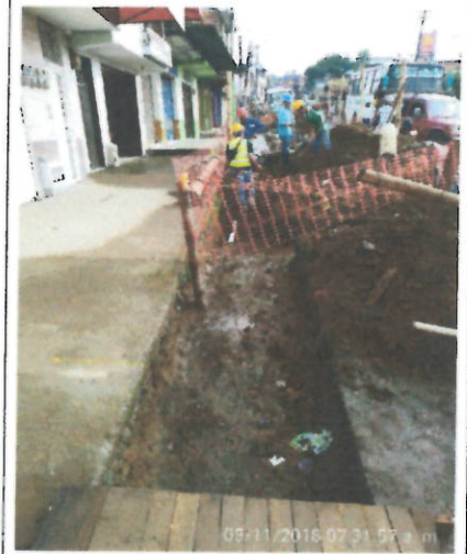
- Lleno de zanja intervenida.
