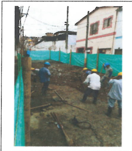
- Demolición de pavimento existente.
