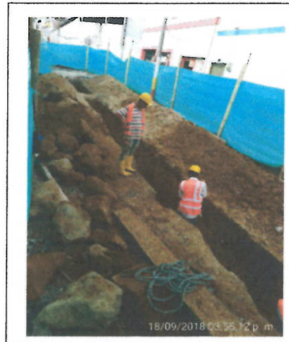
- Retiro de roca en excavación.
