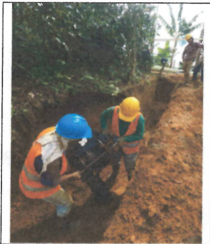
Proceso de compactación de lleno entre cámara C15 y C15a con maquinaria (canguro)
