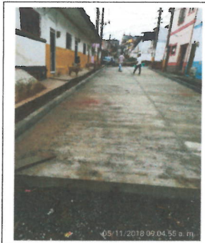
- Tramo de pavimento terminado.
