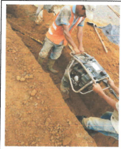
- Compactación mecánica de lleno.
