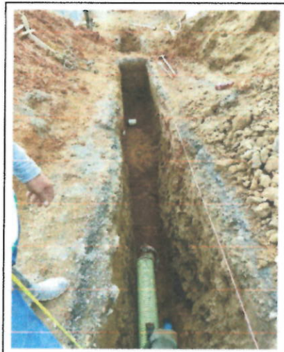
- Verificación de alturas en instalación de tubería.
