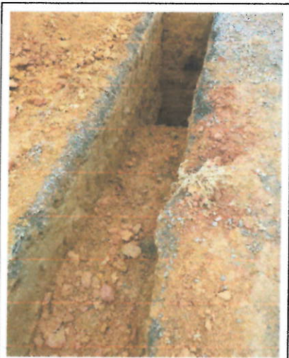
- Lleno de zanja.
