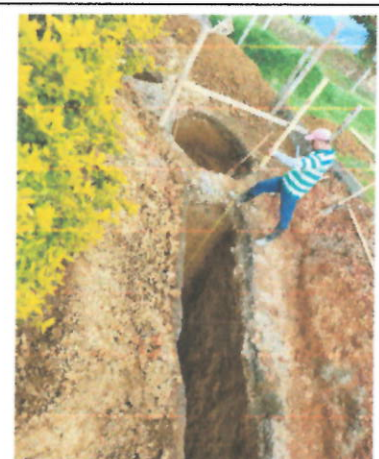
- Excavación de cámara C1a.
