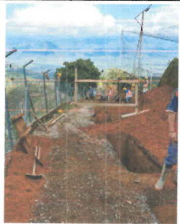
- Inicio de excavación entre cámaras C2 - C1a.
