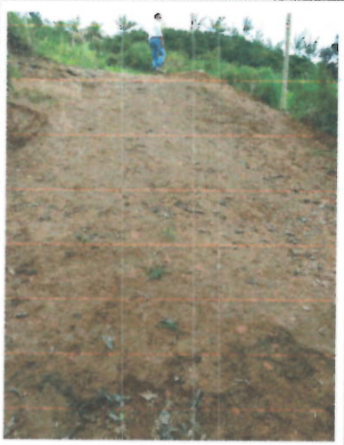
- Terreno conformado y compactado.
