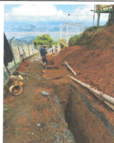
- Excavación entre cámaras C2a - C2.
