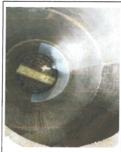
- Instalación de lámina de polipropileno en cámara de caída.
