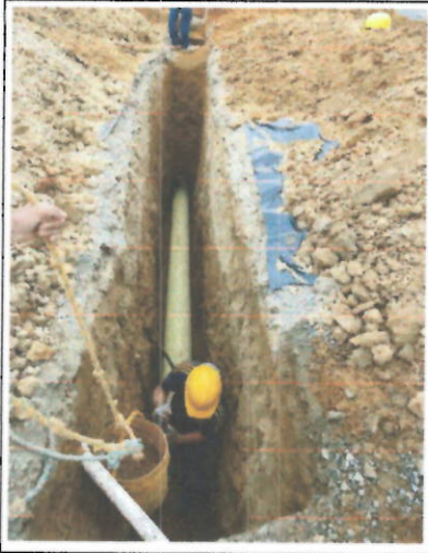
- Instalación de tubería.
