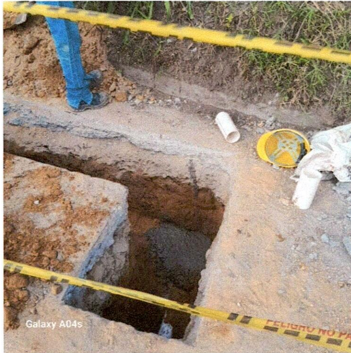
Imagen 23.- Excavación en zanja para posterior instalación de tubería de acueducto.
