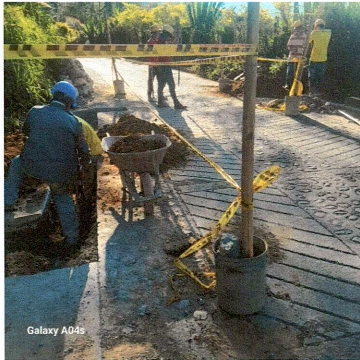
Imagen 19.- Excavación en zanja adyacente a placa huella en sector de cielito Lindo.
