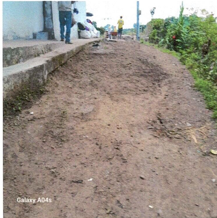
Imagen 9.- Inicio de actividades de excavación en zanja en barrio Medellín
