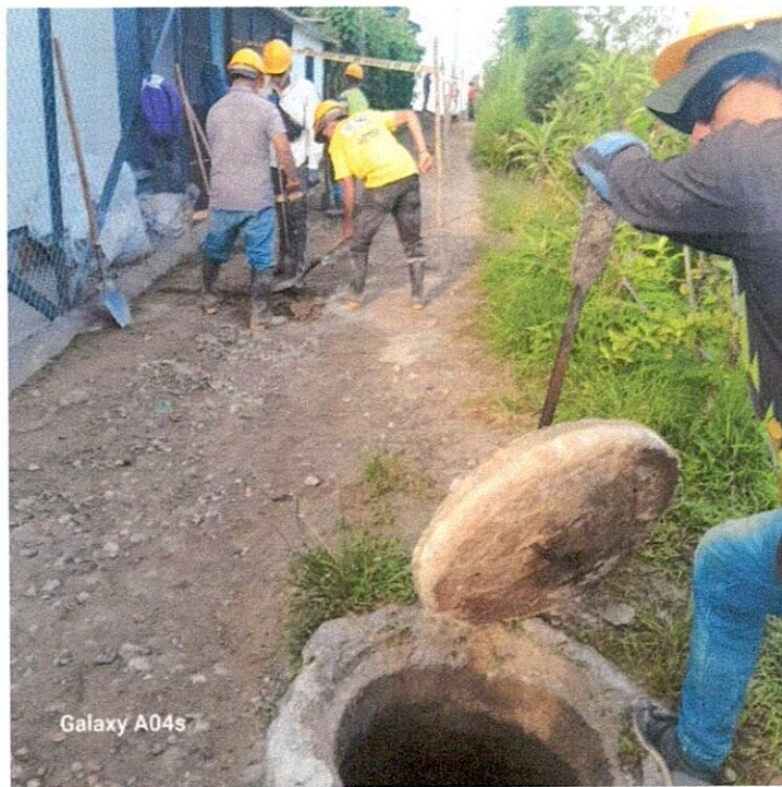
Imagen 10.- Actividades de excavación en zanja en barrio Medellín
