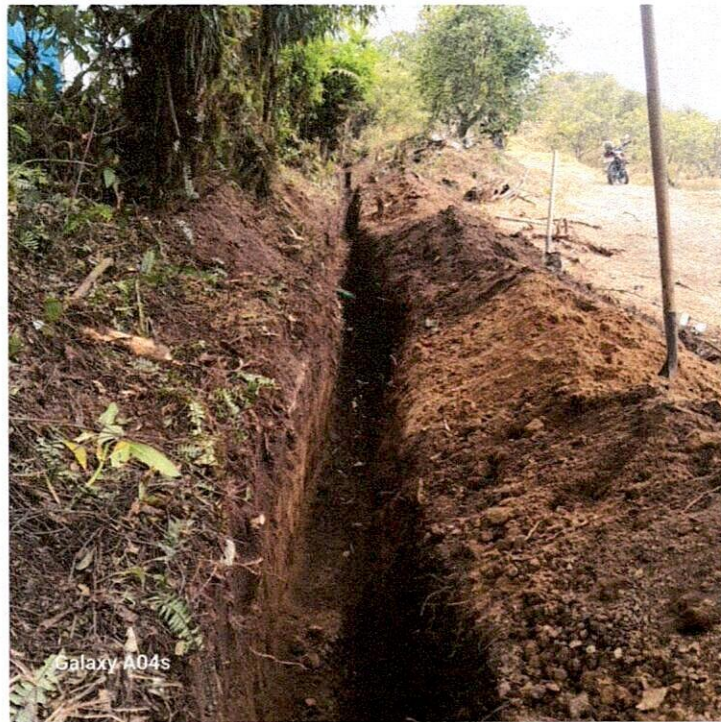
Imagen 5.- Inicio de excavación en zanja para posterior instalación de tubería de acueducto
