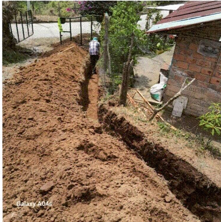
Imagen 3.- Inicio de excavación en zanja para posterior instalación de tubería de acueducto
