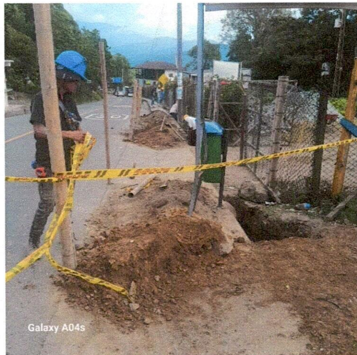
Imagen 18.- Excavación en zanja en andén de vía principal, sector Cielito Lindo
