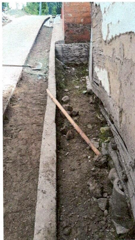
Imagen 6.- Demolición de pavimento rígido en Barrio Medellín
