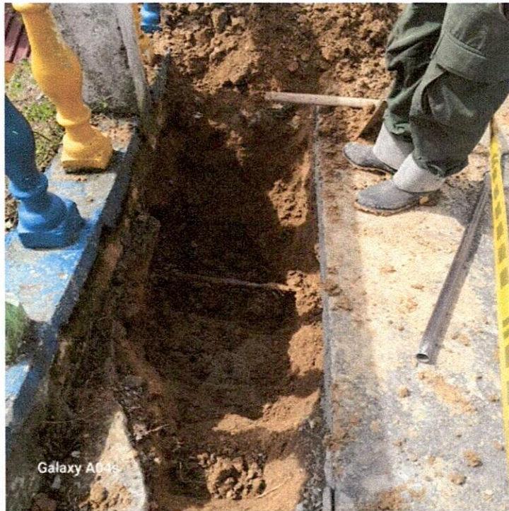
Imagen 17.- Excavación en zanja en andén de vía principal, sector Cielito Lindo
