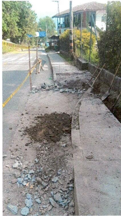
Imagen 11.- Demolición de estructuras en concreto para posterior instalación de tubería.
