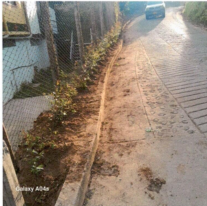
Imagen 13.- Lleno con material de sitio adyacente a placa huella en sector de Cielito Lindo
