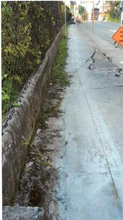
Imagen 12.- Demolición de estructuras en concreto para posterior instalación de tubería
