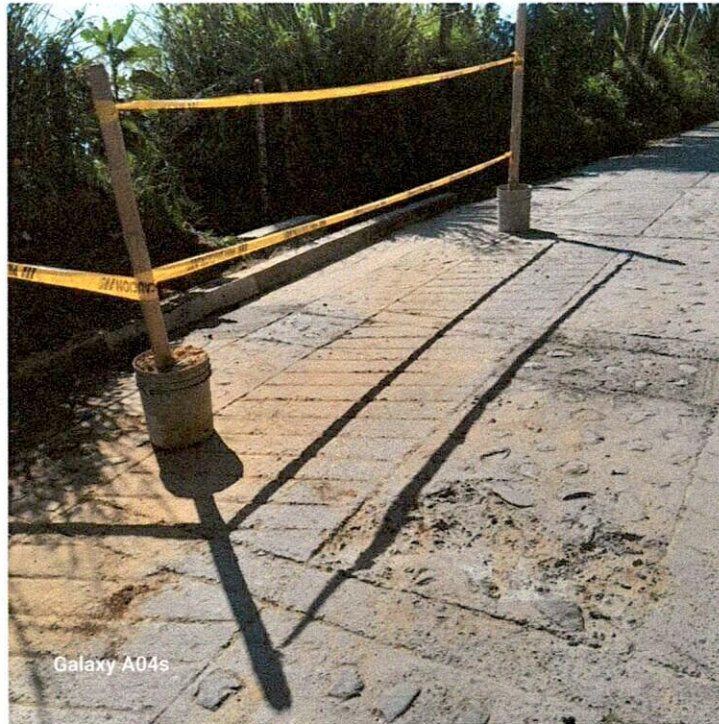
Imagen 21.- Instalación de concreto MR42 para reconstrucción de placa huella.
