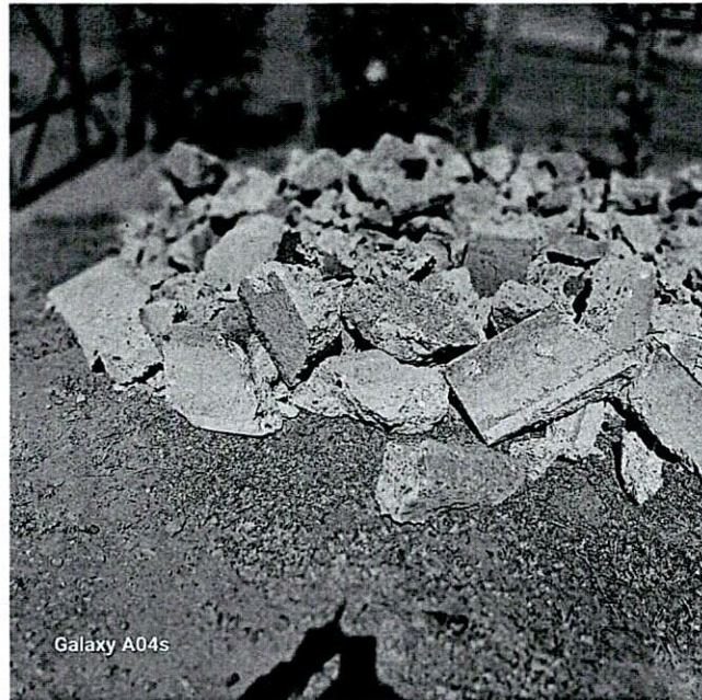
Zona de acopio de material proveniente de demolición para posterior retiro
