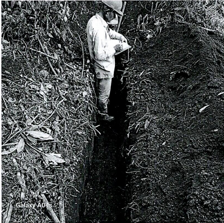
Inicio de actividades de excavación en sector de Cielito Lindo
