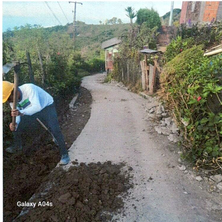
Imagen 7.- Inicio de actividades de excavación en zanja en barrio Medellín
