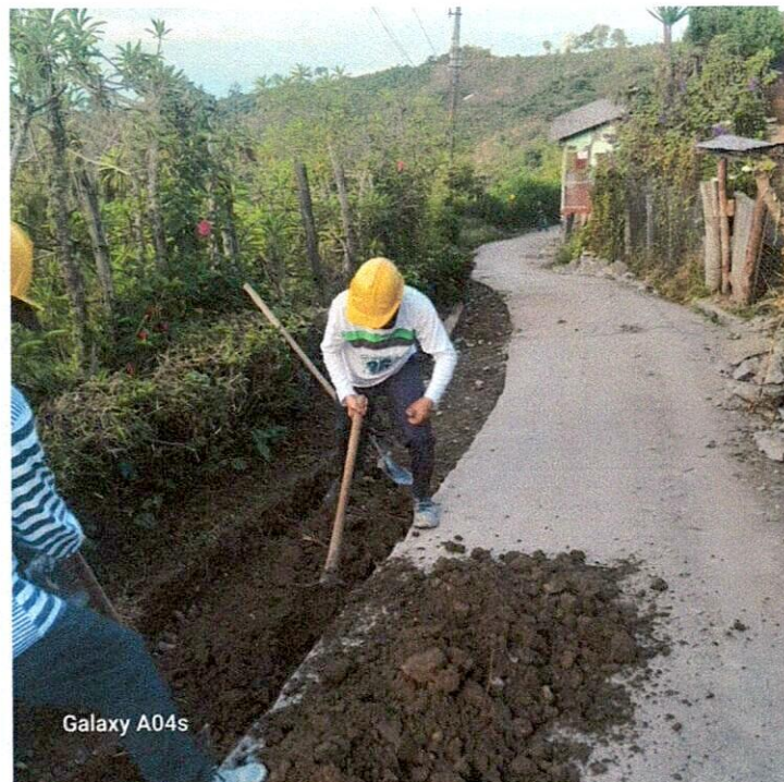
Imagen 8.- Inicio de actividades de excavación en zanja en barrio Medellín
