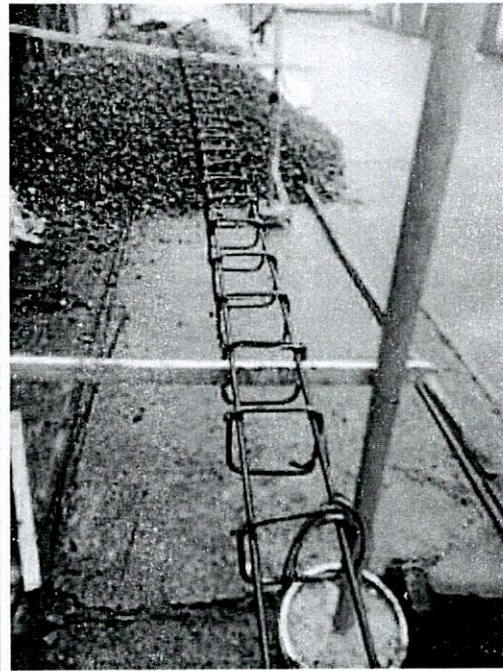
Refuerzo y material filtrante
