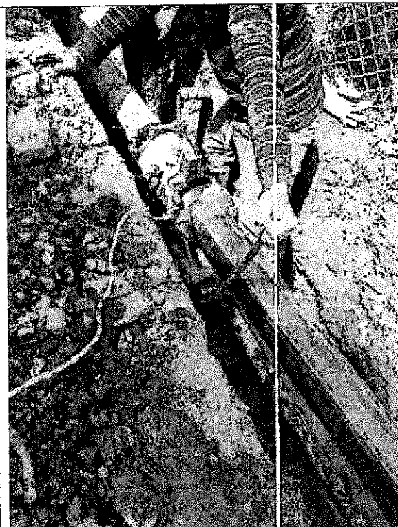
Reparación mediante termo fusión de tubería
