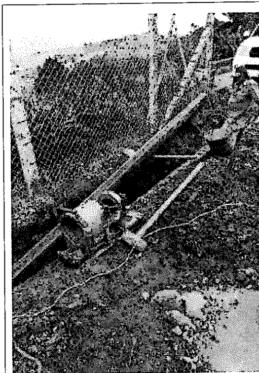
Reparación mediante termo fusión de tubería
