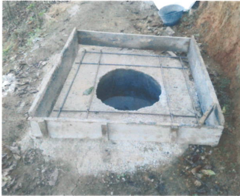
Suministro, Transporte e Instalación de Acero de Refuerzo de 1/4" a 1-1/4" de 420 MPA (4200 Kg/cm 2 ). Incluye sobre acarreo en vehículo y al hombro o mula.
