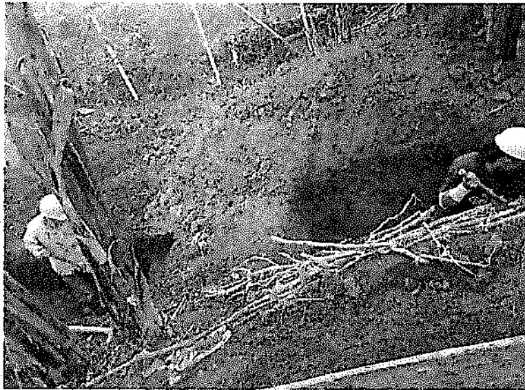
Excavacion en zanja conglomerado
