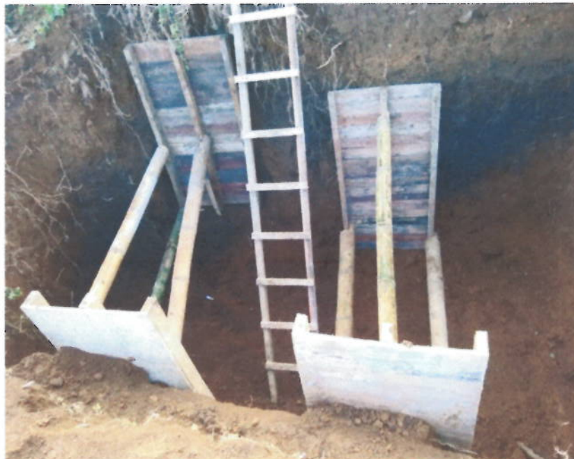
Excavación para Estructuras - Material Común - 2.0 a 4.0 m.
