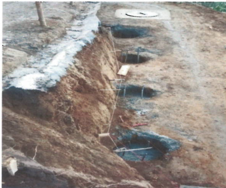
Pilotines en concreto. Diámetro 0.40 m. Incluye concreto f'c = 21 Mpa, Incluye Perforación y Refuerzo (10 Kg/ml)
