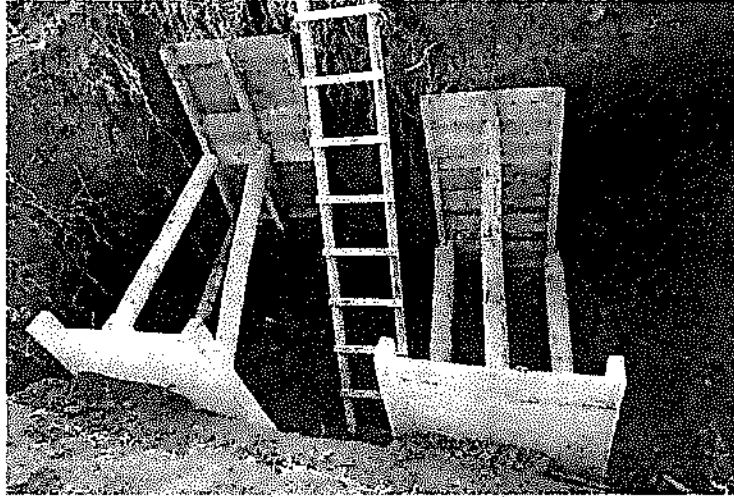
Excavación para Estructuras - Material Común - 2.0 a 4.0 m.
