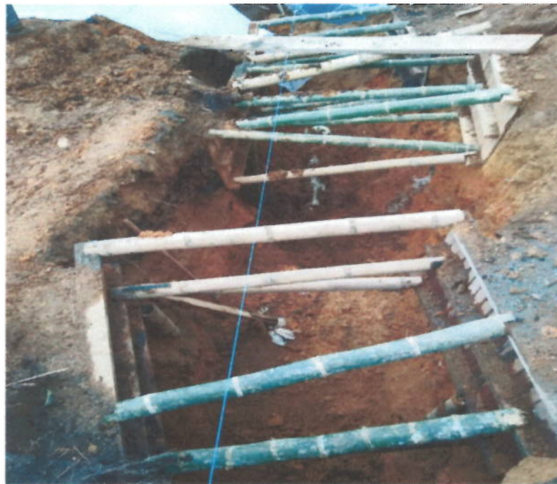
Tipo 1. Suministro, Transporte e Instalación de Apuntalamiento en Madera (Entibado Tipo 1)
