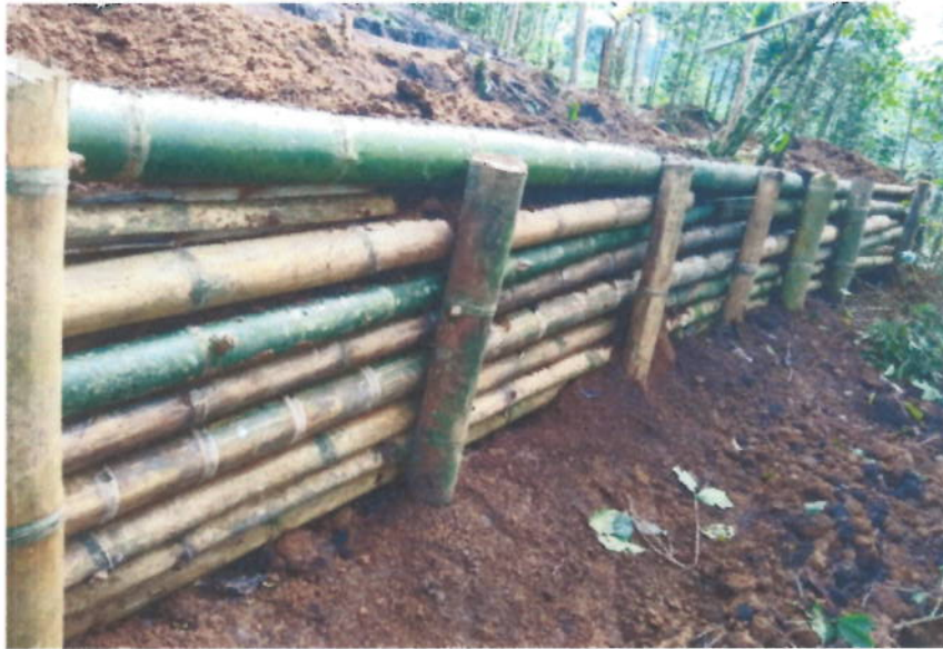
Construcción de trinchos provisionales para retención de material de excavación
