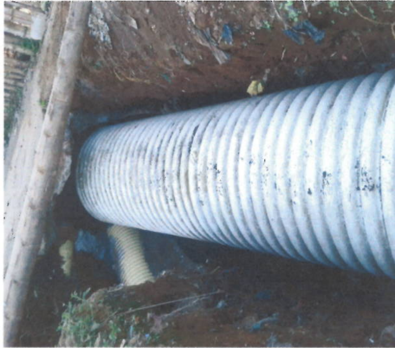
Transporte e Instalación Tubería PVC Corrugada de 30" para Alcantarillado. Incluye sobre acarreo en vehículo y al hombro o mula.
