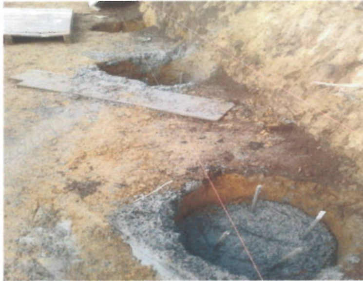
Localizacion y replanteo
