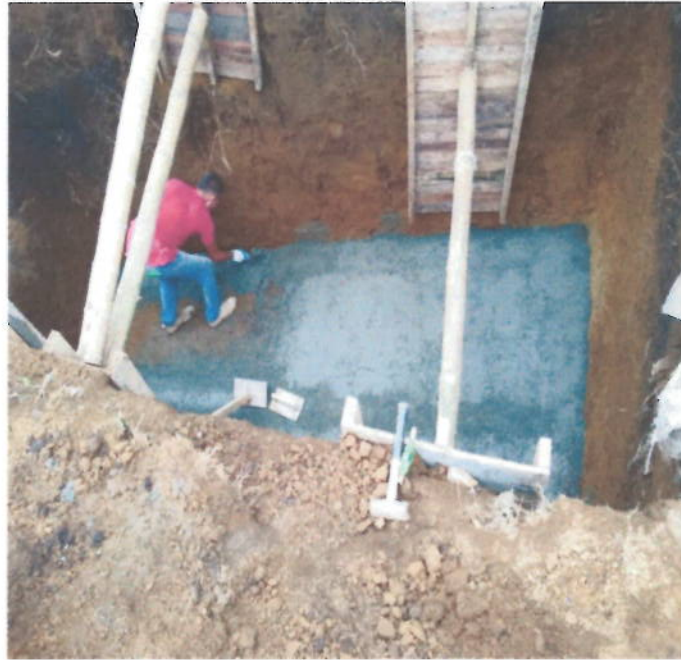
Suministro, transporte e instalación solado de limpieza 2.500 psi (17,5 Mpa) e = 5 cm.
