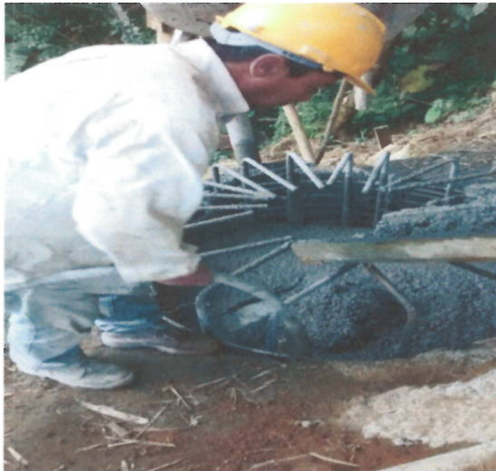
Suministro e instalación de Caissons D=1,5m en concreto de 3000 PSI 0-6M
