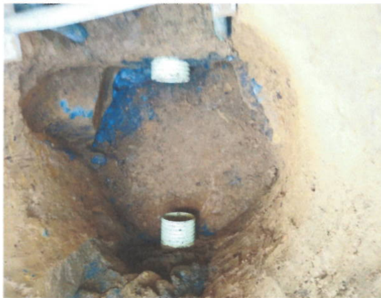
Excavacion para camaras.
