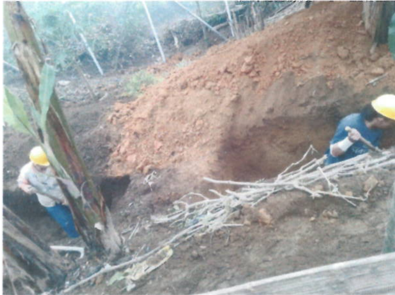
Excavacion en zanja conglomerado
