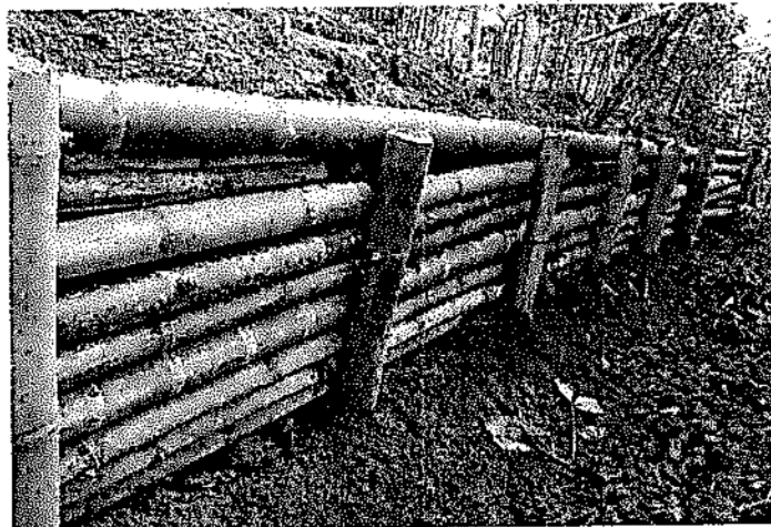
Construcción de trinchos provisionales para retención de material de excavación
