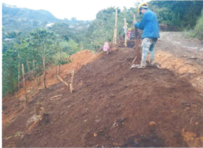
Relleno en Material Seleccionado Proveniente de la Excavación Compactado.
