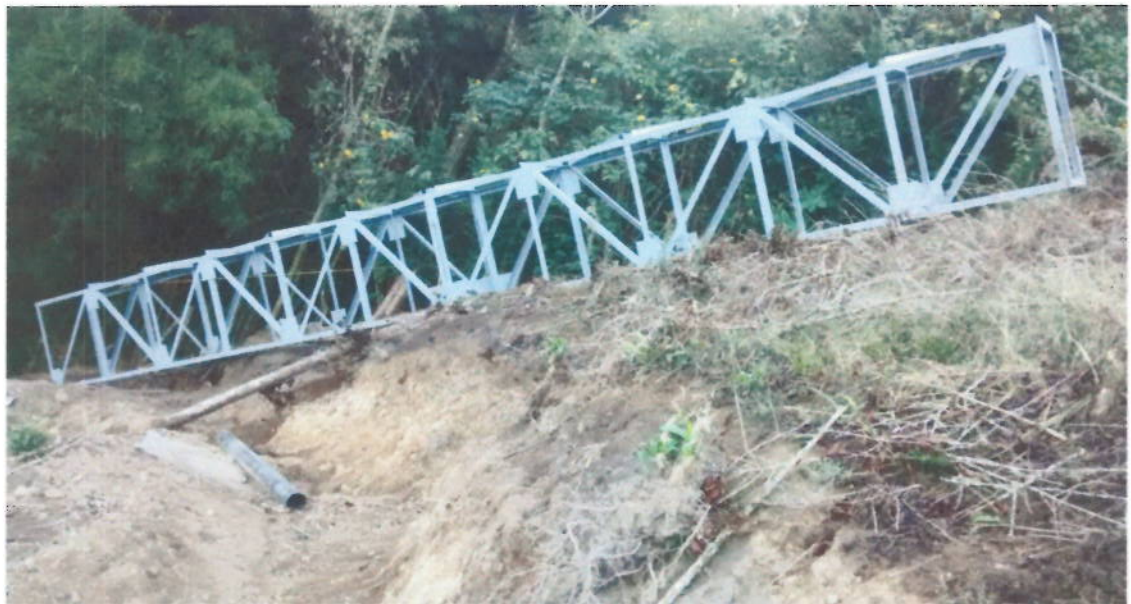
Suministro, Transporte e Instalación Estructura metálica para viaducto.
