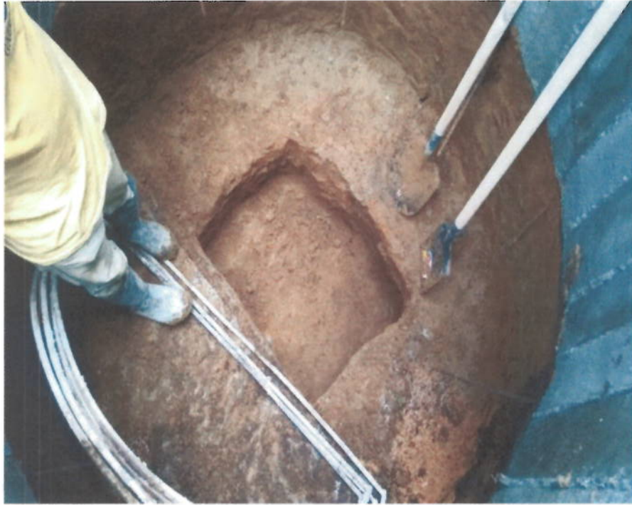
Excavación para Caisson en tierra 0-6m
