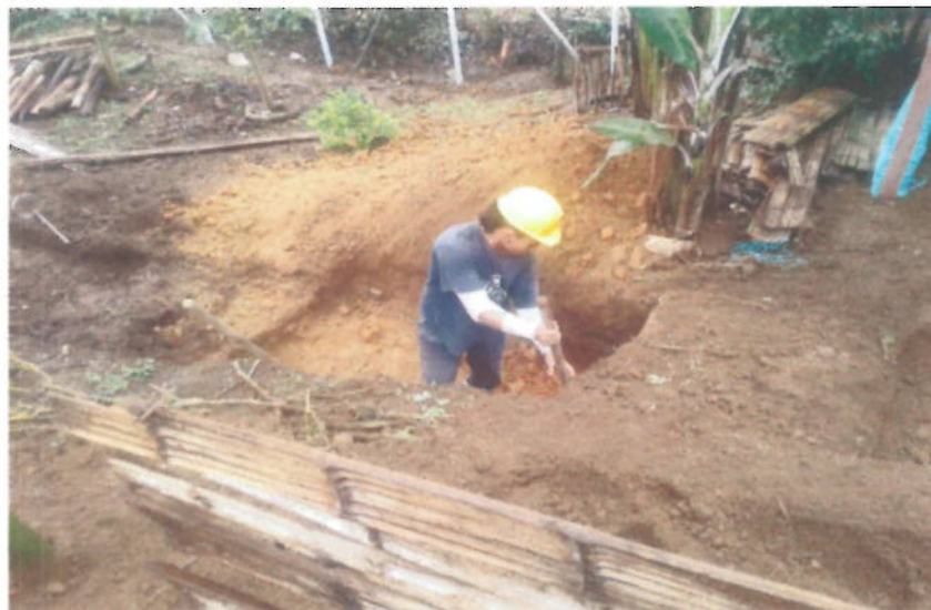
Excavacion en zanja
