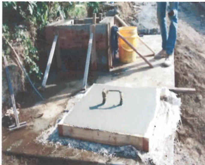
Suministro, Transporte e Instalación de Tapa para Caja en Concreto de 21 Mpa
