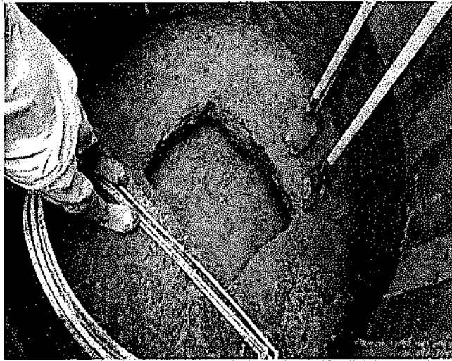
Excavación para Caisson en tierra 0-6m
