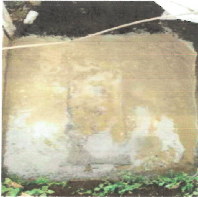
concreto para recalce sector la gruta.
