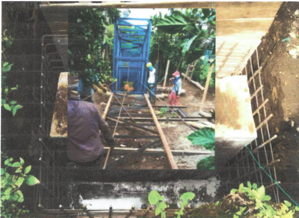
Hierro de refuerzo para recalce sector la gruta
