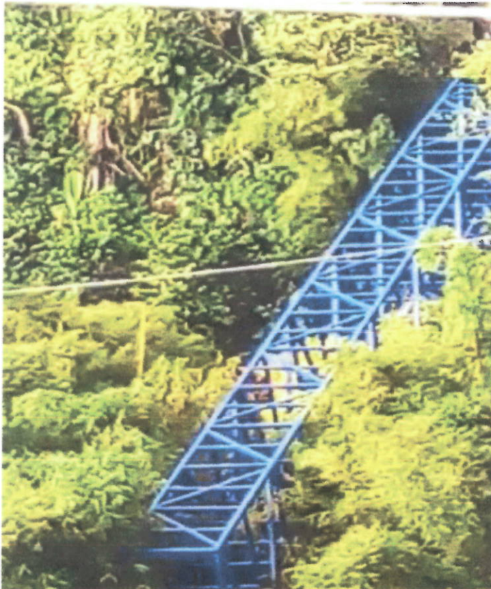
Viaducto sector la Gruta en proceso de instalación
