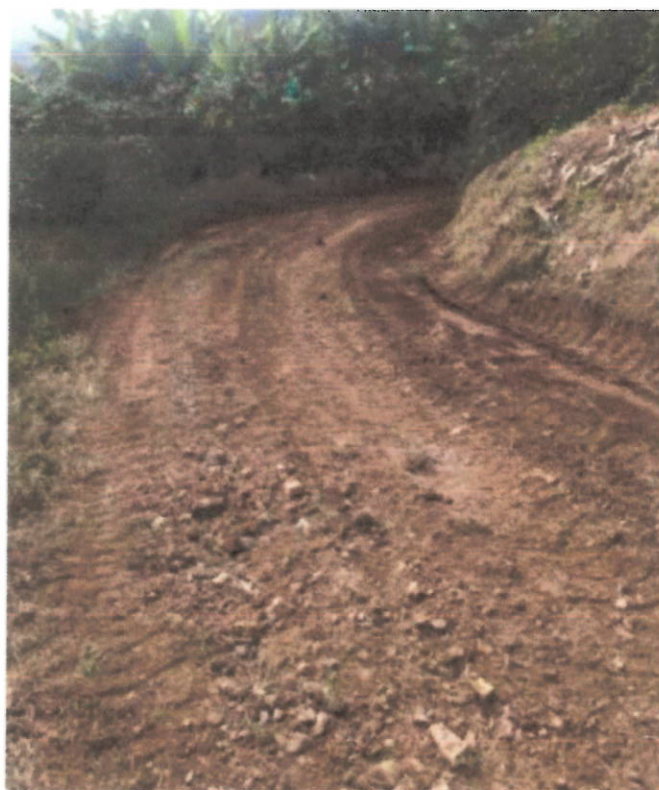
Suministro e instalación de afirmado vereda Pisamo
