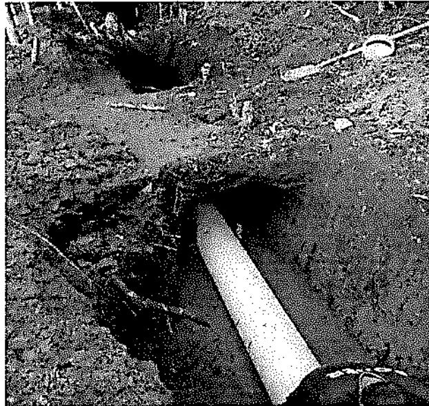
Instalación de tubería 12" red principal con base en arena
