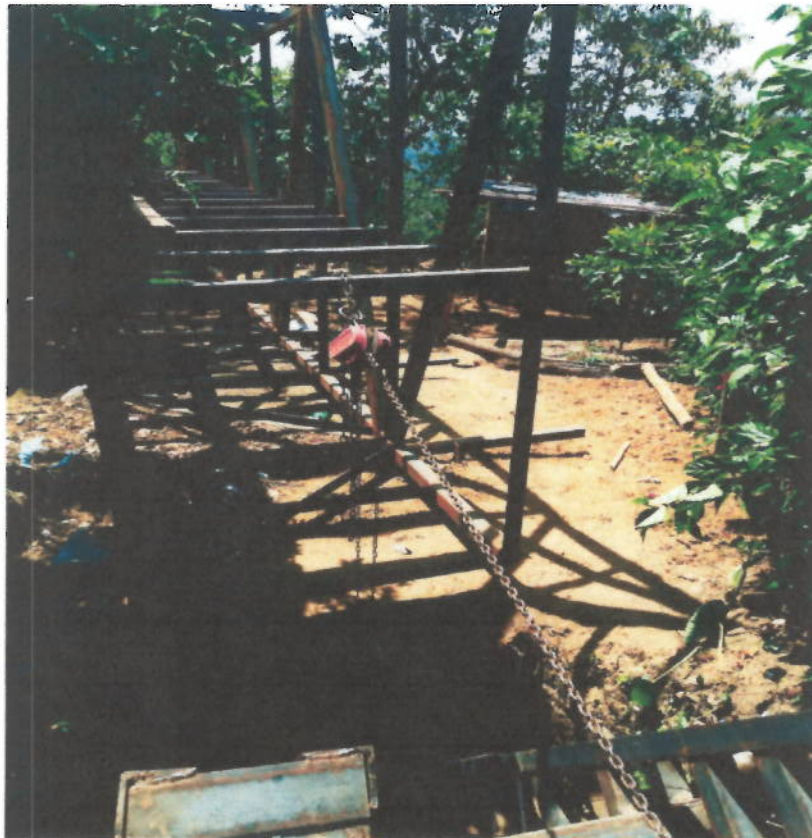
Instalación de viaducto de 62 ml mediante anclajes en concreto, diferenciales y cadenas para su desplazamiento
