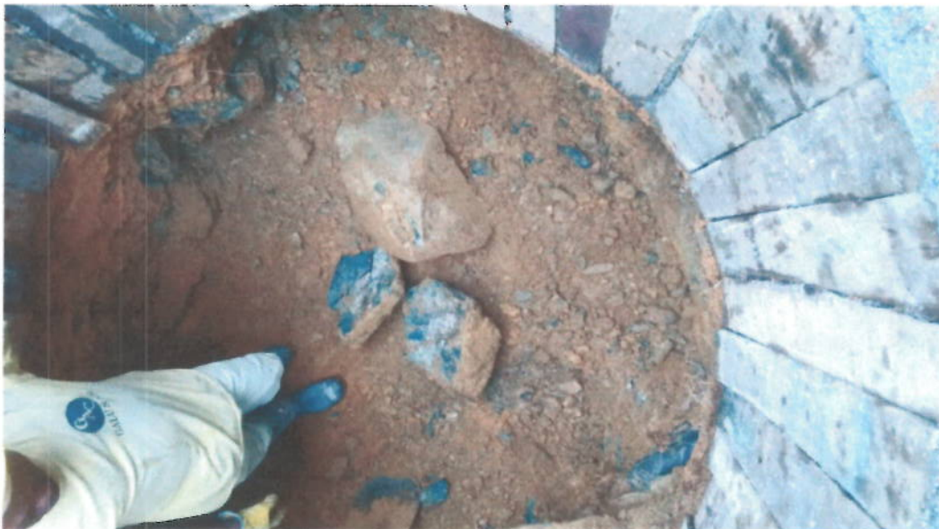
Construcción de caisson d=1.5 m para apoyo de viaducto de 32 m, excavaciones en material rocoso.
