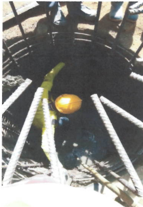
Vaciado de Caisson para soporte de estructuras de soporte de viaducto de 32 m
