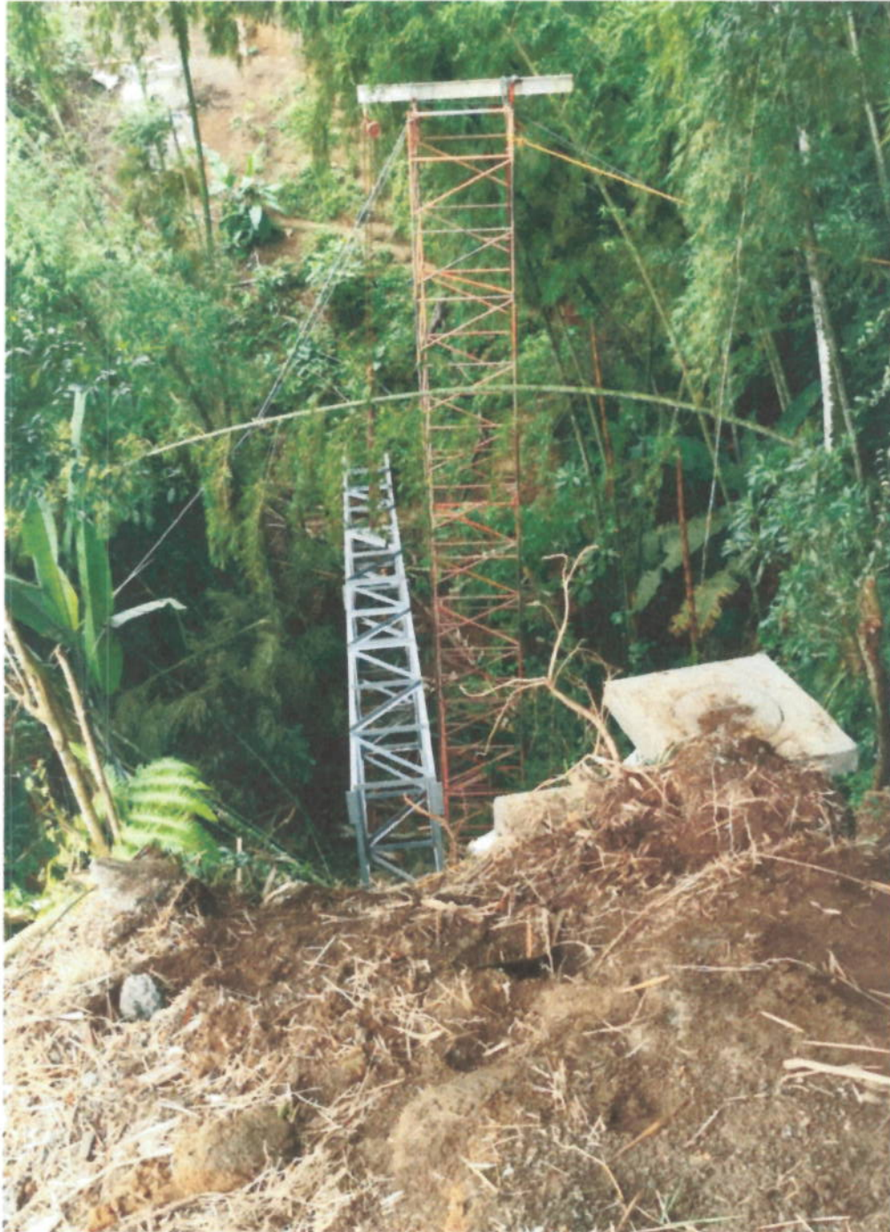
Instalación de viaducto de 32 ml mediante anclajes en concreto, diferenciales y cadenas para su desplazamiento
