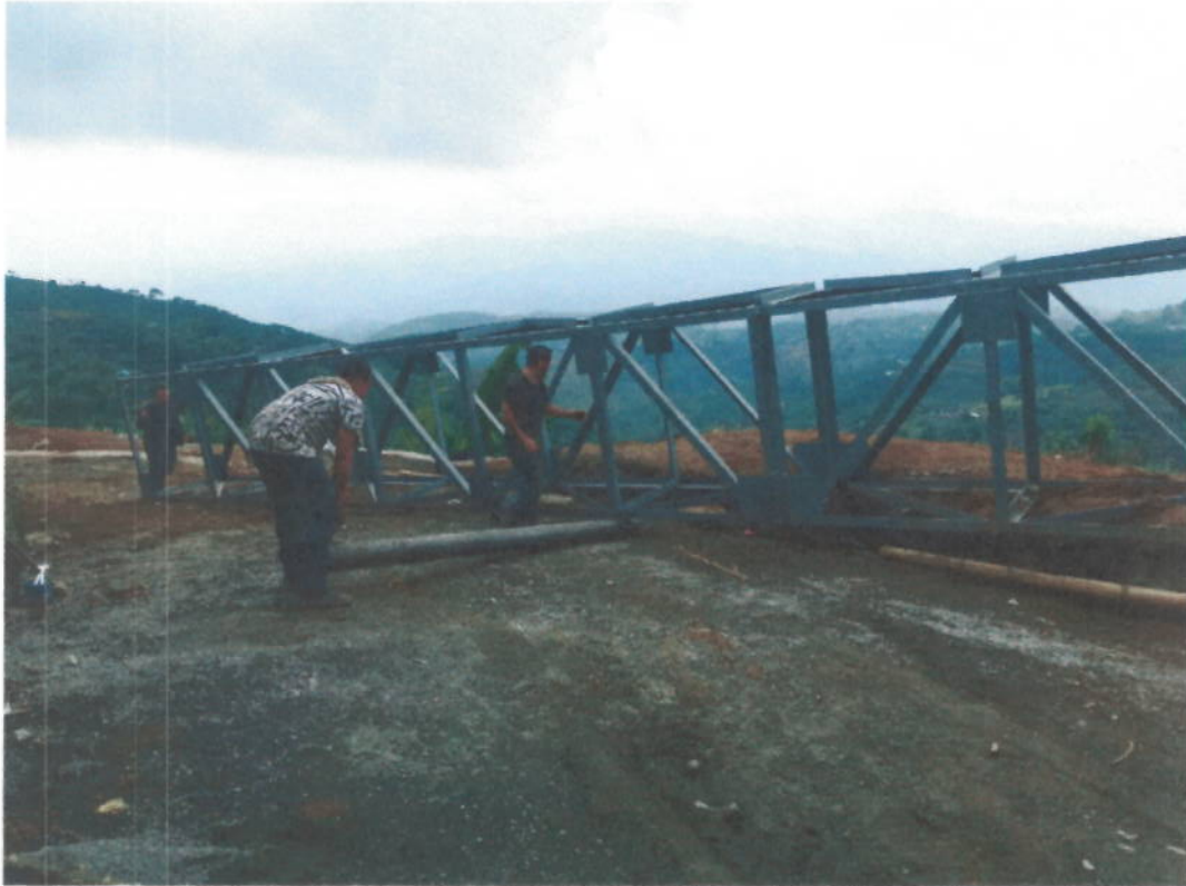
Transporte de viaducto de 32 ml.
