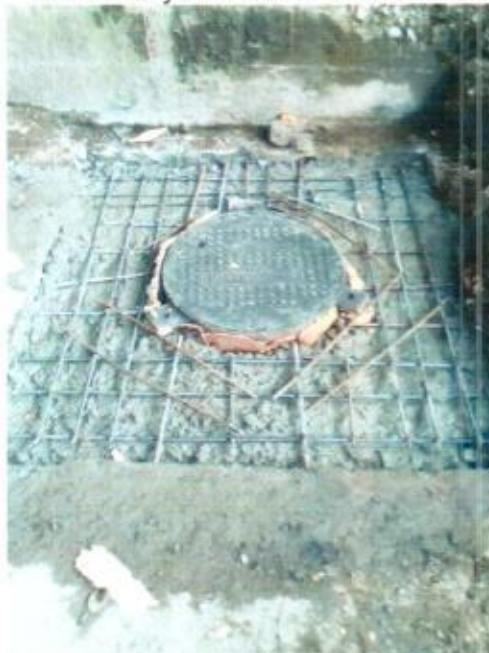
Instalacion tapas camaras de inspección – colocación acero de refuerzo
