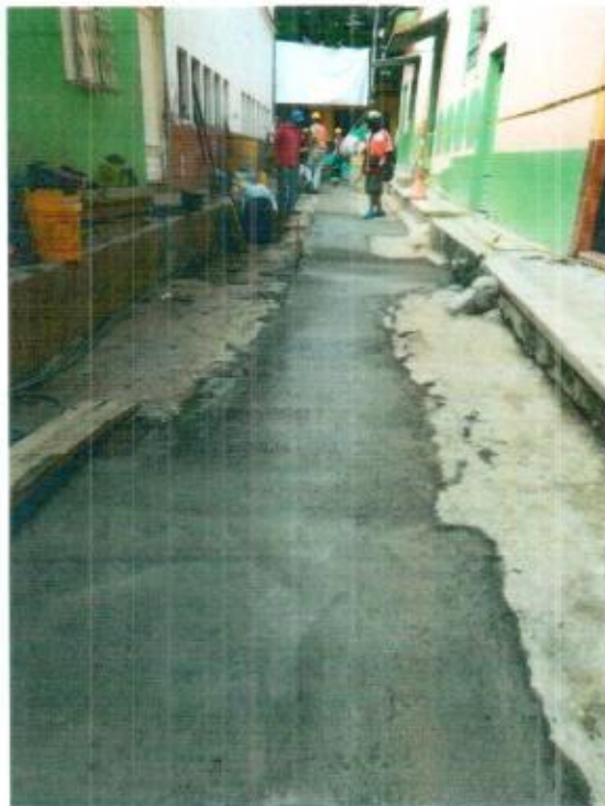
Pavimentación parcheo área afectada reposición alcantarillado
