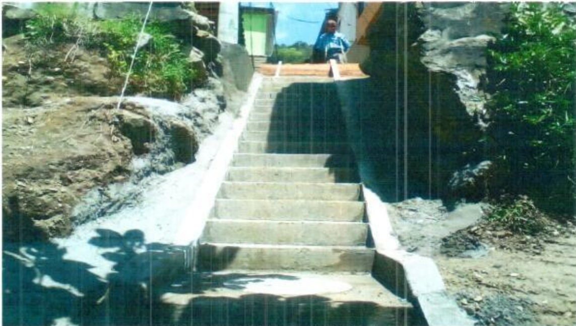
ESCALAS EN CONCRETO TERMINADAS
