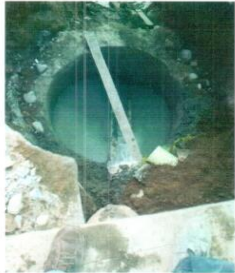
Vaciado bases y cañuelas
