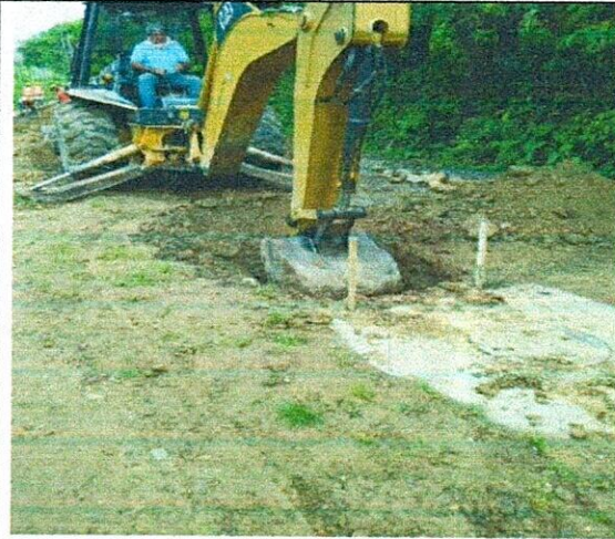
FOTO 5. Excavación en zanja - Material común
