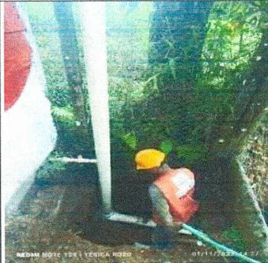
FOTO 14. Instalación Tubería Acueducto
