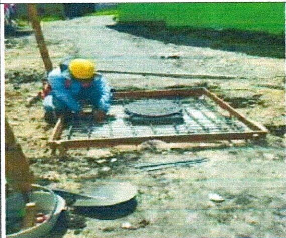
FOTO 7. Losa superior de pozo de inspeccion
