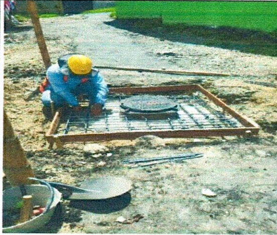
FOTO 9. Instalación de hierro para losa superior de los pozos de inspección
