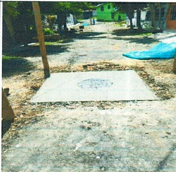
FOTO 7. Losa superior de pozo de inspeccion
