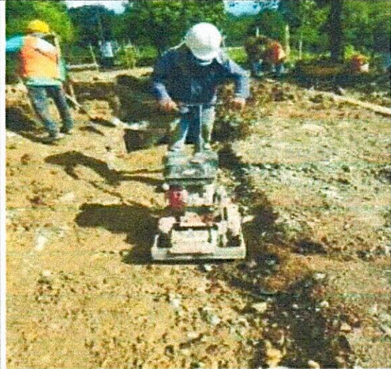
FOTO 12. Rellenos compactados con material de la obra.
