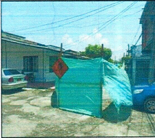
FOTO 3. Suministro, transporte e instalación señales preventivas.
