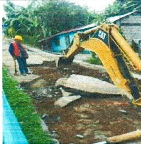
FOTO 4. Demolición de pavimento en concreto hidráulico
