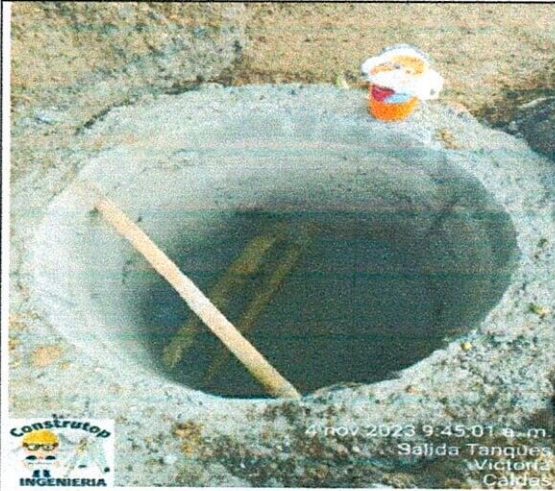
FOTO 13. Cámara de caída D=1.5, H<3,04
