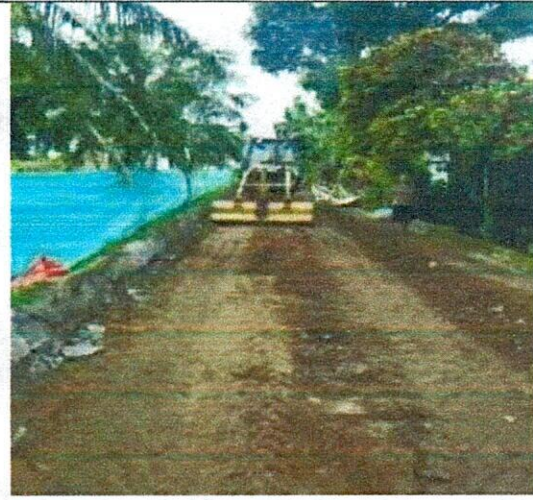
FOTO 6. Excavación en zanja - Material común
