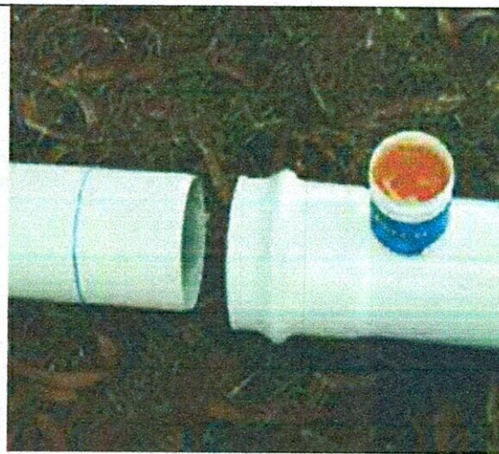
FOTO 14. Empalme tubería acueducto
