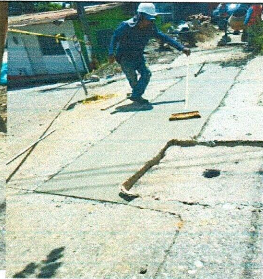
FOTO 8. Instalación de pavimento MR 41
