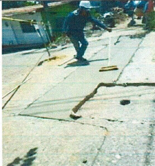
FOTO 8. Instalación de pavimento MR 41
