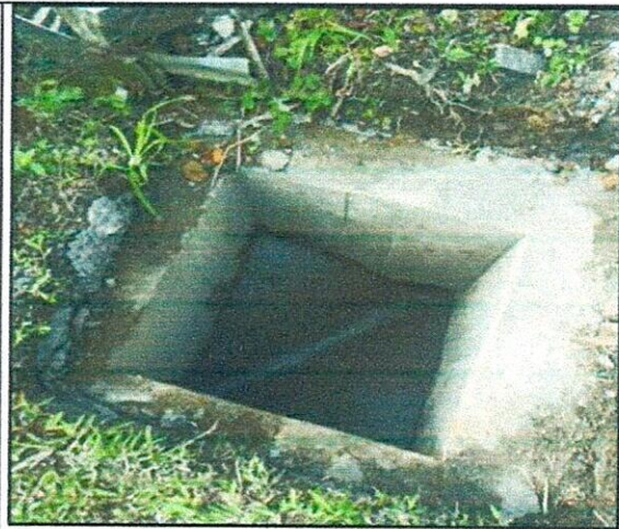
FOTO 10. Caja de inspección domiciliar de 0,50m x 0,50m.
