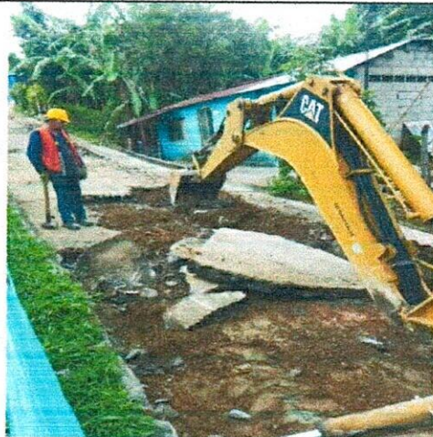
FOTO 4. Demolición de pavimento en concreto hidráulico
