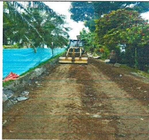
FOTO 6. Excavación en zanja - Material común
