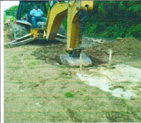
FOTO 5. Excavación en zanja - Material común
