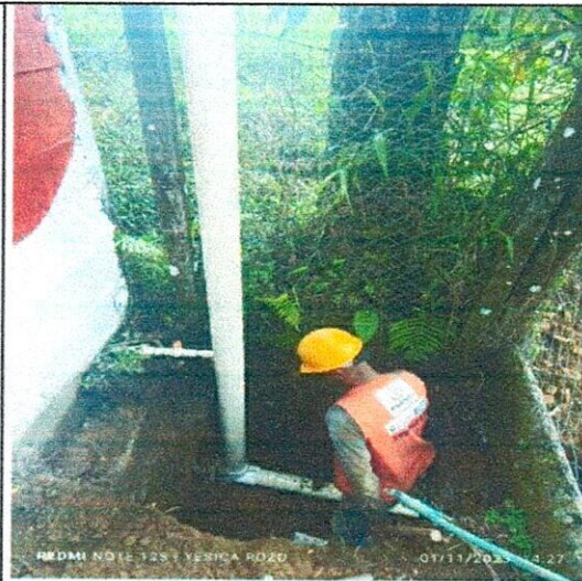
FOTO 14. Instalación Tubería Acueducto
