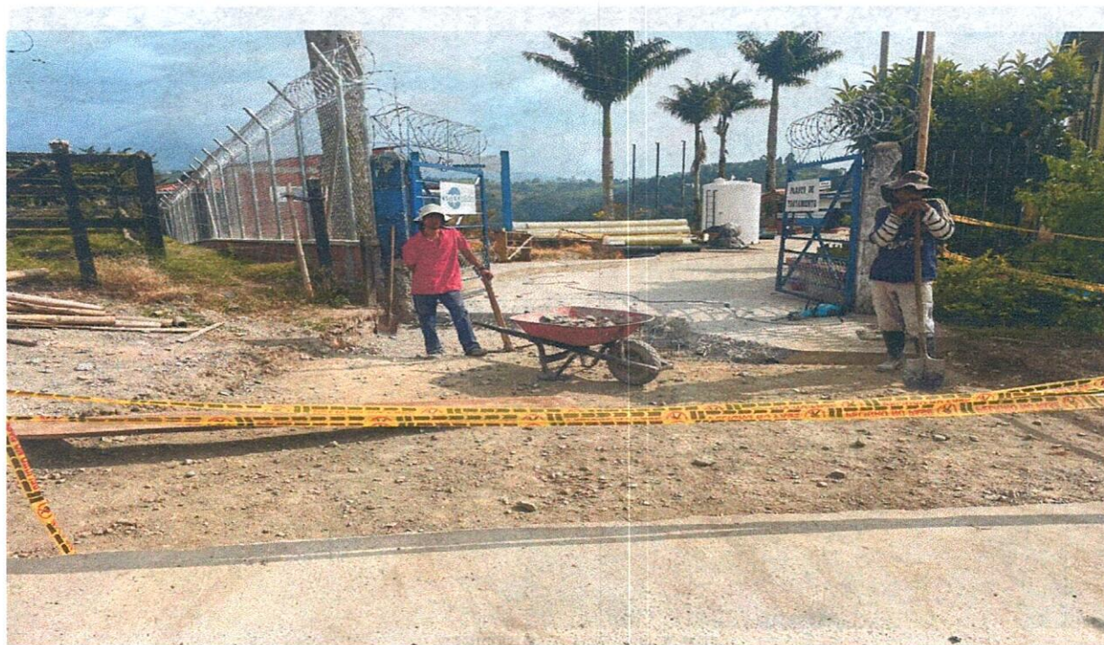
DEMOLICIÓN PUERTA PRINCIPAL
