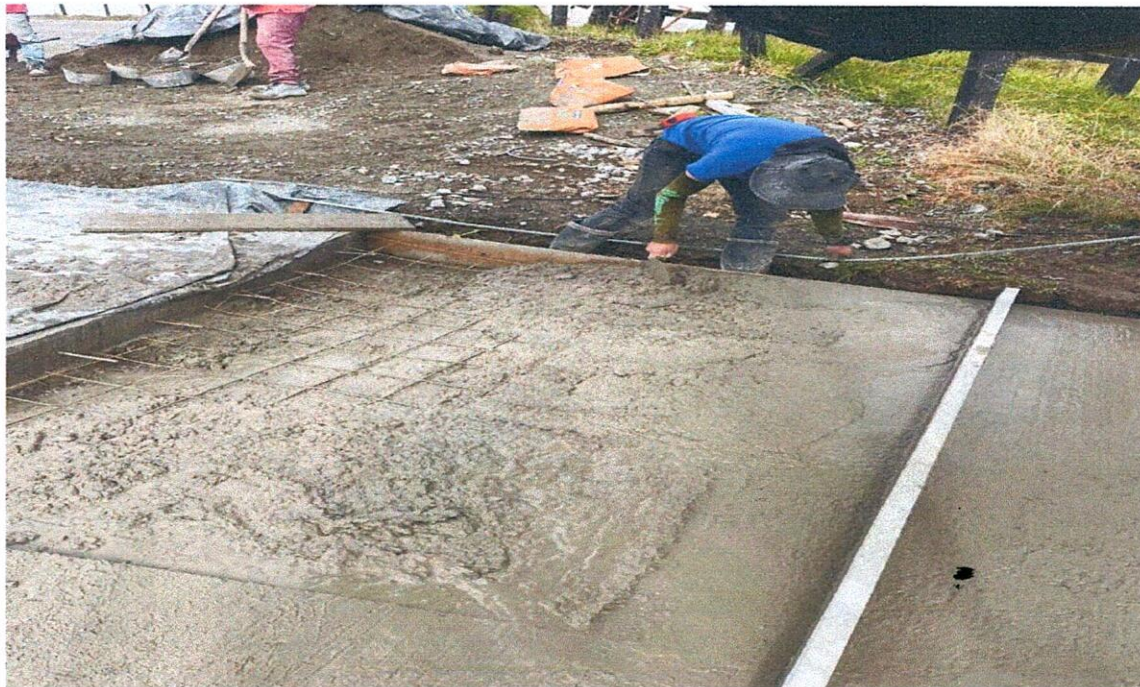
CONCRETO PARA REPOSICIÓN DE ENTRADA PRINCIPAL
