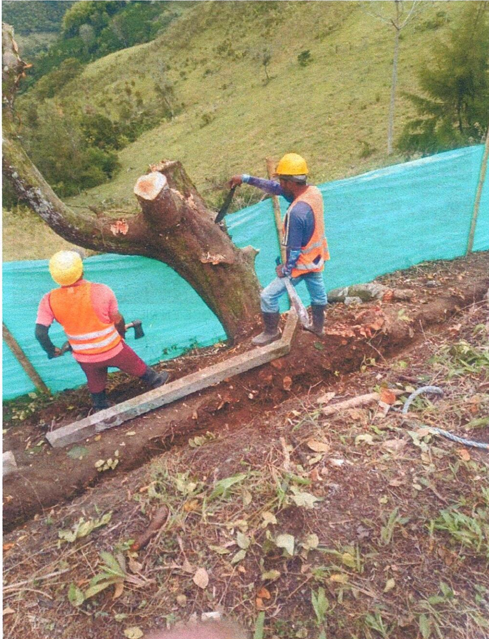
ERRADICACIÓN DE ÁRBOL - MANO DE OBRA TALA Y DESTROCE
