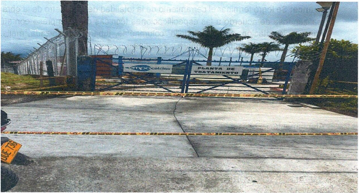
TERMINADO FINAL PUERTA PRINCIPAL
