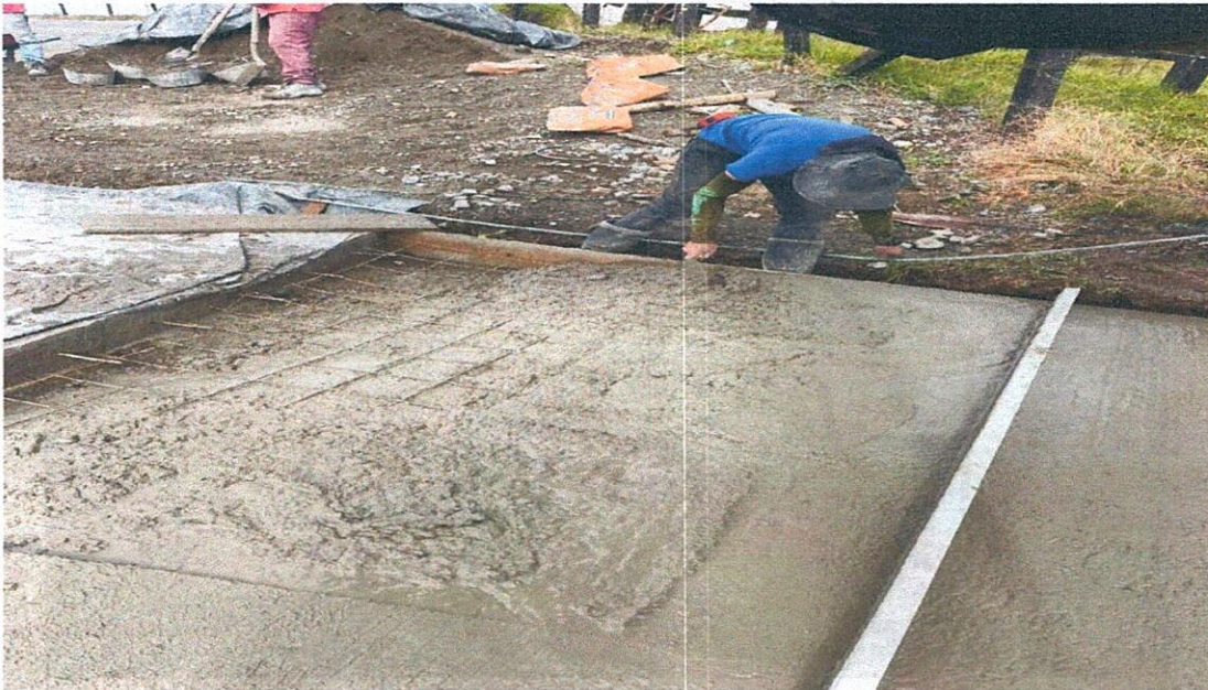
CONCRETO PARA REPOSICIÓN DE ENTRADA PRINCIPAL
