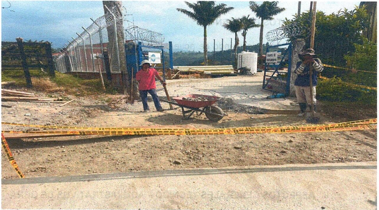
DEMOLICIÓN PUERTA PRINCIPAL
