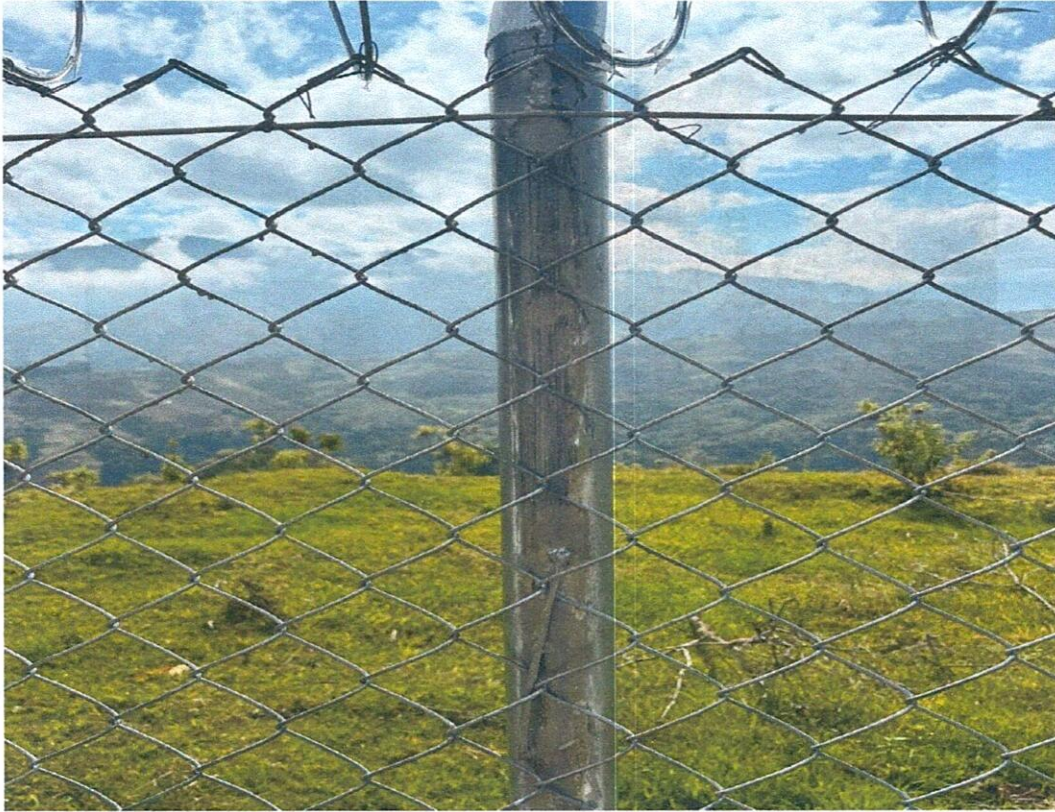
CERRAMIENTO EN MALLA ESLABONADA
