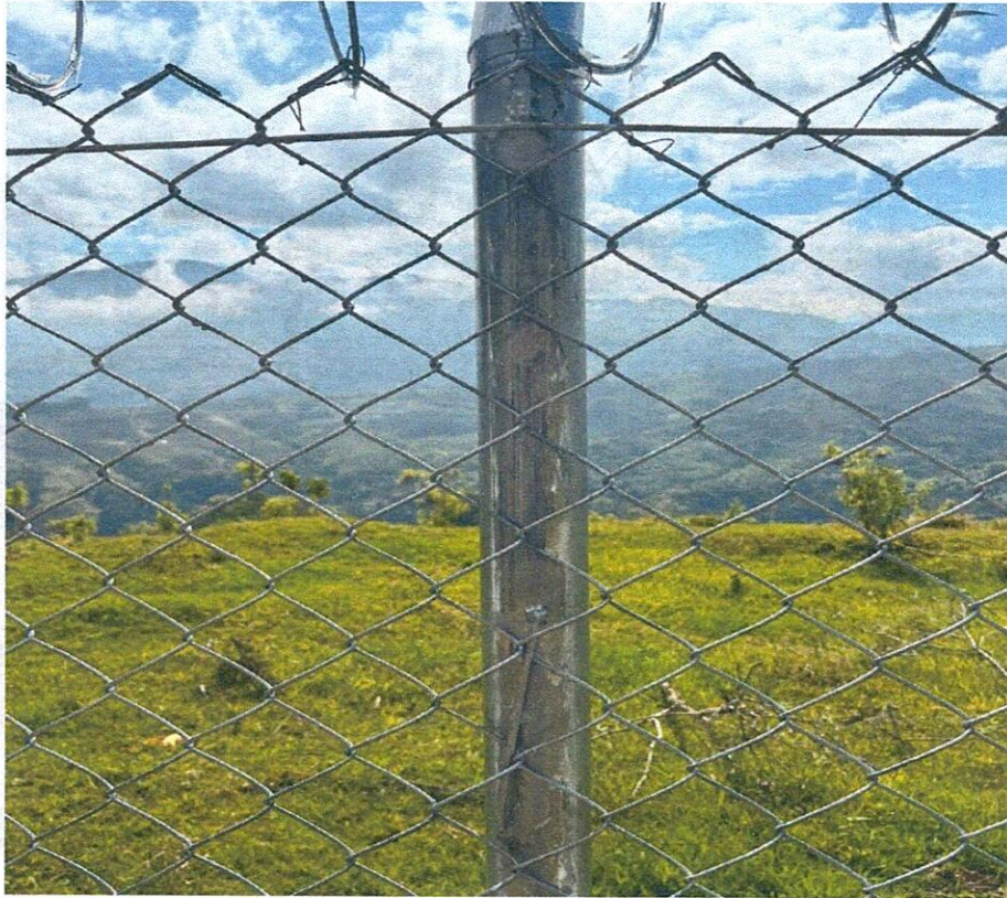
CERRAMIENTO EN MALLA ESLABONADA
