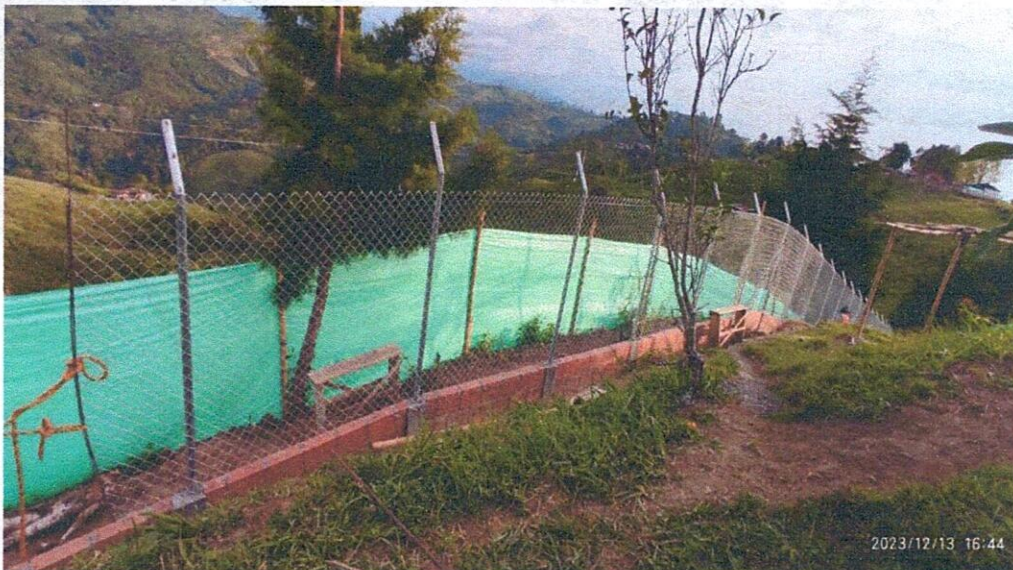
CERRAMIENTO DE TODO EL PERÍMETRO
