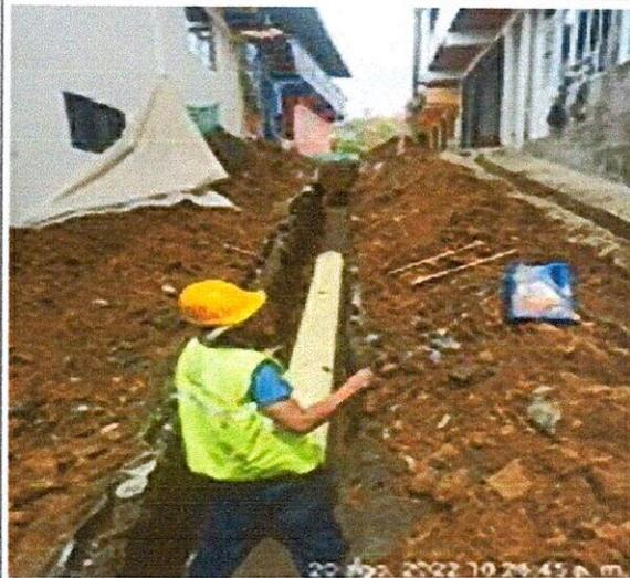
**FOTO 6.** Instalación de tubería PVC corrugada  $\Phi=12''$
