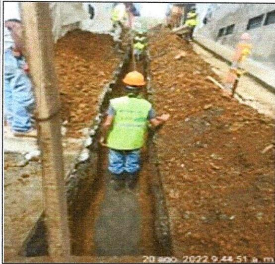
**FOTO 5.** Sustitución en arena limpia para tuberías
