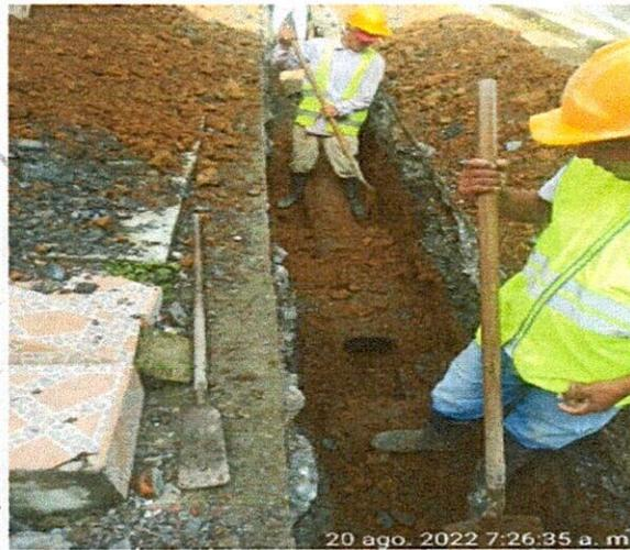
**Sustitución en arena limpia para tuberías**
