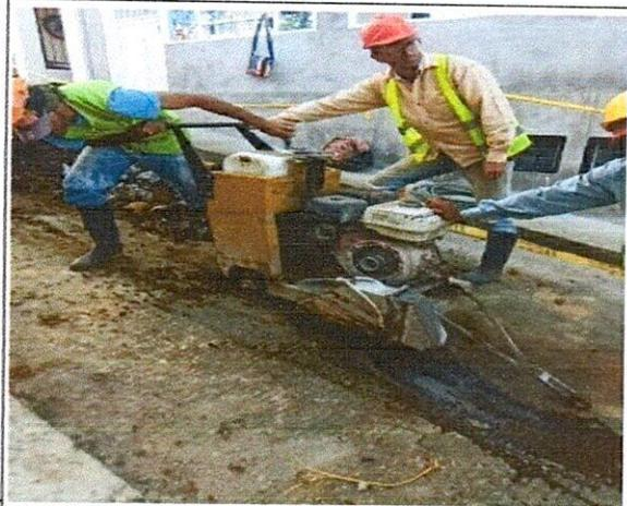
FOTO 2. Corte mecánico de pavimento
