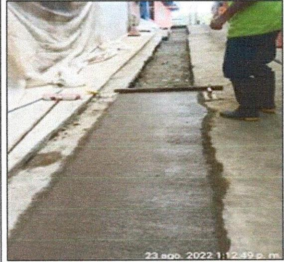
**FOTO 8.** Pavimento en concreto MR 41 para vías
