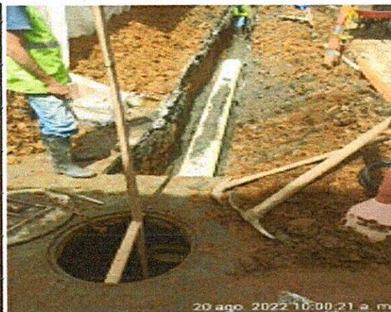
**Instalación de tubería PVC corrugada  $\Phi=12"$**
