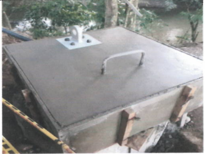
DADO FUNDIDO CONCRETO DE MR 4,2
