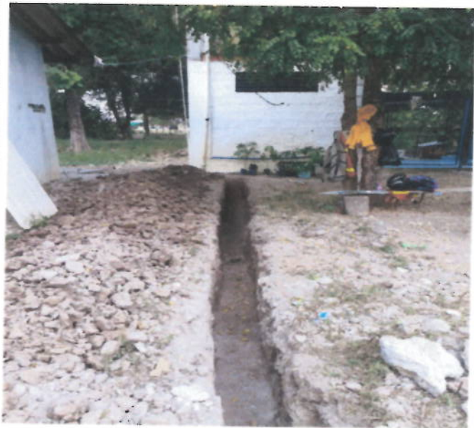
EXCAVACION PARA ACOMETIDA COLEGIO EL JAPON
