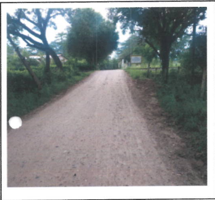
ESTADO INICIAL CRUCE PERFORACION DIRIGIDA VIA FERREA
