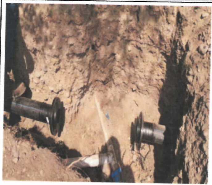
TERMOFUSION DE PORTAFLANCHES DE 4" PARA INSTALADA DE VALVULA Y MACROMEDIDOR
