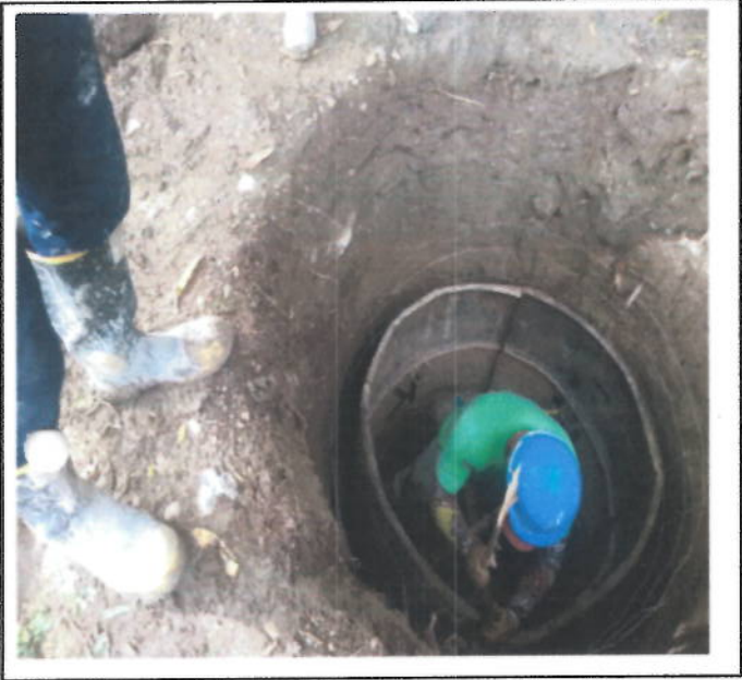
CONSTRUCCION DE ANILLOS PARA CAISSON
