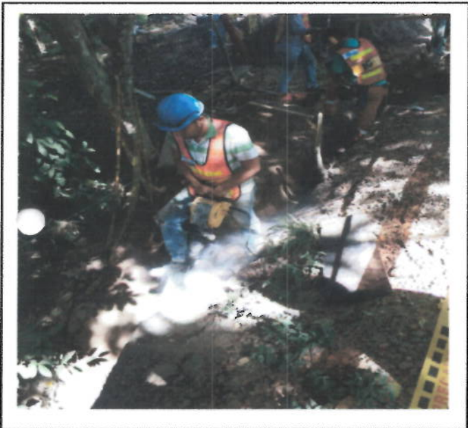
DEMOLICION ROCA EN BRECHA CON EQUIPO MECANICO
