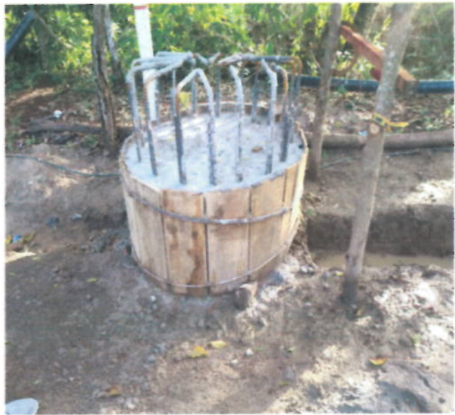
ESTRUCTURA CAISSON FUNDIDO
