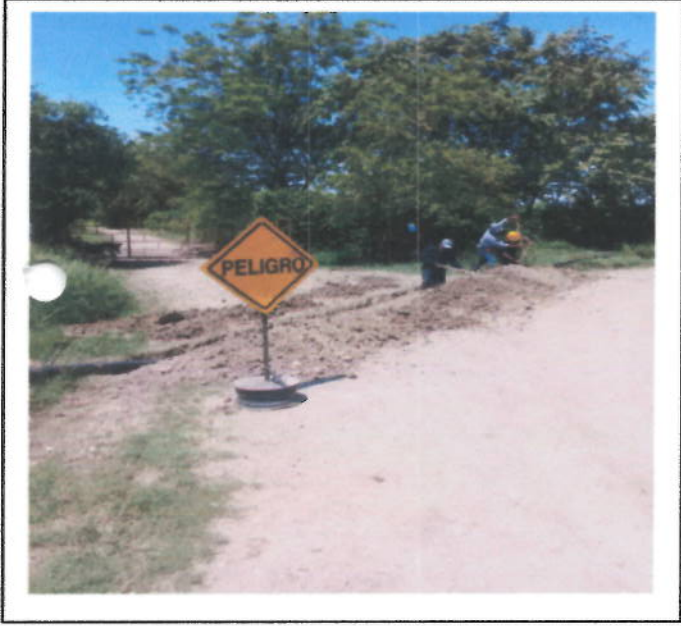
EXCAVACION MANUAL CRUCES DE VIA
