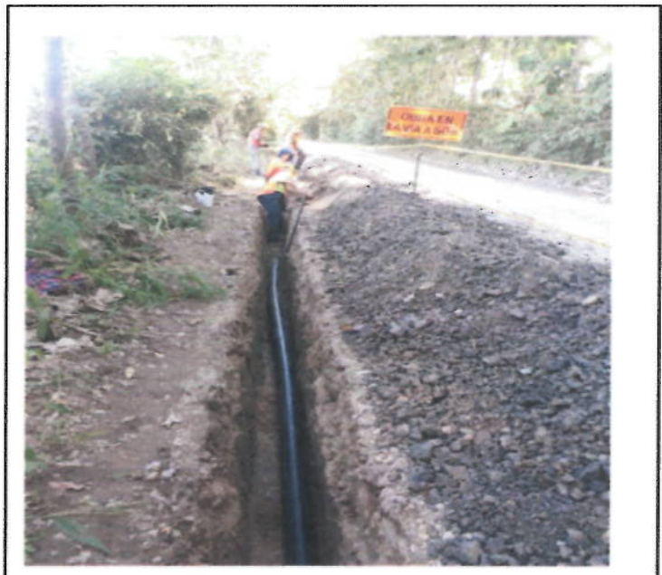
INSTALACION MANGUERA EN RECHA
