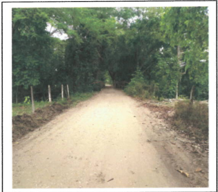
ESTADO INICIAL DE LA VIA
