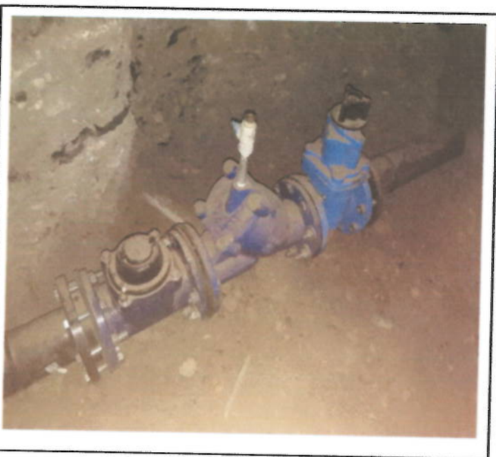
INSTALADA DE VALVULA, FILTRO EN Y, MACROMEDIDOR
