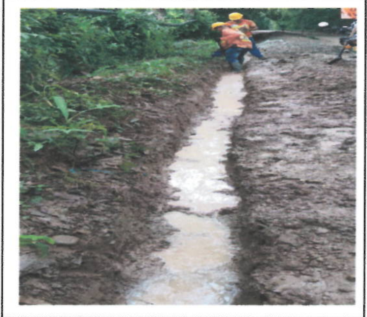
EXCAVACION MANUAL PARA INSTALACION DE MANGUERA PF DE 4"
