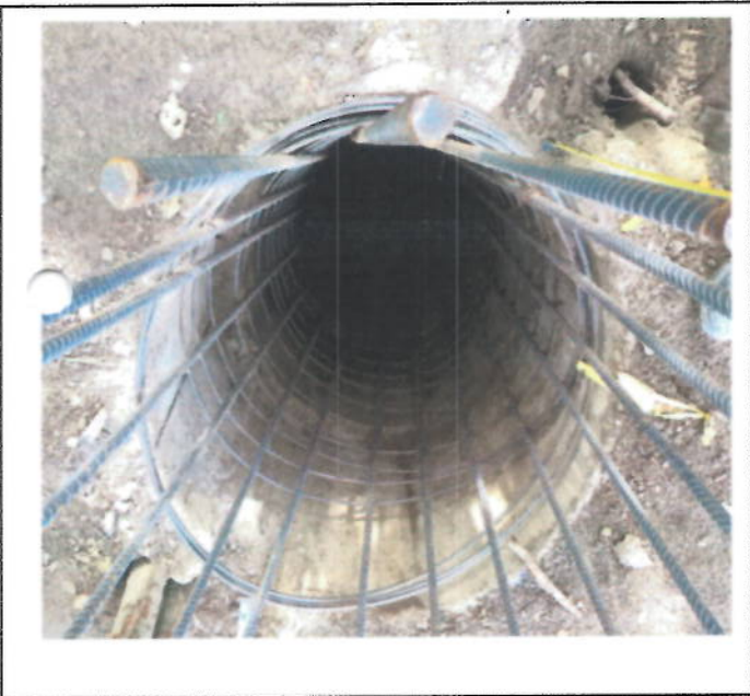
ACERO DE REFUERZO CANASTA CAISSON
