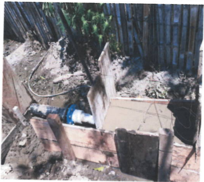
ANCLAJE TUBERIA PVC DE 3"
