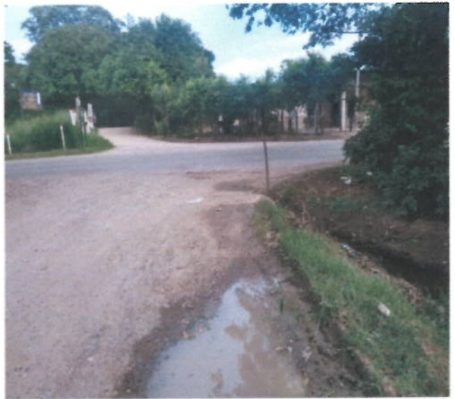
ESTADO INICIAL CRUCE PERFORACION DIRIGIDA VIA DEPARTAMENTAL HACIA NORCASIA
