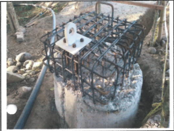
ACERO FIGURADO PARA MUERTO CAISSON
