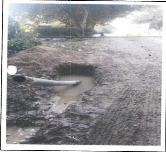
EXTREMO DE LA PERFORACION DIRIGIDA LADO DE LA VIA FERREA
