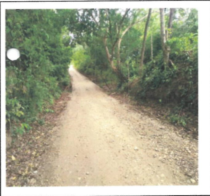
ESTADO INICIAL DE LA VIA
