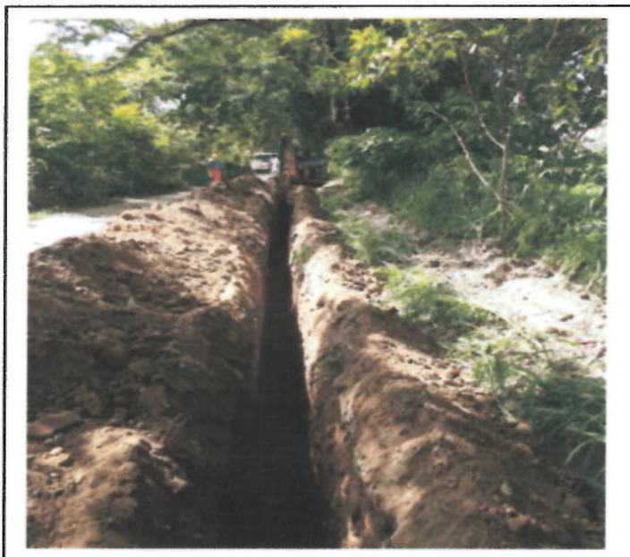
EXCAVACION BRECHA REALIZADA A MAQUINA
