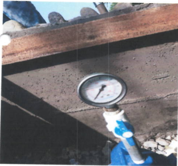
PRUEBA DE ESTANQUEIDAD DE TUBERIA PF 4"
