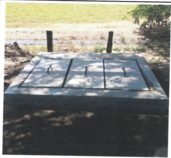
CAJA PARA MACROMEDIDOR TERMINADA
