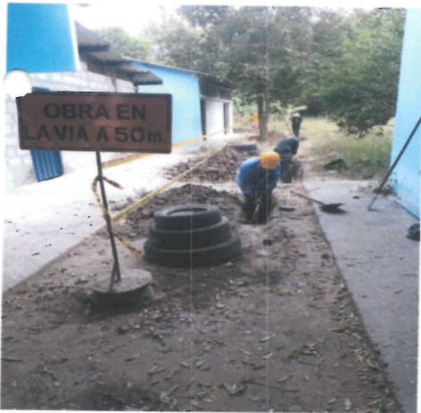
EXCAVACION PARA ACOMETIDA COLEGIO EL JAPON
