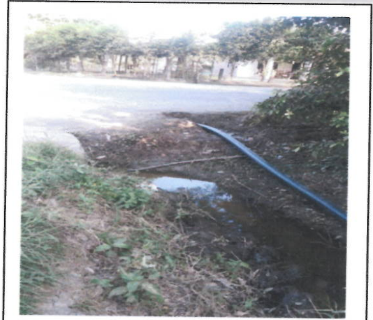
EXTREMO DE LA PERFORACION DIRIGIDA LADO DE LA VIA DEPARTAMENTAL
