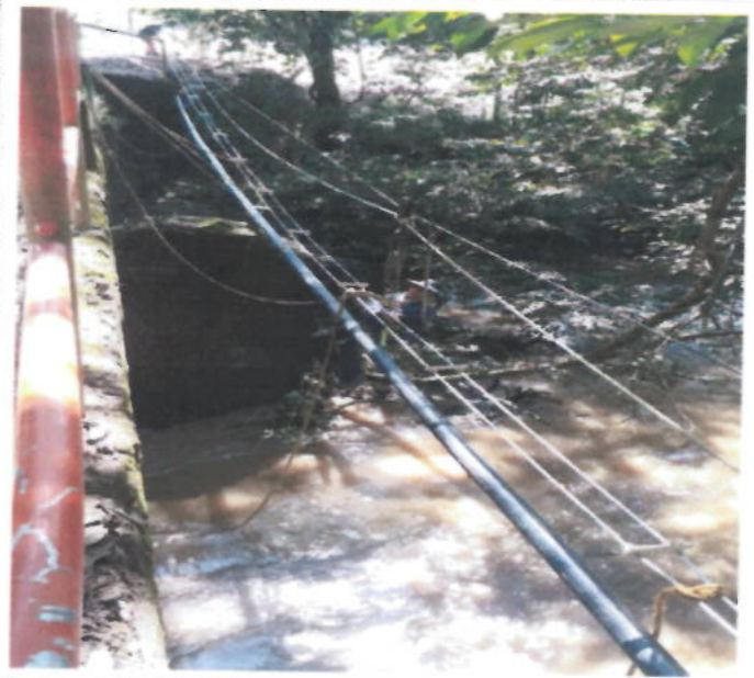
TRABAJO EN ALTURAS VIADUCTOS
