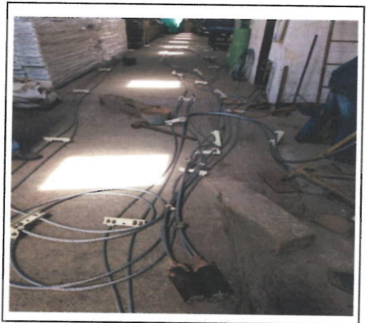
TRABAJO EN TALLER PARA ARMADO DE CABLES PARA LOS VIADUCTOS
