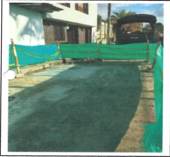
LOSA FUNDIDA CON TAPA HF
