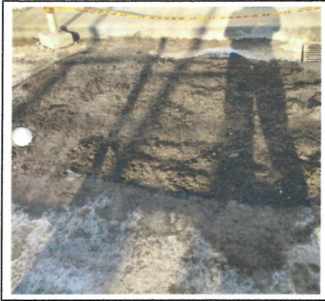
SUMINISTRO E INSTALACION DE SUBBASE
