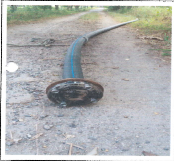
BRIDA CIEGA INSTALADA AL FINAL DEL ACUEDUCTO
