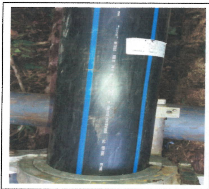
TRAZABILIDAD DE LA TUBERIA INSTALADA
