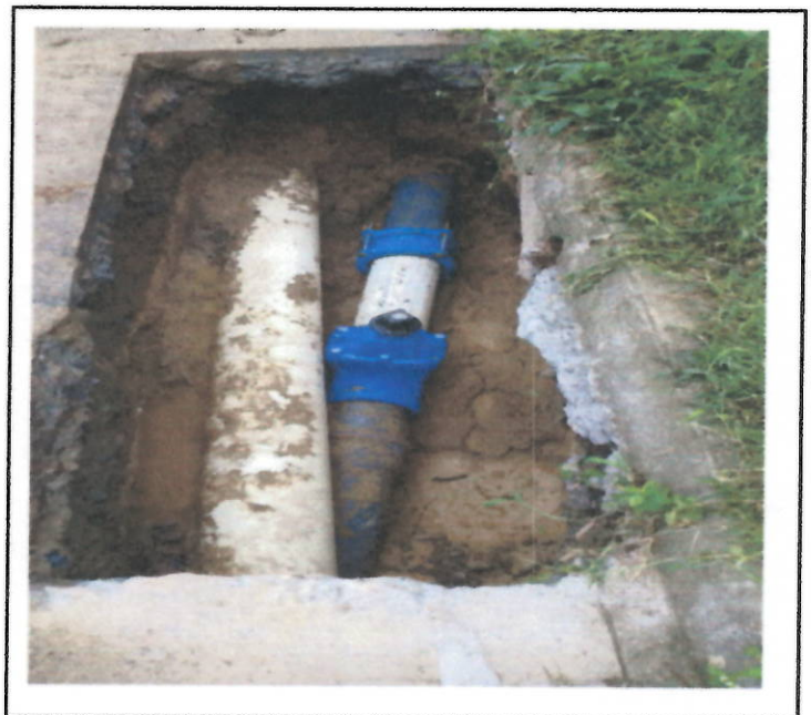
REPOSICION DE VALVULA
