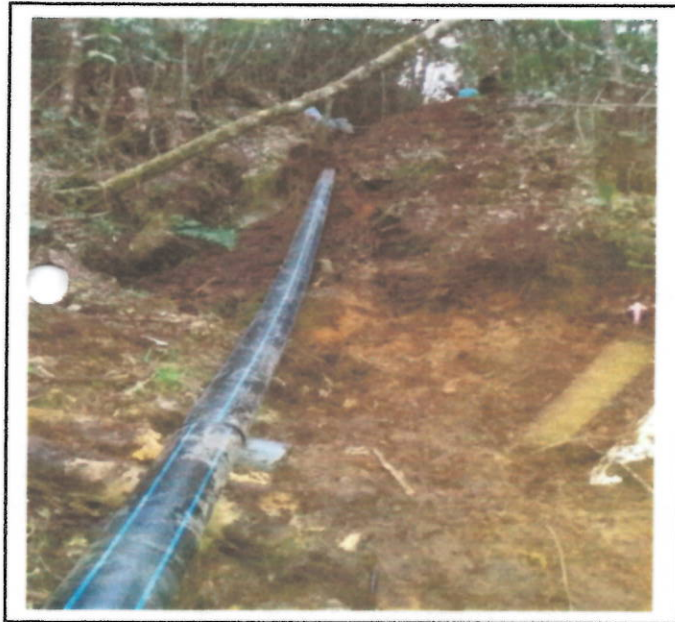
EXTENDIDA Y TERMOFUNDIDAD DE TUBERIA PF DE 6"
