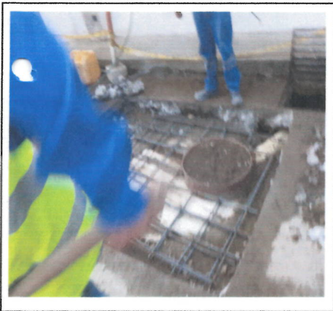
ACERO DE REFUERZO DOBLE PARRILLA CAD 0,15 MTS
