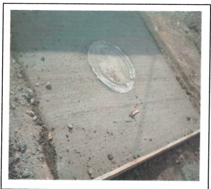
LOSAS DE CONCRETO PARA INSTALACION DE TAPAS HF
