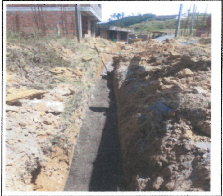
EXCAVACION Y CAMA DE ARENA
