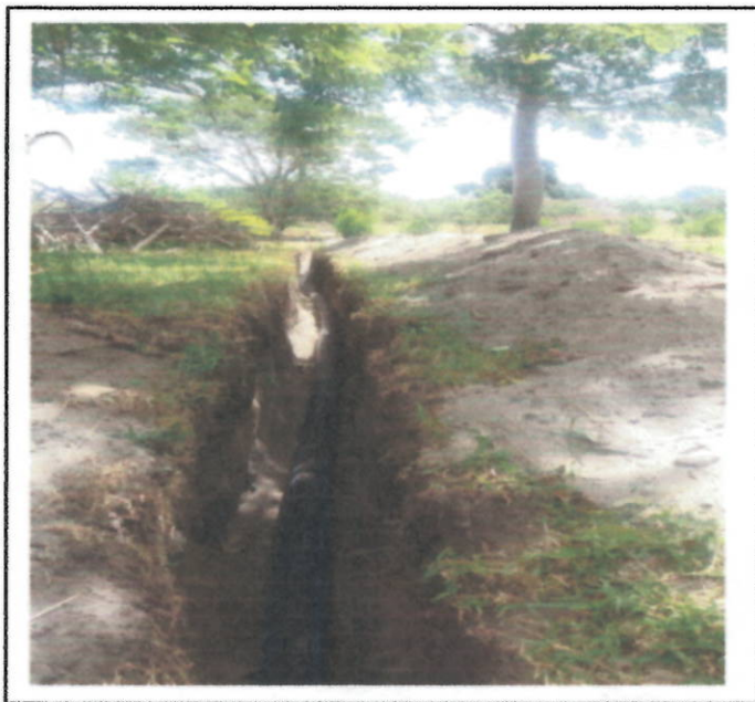
MANGUERA INSTALADA EXCAVACION REALIZADA POR LA COMUNIDAD
