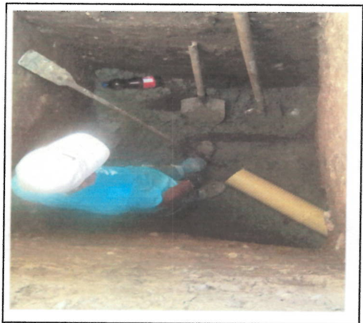
CONSTRUCCION DE CAMARAS DOMICILIARIAS
