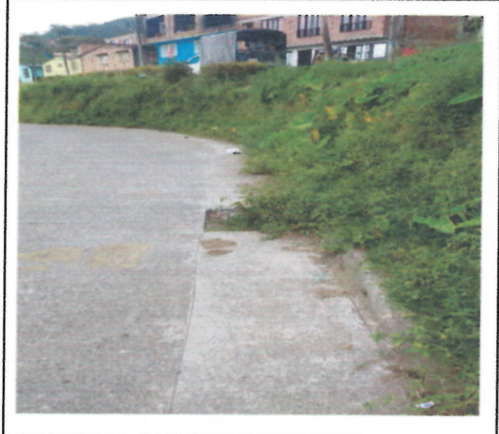
SECTOR DEL BARRIO DEPARTAMENTAL PARA CAMBIO DE VALVULA
