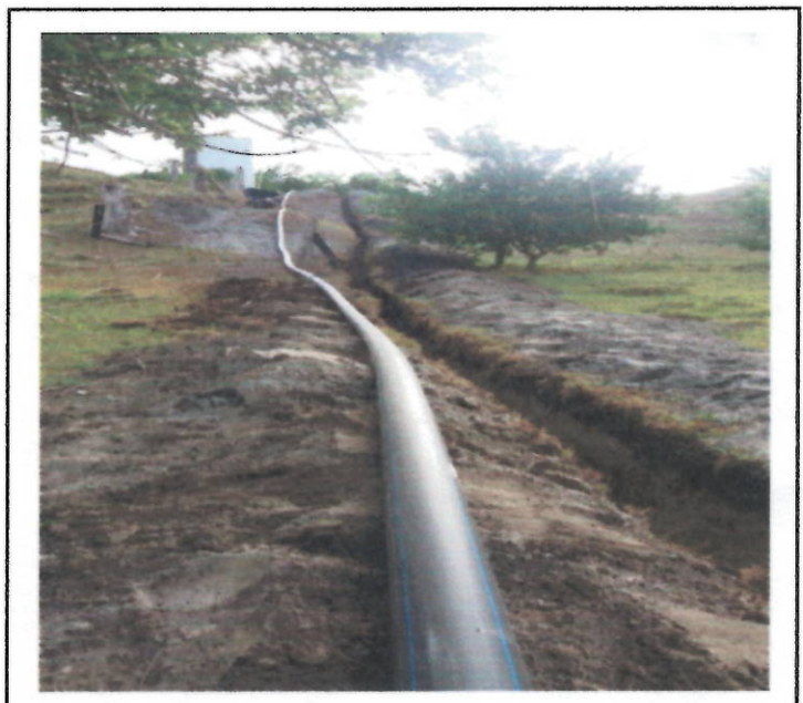
MANGUERA TERMOFUNDIDADA
