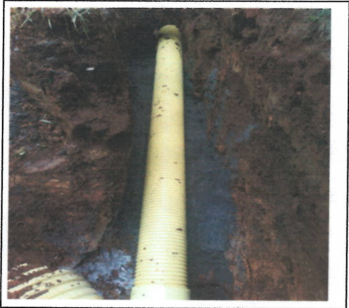
INSTALACION DE TUBERIA, SILLETAS Y CAMA DE ARENA
