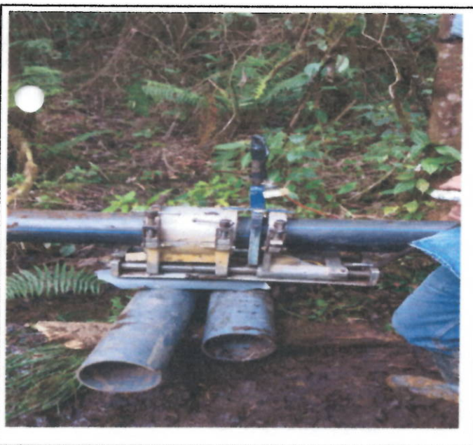
TERMOFUNDIDAD DE TUBERIA PF
