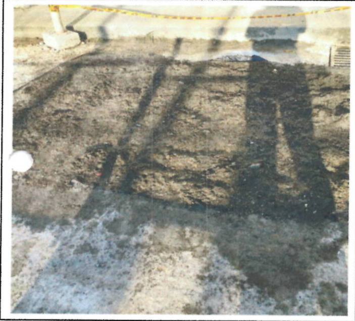
SUMINISTRO E INSTALACION DE SUBBASE
