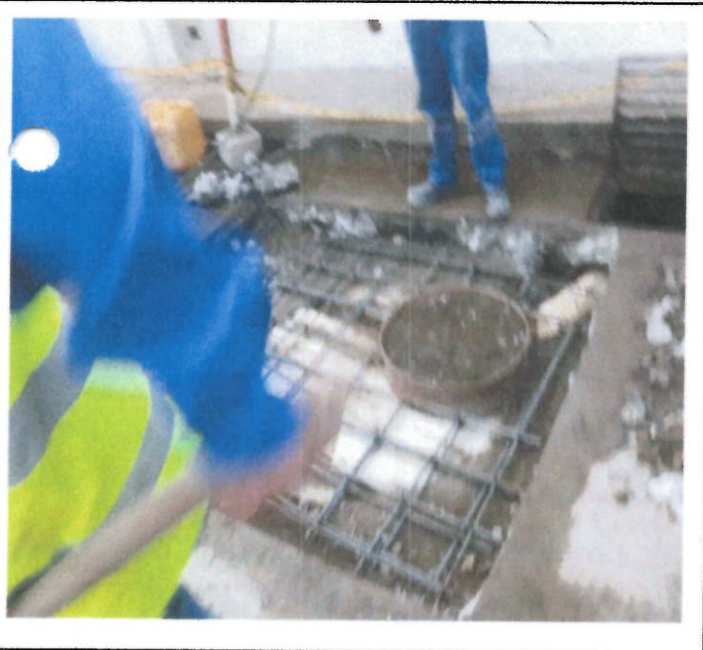
ACERO DE REFUERZO DOBLE PARRILLA CAD 0,15 MTS
