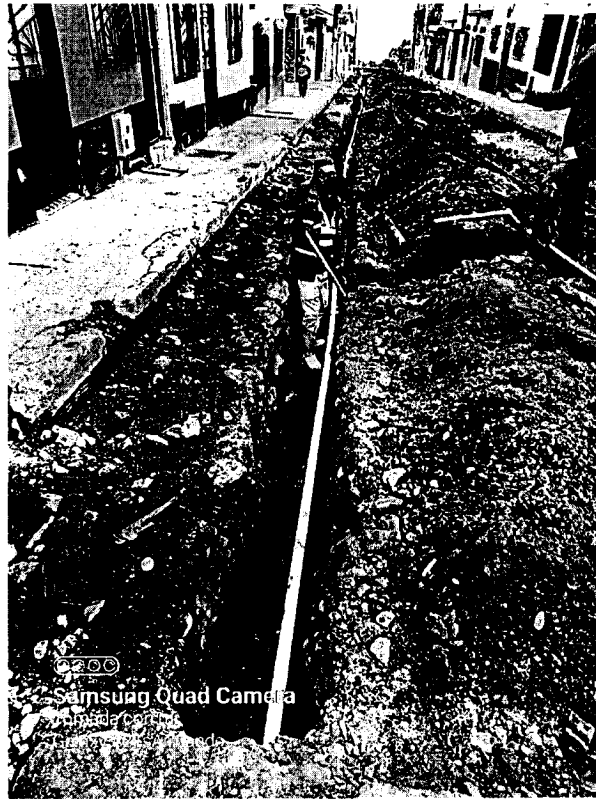
Imagen. Excavación brechas para instalación de tubería
