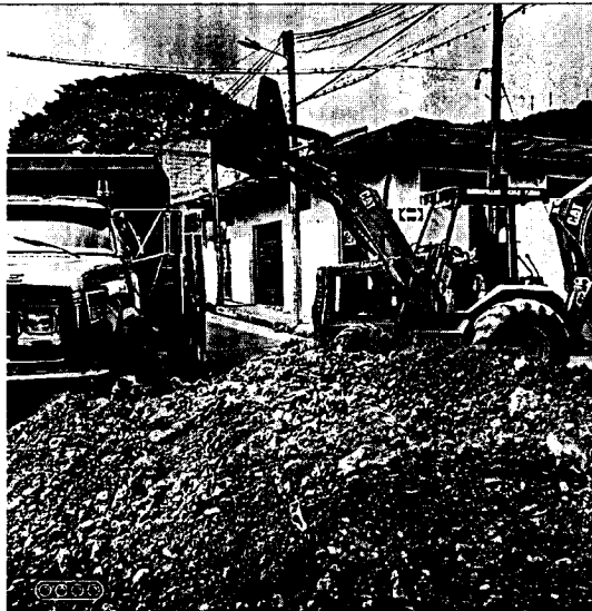
Imagen 5. Retiro de material sobrante en vehículo automotor.
