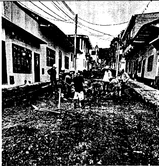
Imagen 3. Excavaciones para nivelación de la subrasante
