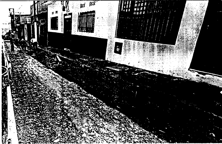
Imagen 6. Sub-base para pavimento
