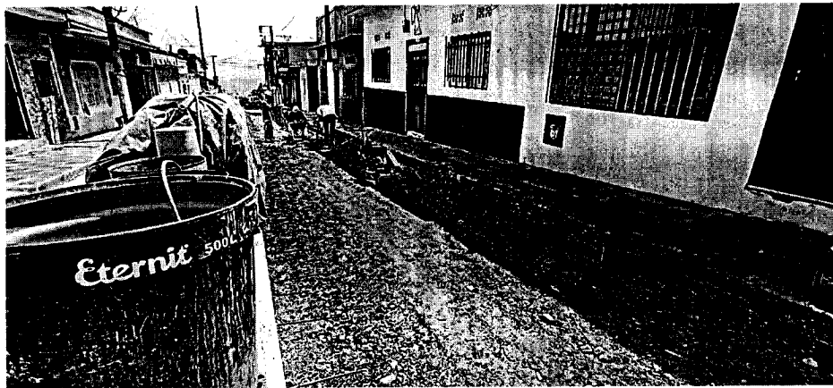
Imágenes. Sub base para pavimento.
