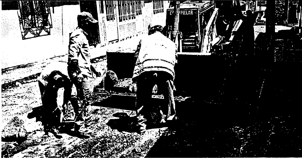
Imagen 4. Retiro piedras de gran tamaño producto de las excavaciones de la red de alcantarillado
