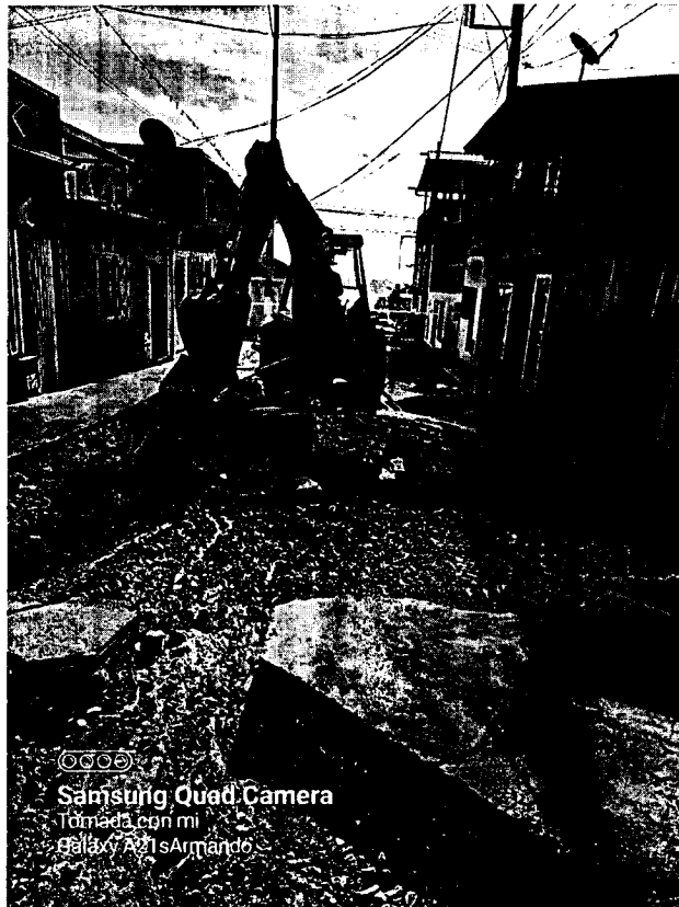
Imagen. Demolición de pavimento rígido
