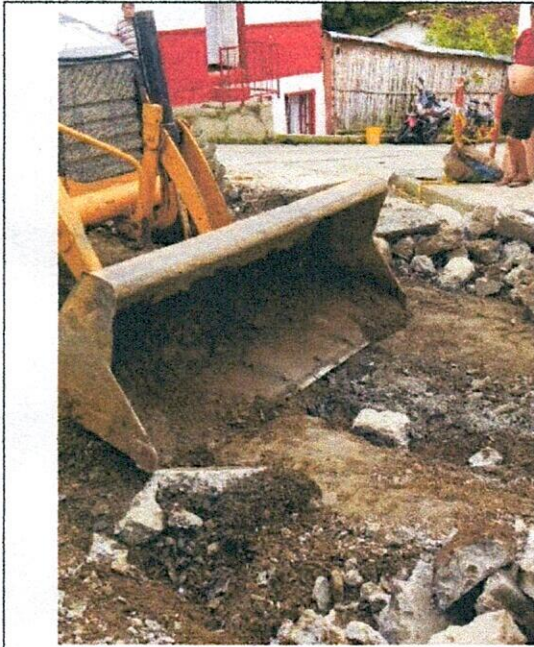
FOTO 5. Excavación con equipo mecánico
