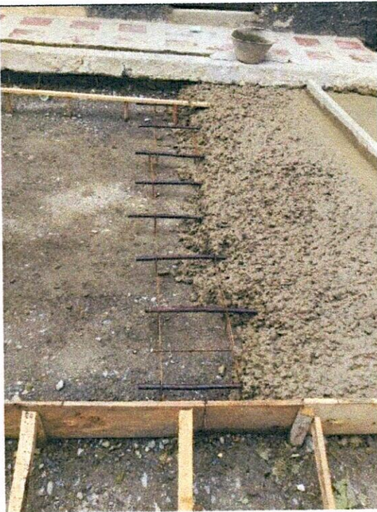
FOTO 23. Suministro e instalación de dovelas
