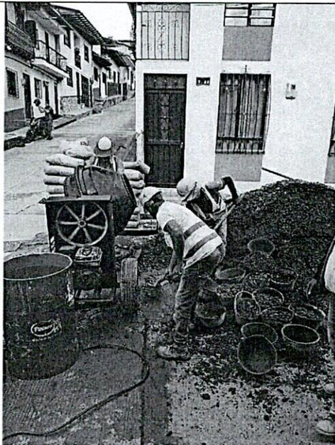
FOTO 27. Vaciado de concreto con diseño de mezcla para MR-42
