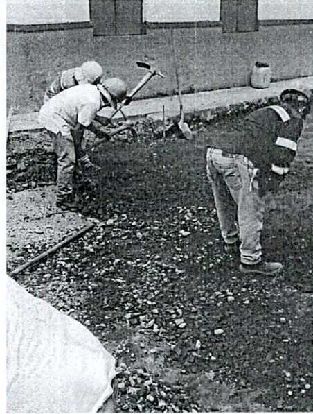
FOTO 6. Excavación y nivelación
