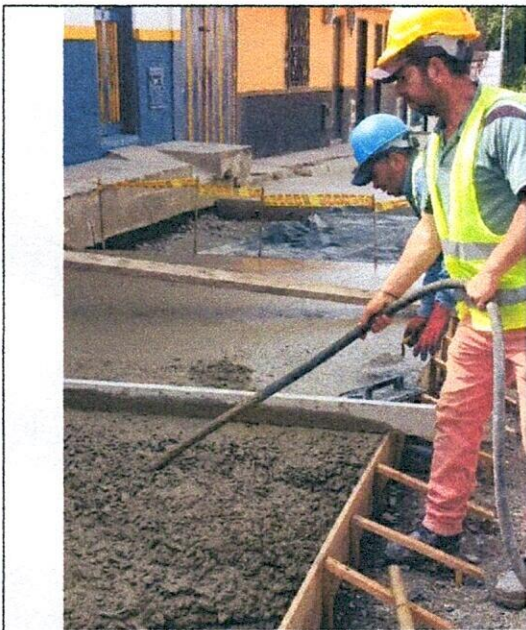
FOTO 29. Vibrado de pavimento
