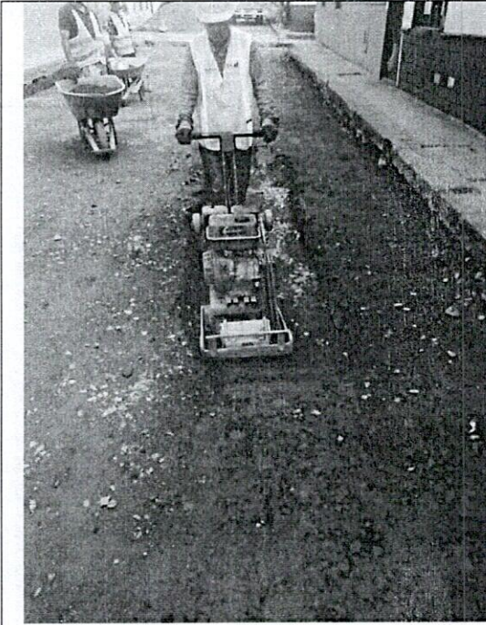
FOTO 13. Compactación mecánica (rana) de la subbase, luego de escarificación para sustitución
