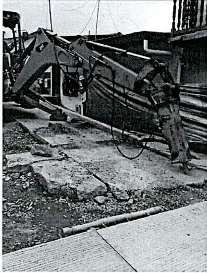
FOTO 1. Demolición pavimento antiguo con retroexcavadora de llantas
