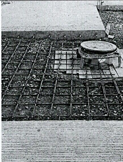
FOTO 15. Instalación parrilla para refuerzo de área irregular contorno cámara de inspección
