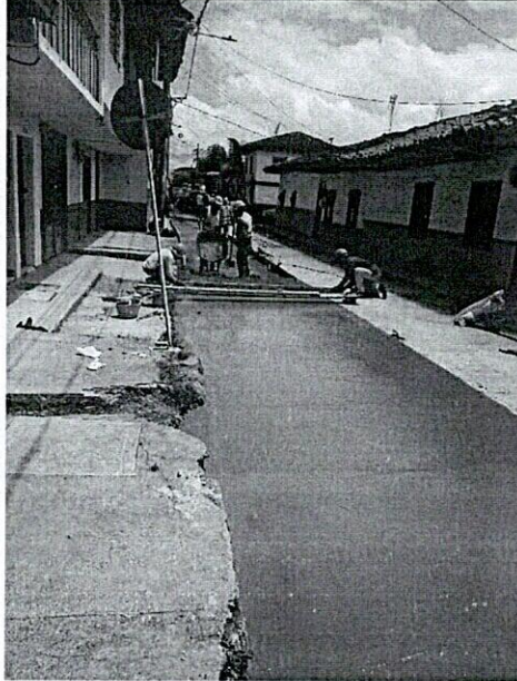
FOTO 25. Vaciado de pavimento MR-42
