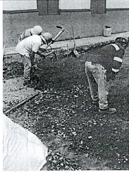
FOTO 6. Excavación y nivelación
