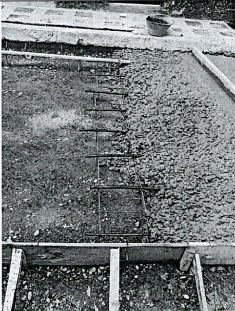
FOTO 23. Suministro e instalación de dovelas
