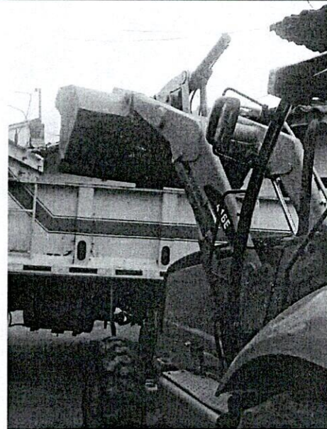
FOTO 4. Retiro de escombros
