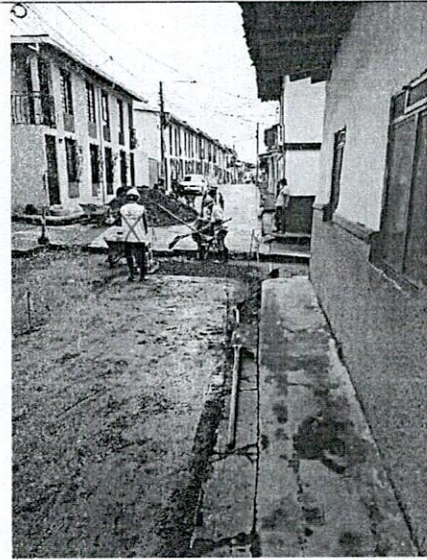
FOTO 8. Excavación y nivelación para instalación de subbase
