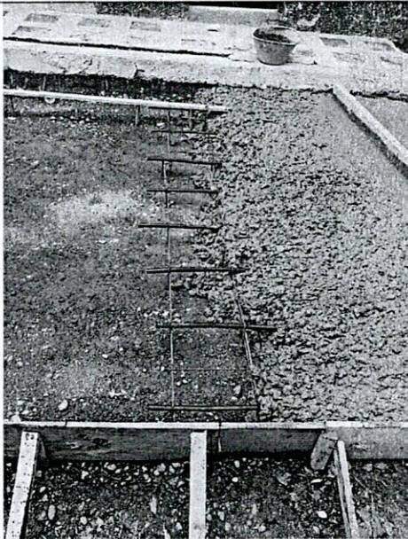
FOTO 23. Suministro e instalación de dovelas
