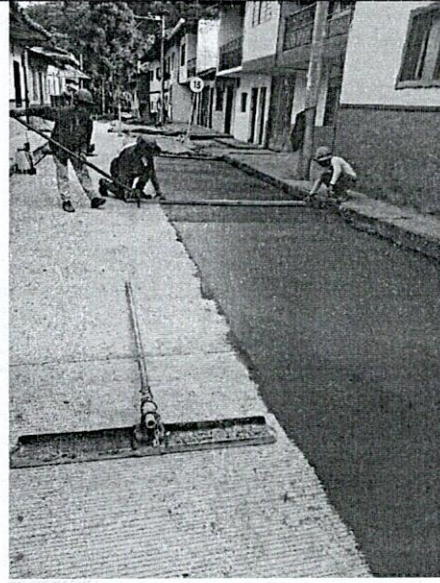
FOTO 30. Texturizado de pavimento
