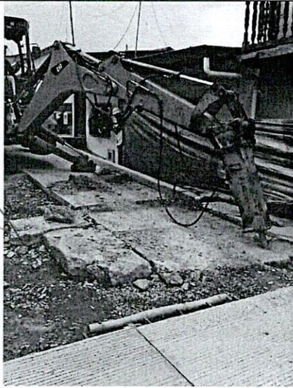
FOTO 1. Demolición pavimento antiguo con retroexcavadora de llantas
