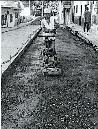
FOTO 11. Compactación de subbase
