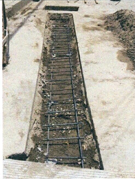
FOTO 18. Instalación de acero de refuerzo
