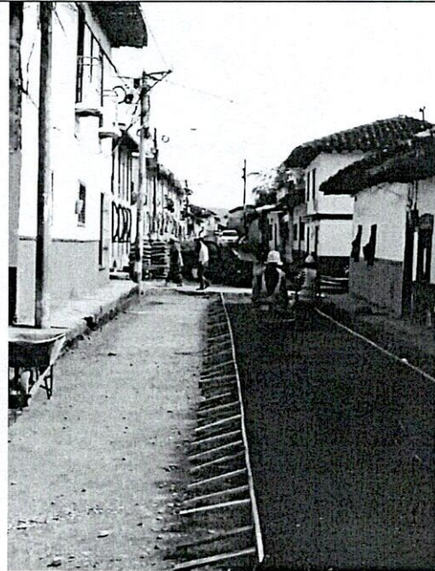
FOTO 10. Instalación de formaleta para pavimento
