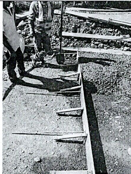
FOTO 20. Instalación de pasadores
