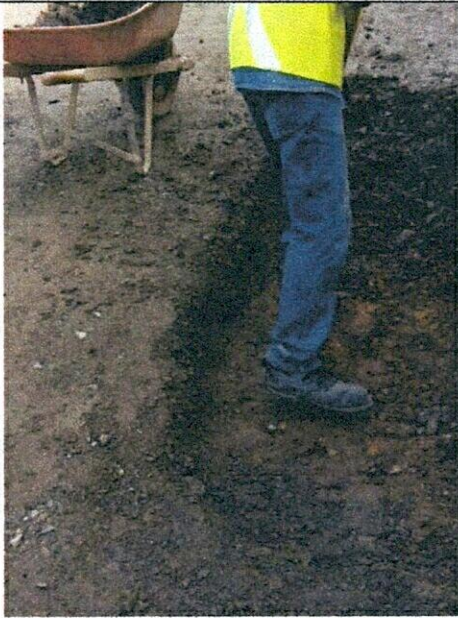
FOTO 7. Excavación de fallos
