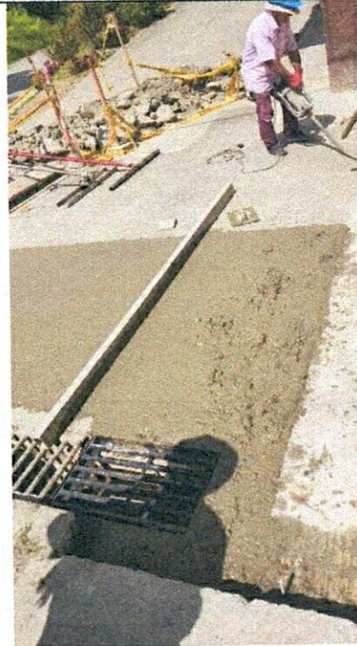
FOTO 24. Suministro e instalación de reja de sumidero
