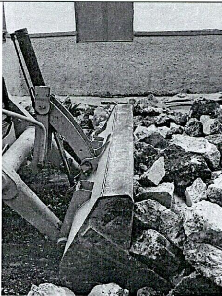
FOTO 3. Retiro de escombros
