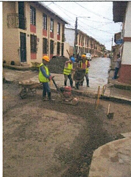
FOTO 12. Suministro e instalación de subbase
