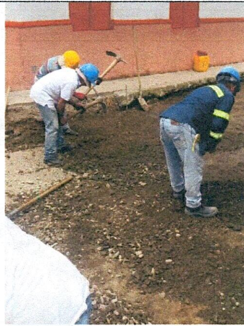
FOTO 6. Excavación y nivelación
