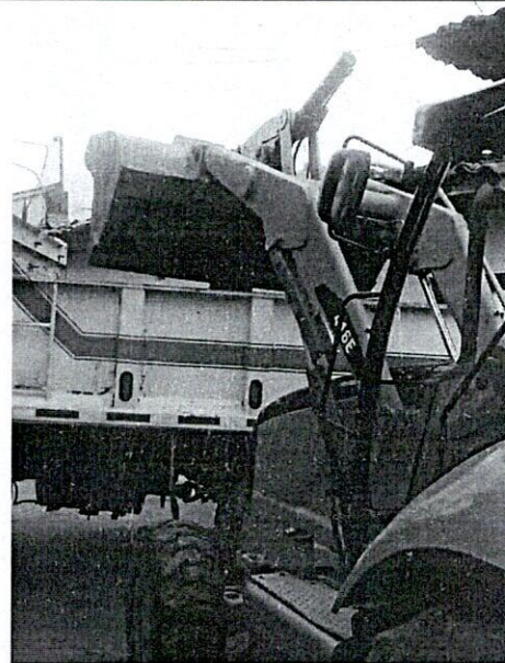
FOTO 4. Retiro de escombros
