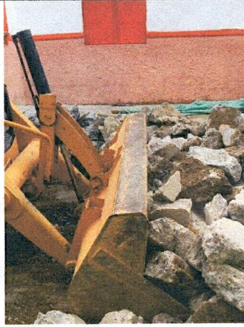
FOTO 4. Retiro de escombros
