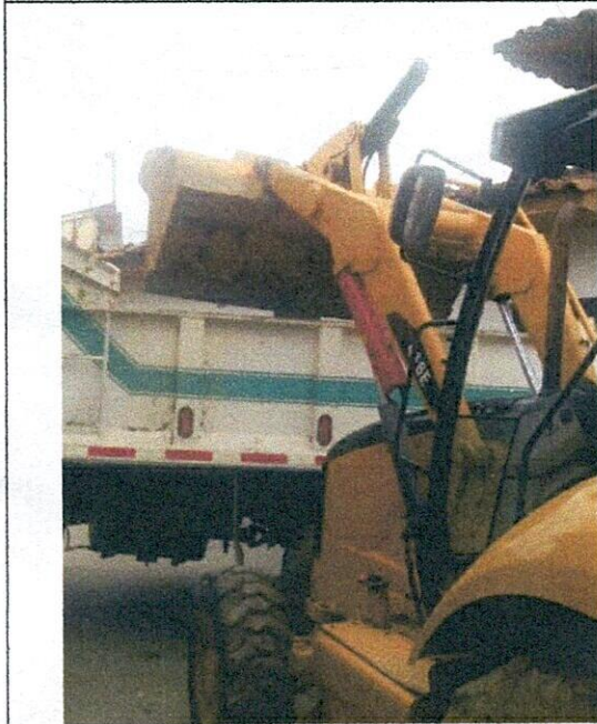
FOTO 3. Evacuación de escombros
