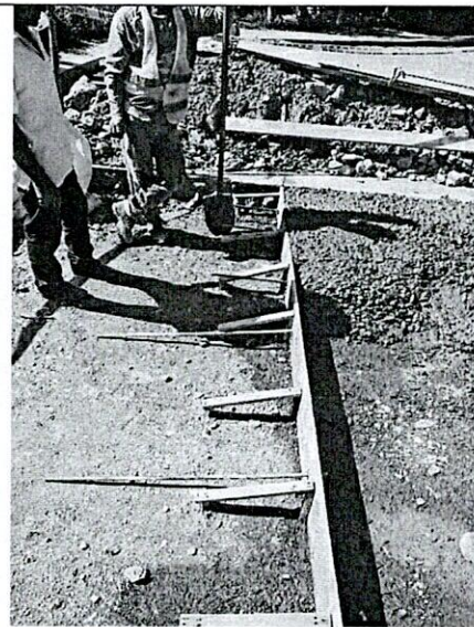
FOTO 20. Instalación de pasadores
