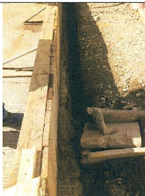
FOTO 14. Compactación de la subbase
