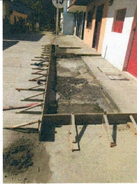
FOTO 14. Compactación de la subbase
