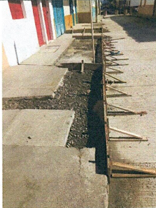
FOTO 16. Formaletiado de sumidero
