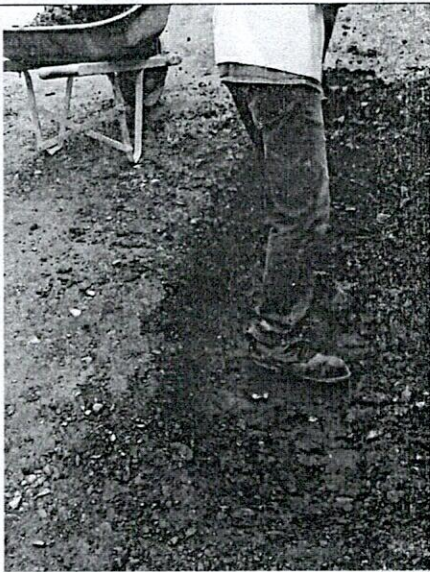
FOTO 7. Excavación de zonas para sustitución
