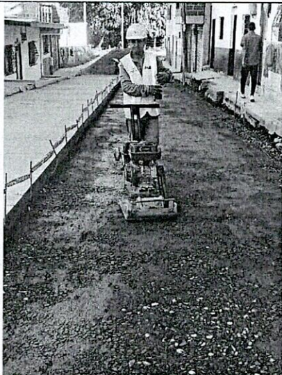
FOTO 11. Compactación de subbase
