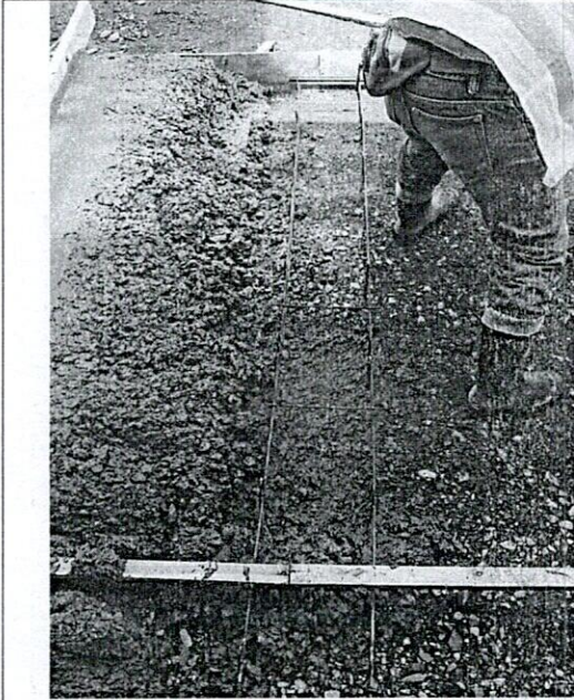
FOTO 21. Suministro e instalación de canastilla
