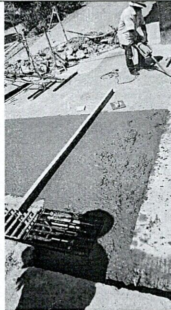
FOTO 24. Suministro e instalación de reja de sumidero
