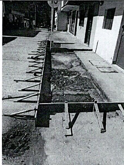
FOTO 14. Reparación de los andenes mas afectados
