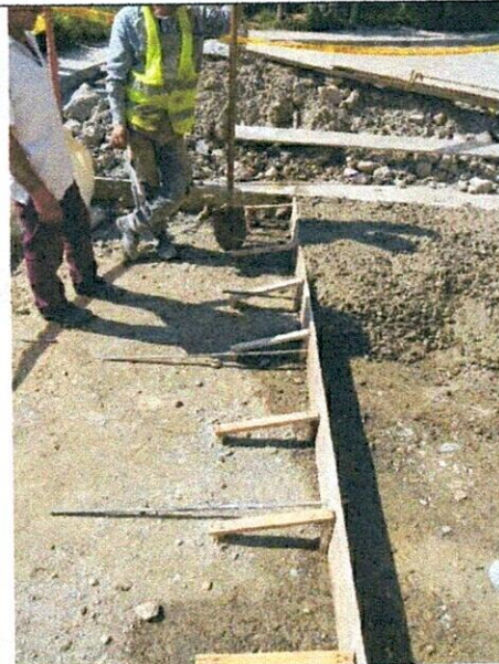
FOTO 20. Instalación de pasadores
