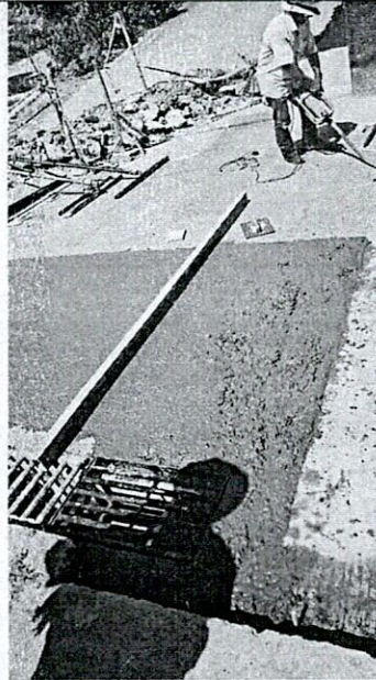
FOTO 24. Suministro e instalación de reja de sumidero
