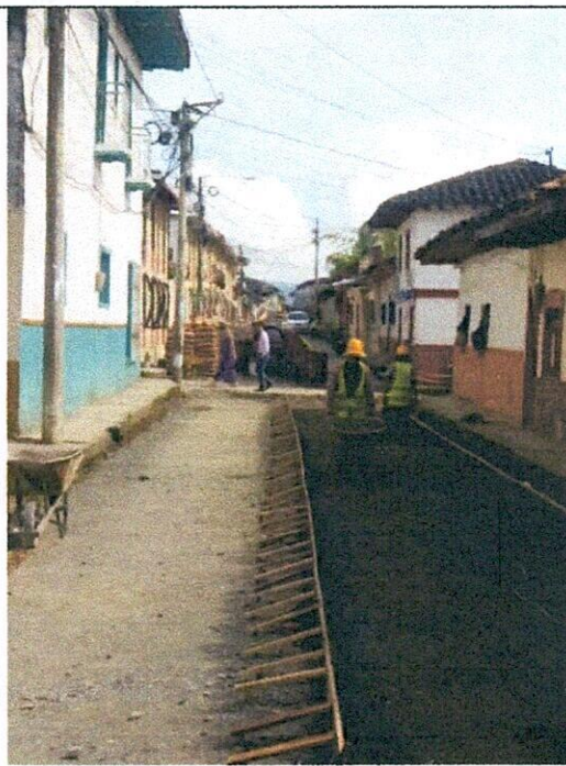
FOTO 10. Instalación de formaleta
