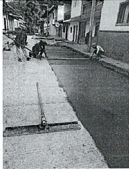
FOTO 30. Texturizado de pavimento
