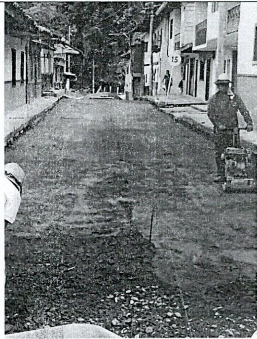
FOTO 14. Compactación mecánica (rana) de la subbase
