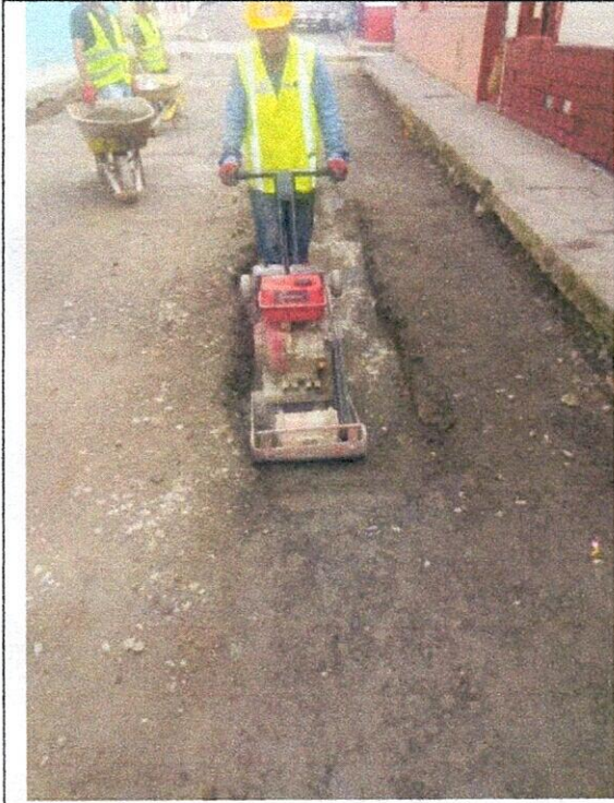
FOTO 13. Compactación de subbase
