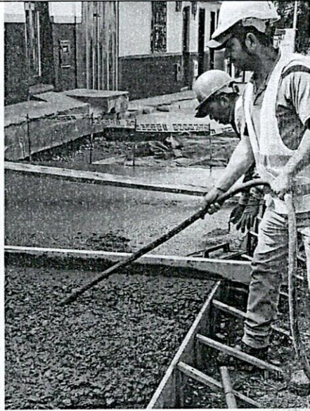
FOTO 29. Vibrado de pavimento
