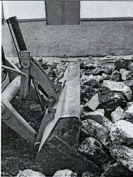
FOTO 3. Retiro de escombros
