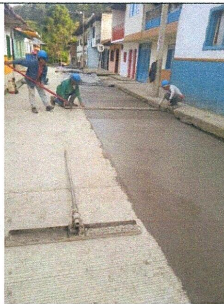
FOTO 30. Texturizado de pavimento
