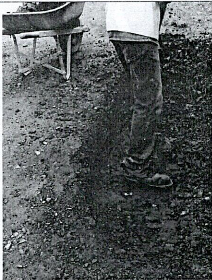
FOTO 7. Excavación de zonas para sustitución
