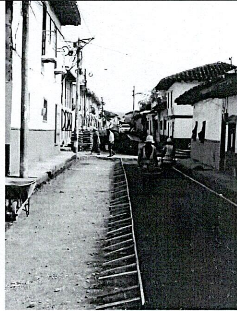
FOTO 10. Instalación de formaleta para pavimento
