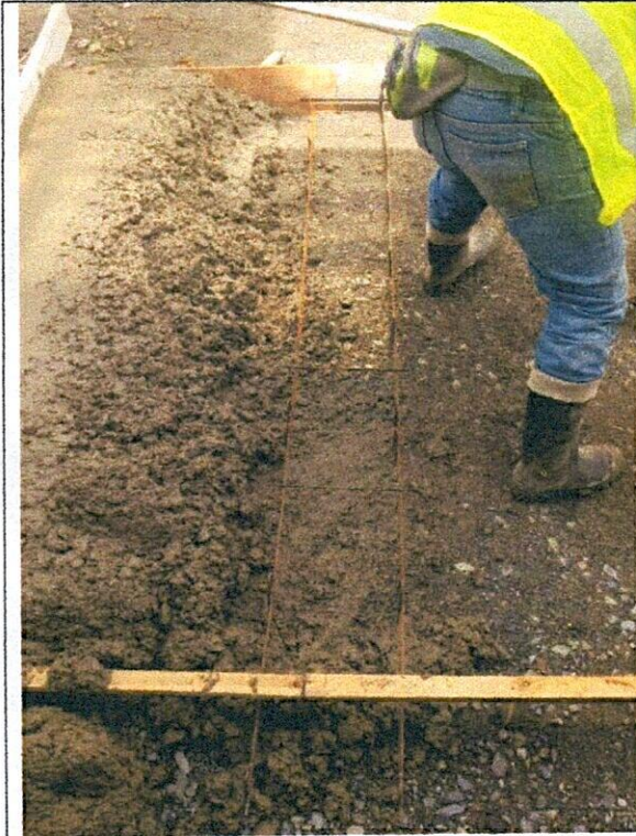
FOTO 21. Suministro e instalación de canastilla
