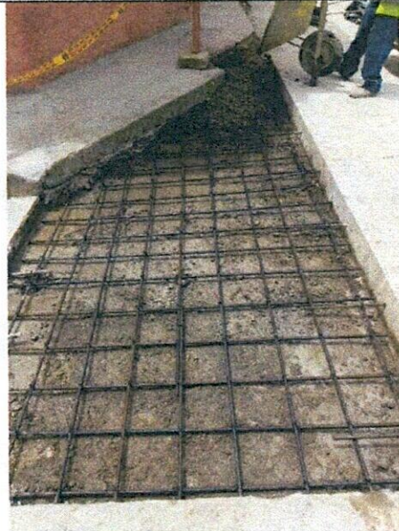
FOTO 16. Instalación de acero de refuerzo
