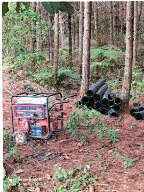
Imagen 2.- Acopio de tubería de polietileno de 10” en área de intervención
