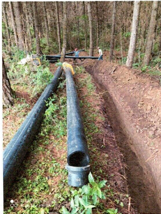
Imagen 6.- Instalación de tubería de polietileno de 10".
