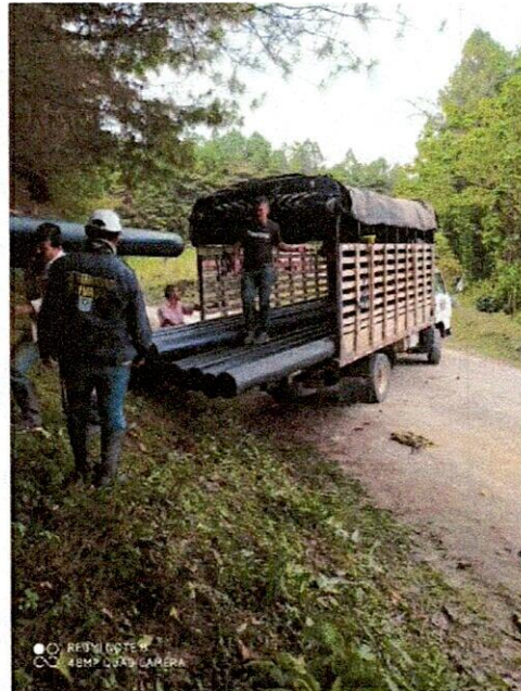
Imagen 1.- Descargue y acarreo de tubería de polietileno de 10” hasta lugar de almacenamiento
