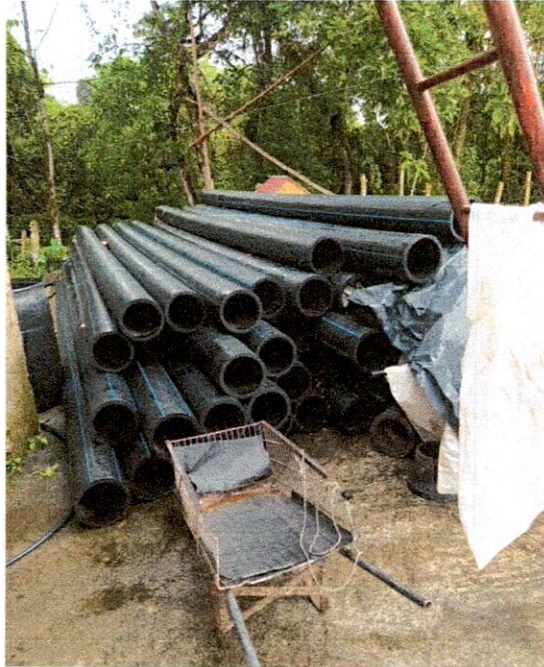
Almacenamiento de tubería de polietileno de 10"
