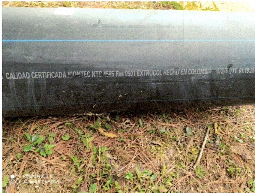
Imagen 3.- Trazabilidad de tubería de polietileno de 10' instalada
