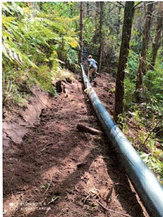
Imagen 8.- Instalación de tubería de polietileno de 10", según localización.
