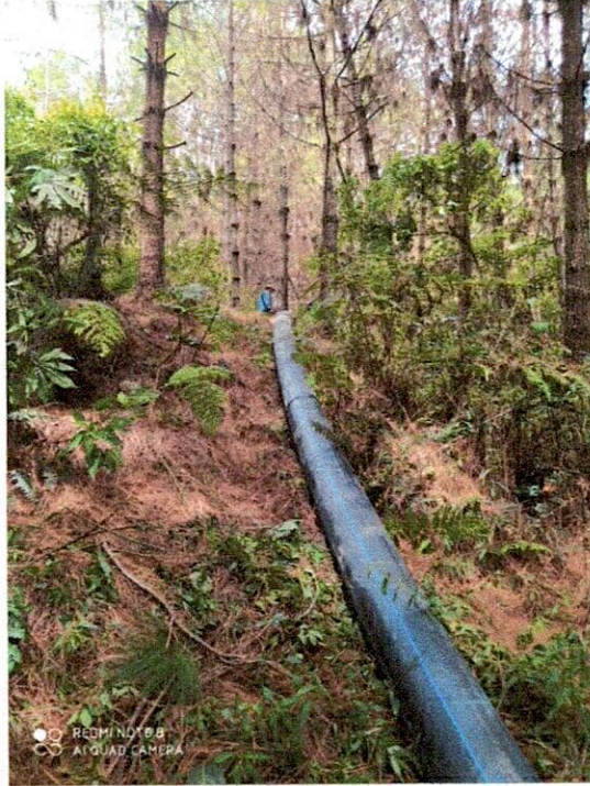
Imagen 9.- Instalación de tubería de polietileno de 10", según localización
