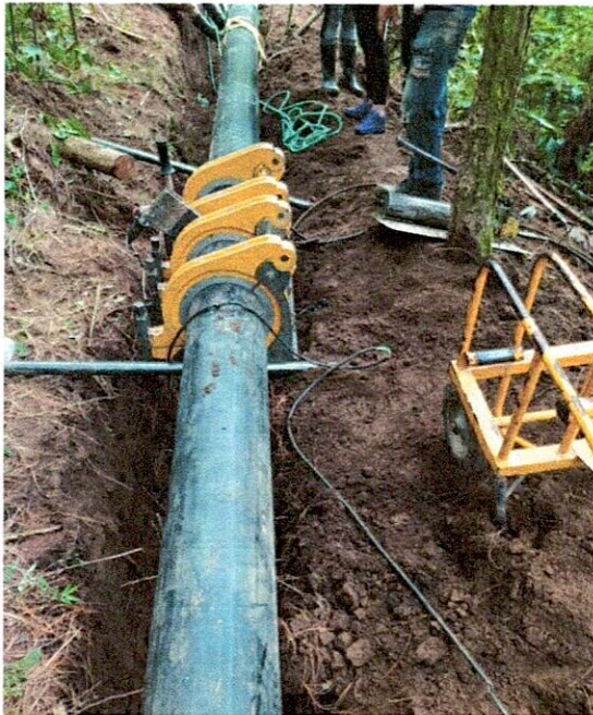
Termofusión de tubería de polietileno de 10"
