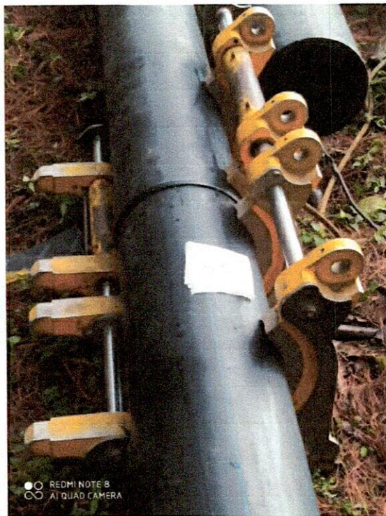
Imagen 14.- Termofusión de tubería de polietileno de 10".
