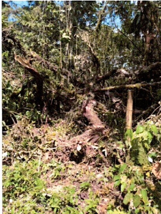
Imagen 19.- Corte de árboles caídos que interferían con la ruta de instalación de la tubería.
