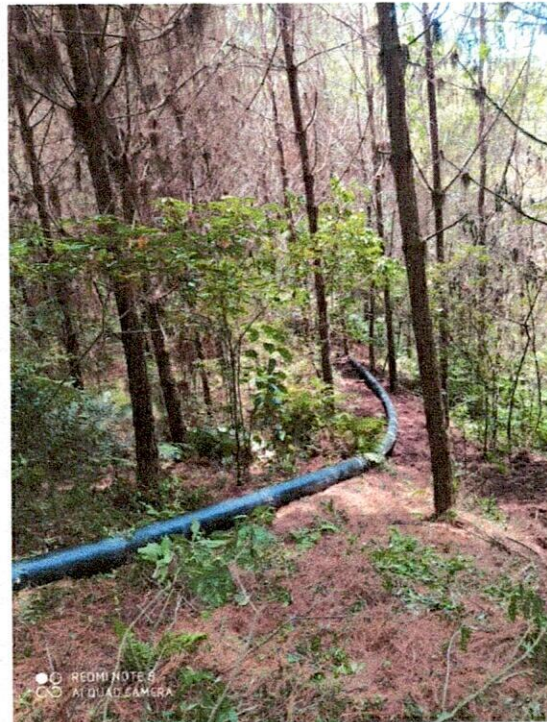
Imagen 10.- Instalación de tubería de polietileno de 10", según localización
