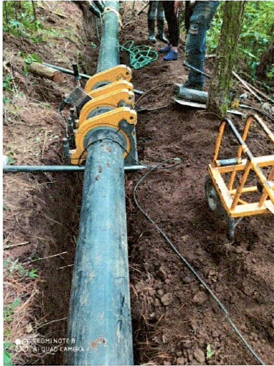
Imagen 15.- Termofusión de tubería de polietileno de 10”.
