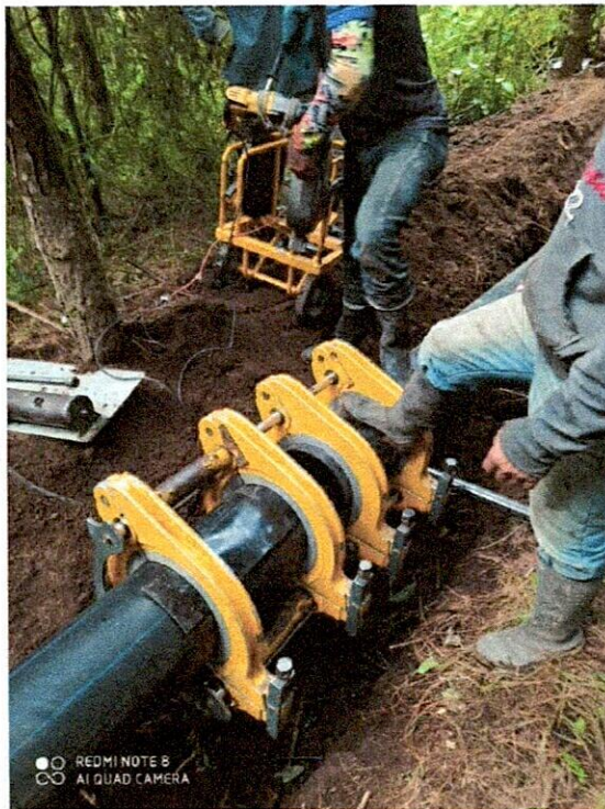
Imagen 16.- Termofusión de tubería de polietileno de 10”.
