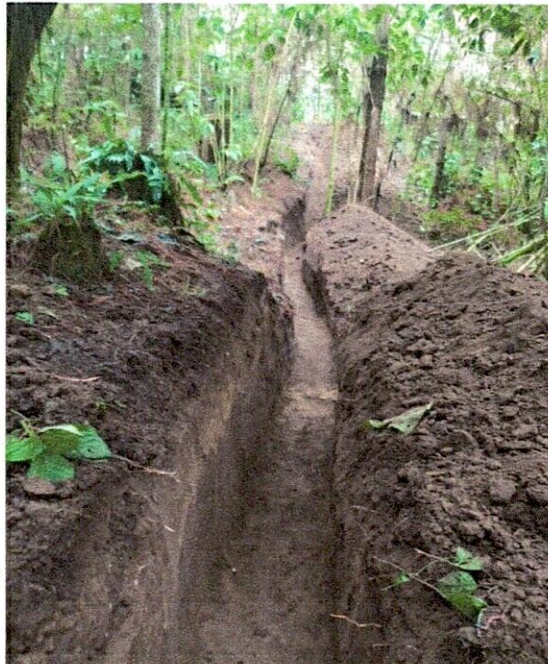
Excavación en zanja en material común
