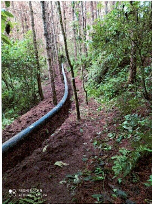
Imagen 11.- Instalación de tubería de polietileno de 10", según localización.
