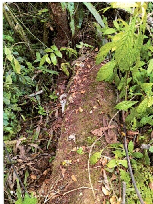
Imagen 20.- Corte de árboles caídos que interferían con la ruta de instalación de la tubería.
