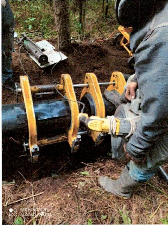
Imagen 17.- Termofusión de tubería de polietileno de 10”.
