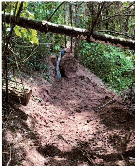
Lleno compactado con material seleccionado posterior a instalación de tubería
