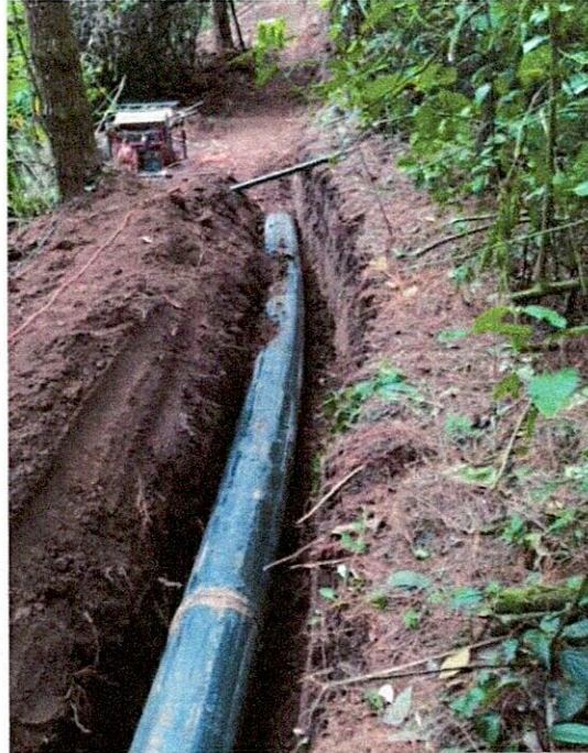
Imagen 7.- Instalación de tubería de polietileno de 10", según localización
