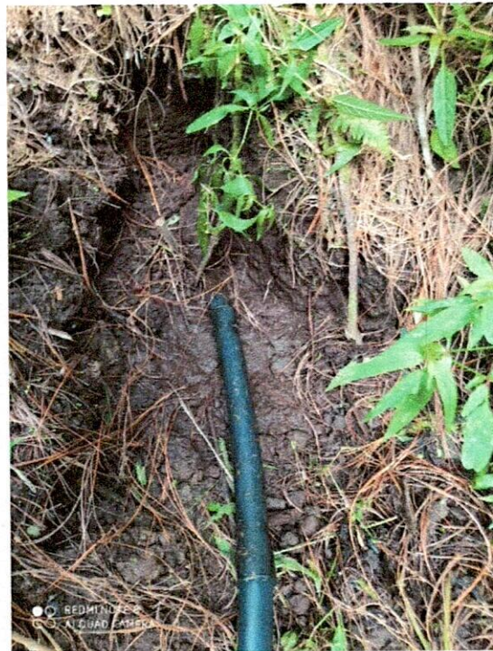
Imagen 12.- Instalación de tubería de polietileno de 10", según localización
