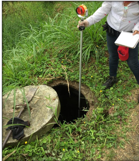
Figura 6. Levantamiento cámara de alcantarillado
