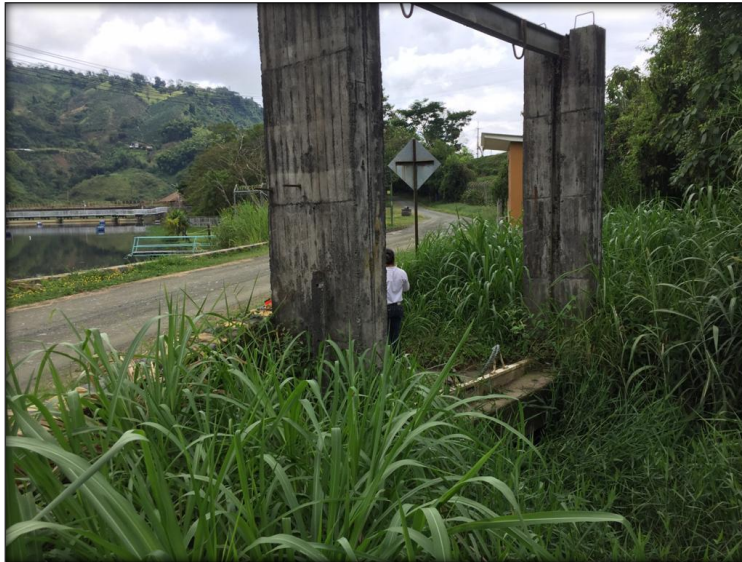
Figura 8. Estructura de compuerta.
