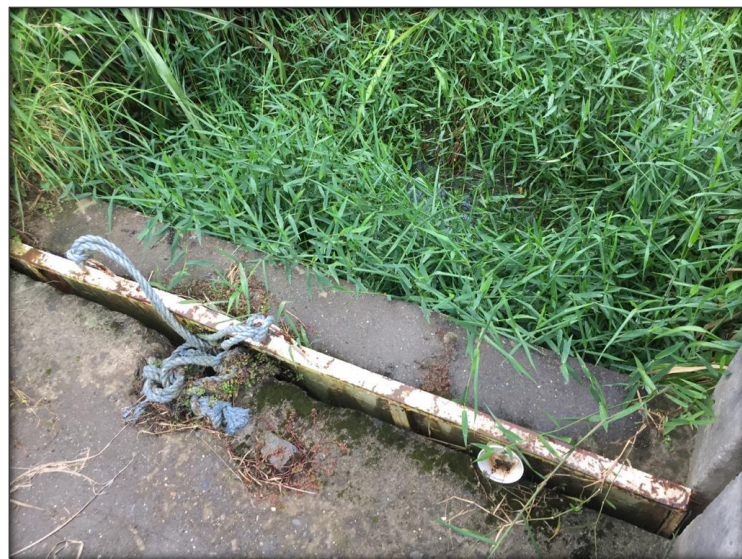
Figura 9. Compuerta metálica existente.
