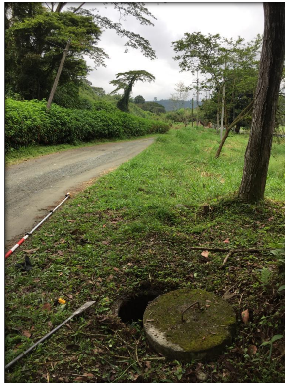
Figura 7. Inspección de colector existente
