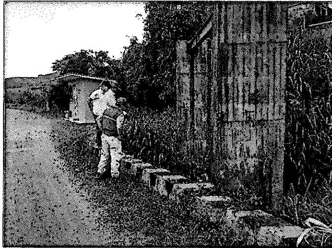
Figura 2. Zona de compuerta construida en el canal existente.
