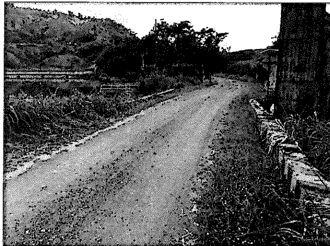
Figura 11. Vía objeto de levantamiento topográfico
