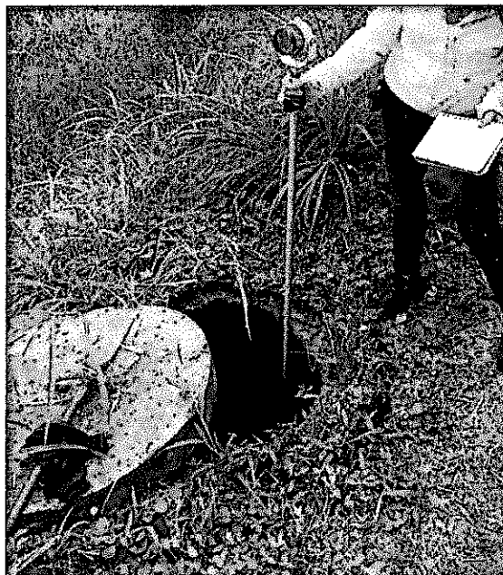
Figura 6. Levantamiento cámara de alcantarillado
