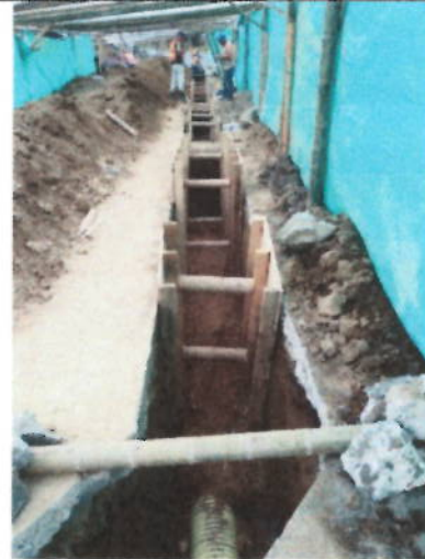
Imagen 14 Calle 24 entre carreras 3 y 4 (08 oct – 2019)
