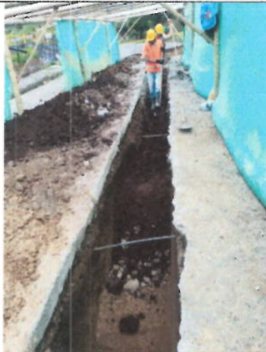
Imagen 15 Calle 24 entre carreras 3 y 4 (09 oct – 2019)
