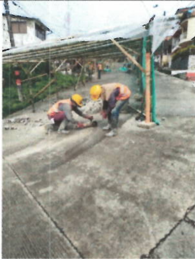
Imagen 13 Calle 24 entre carreras 3 y 4 (03 oct – 2019)
