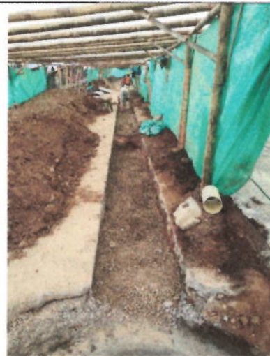
Imagen 16 Calle 24 entre carreras 3 y 4 (12 oct – 2019)
