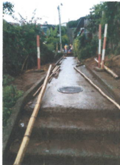
Imagen 8 Calle 26 entre carrera 3e y carrera 4e (08 nov – 2019)
