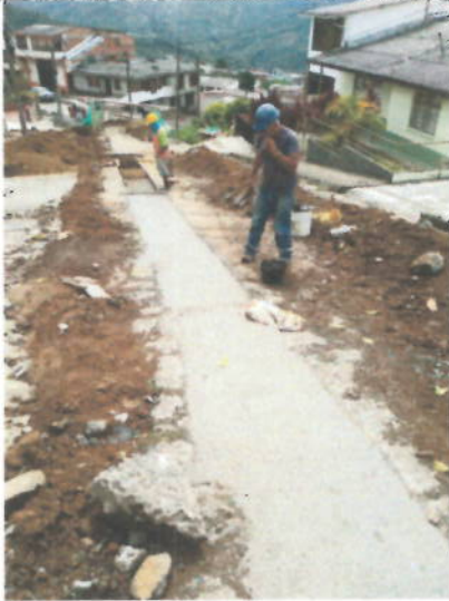
Imagen 1 Calle 24 entre carreras 3 y 4 (29 oct – 2019)
