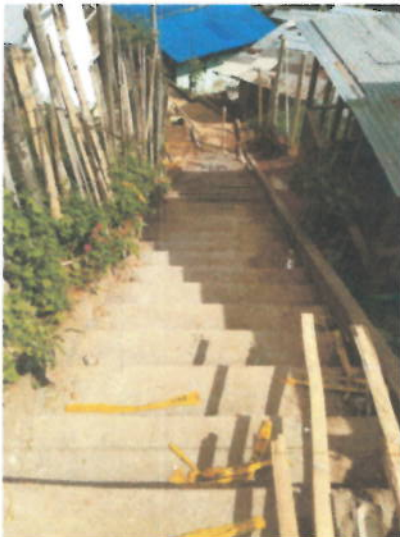
Imagen 7 Calle 26 entre carrera 3e y carrera 4e (08-nov- 2019)
