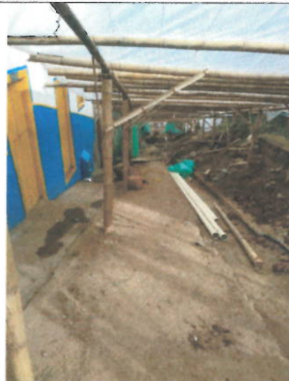
Imagen 16 Calle 3 entre carrera 2 y 3 (19 nov – 2019)
