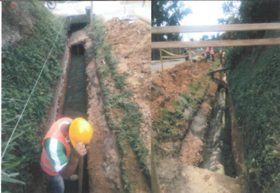
**Filtros en geotextil NT 1600**
