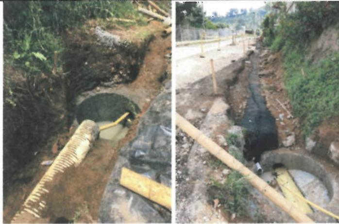
***Transporte e Instalación Tubería PVC Corrugada de 315 mm (12") para Alcantarillado***
