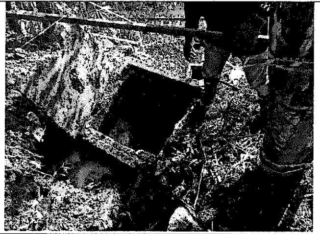
CONSTRUCCIÓN CAJAS DE INSPECCIÓN
