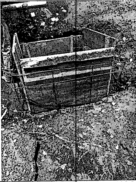
CONSTRUCCIÓN CAMARAS DE INSPECCIÓN
