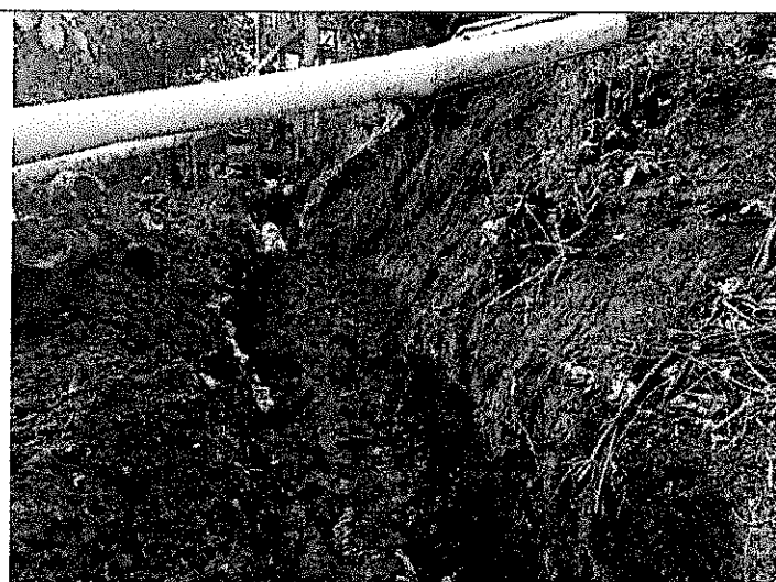
EXCAVACIONES PARA INSTALACIÓN TUBERÍA Y MANEJO DE AGUAS
