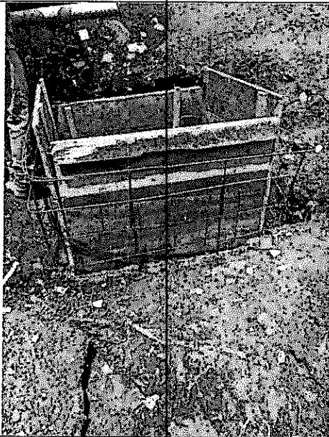
CONSTRUCCIÓN CAMARAS DE INSPECCIÓN
