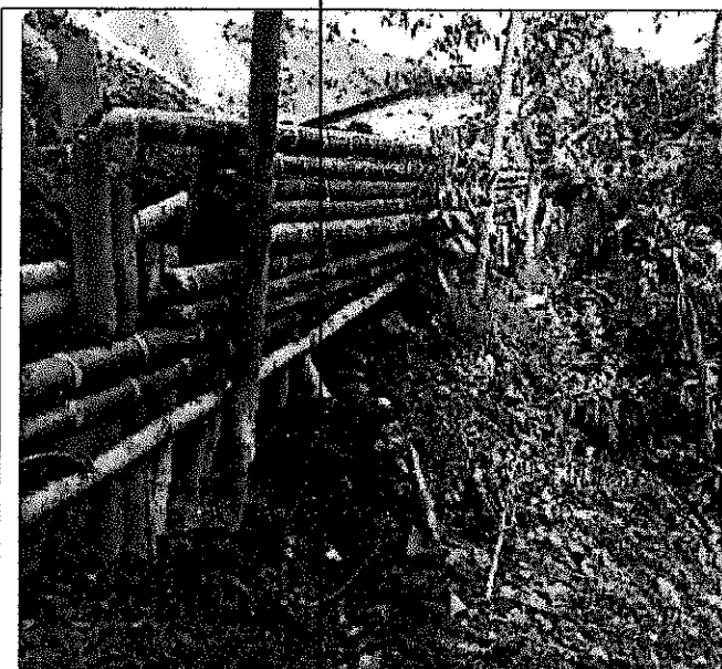
TRINCHOS PROVISIONALES PARA RETENCIÓN DE MATERIAL
