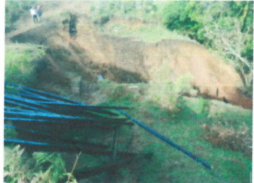
EN LA ACTUALIDAD SE REALIZAN LABORES DE PERFILADO DE TALUDES, CONSTRUCCIÓN DE TRINCHOS EN GUADUA Y SIEMBRA DE ESTACAS DE VEGETACIÓN MITIGADORA DE EROSIÓN.
