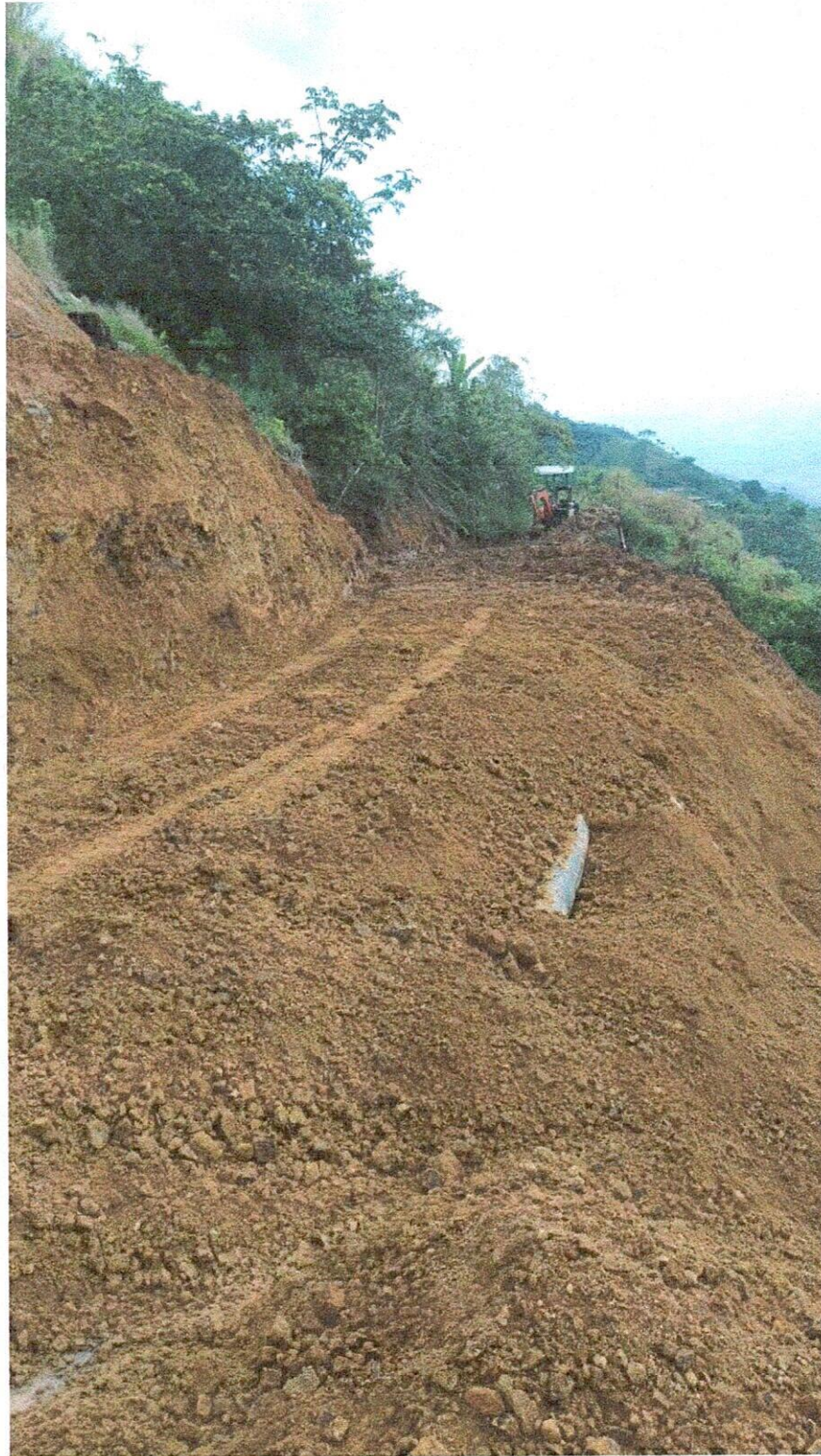
Foto 2: Reubicación tubería de 12" regional de occidente y recuperación carril vehicular
