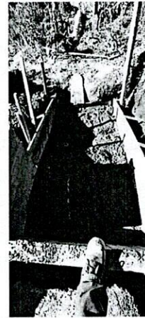
FOTO 4. Formaleta e inicio del vaciado
