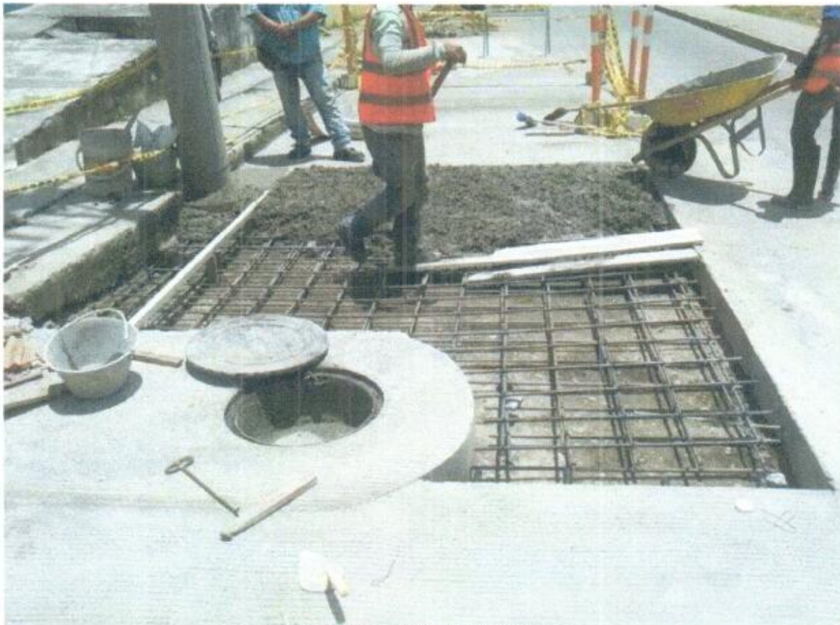
VACIADO DE PAVIMENTO
