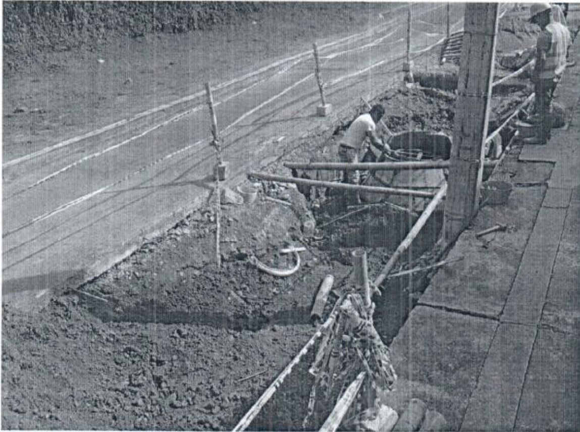
RECONSTRUCCION DE CAMARA
