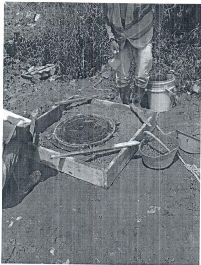
INSTALACION TAPA HF
