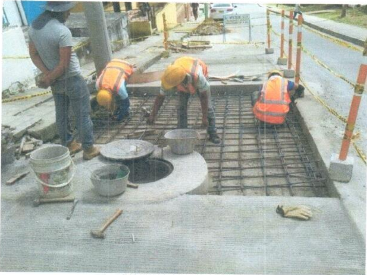
INSTALACION DE ACERO
