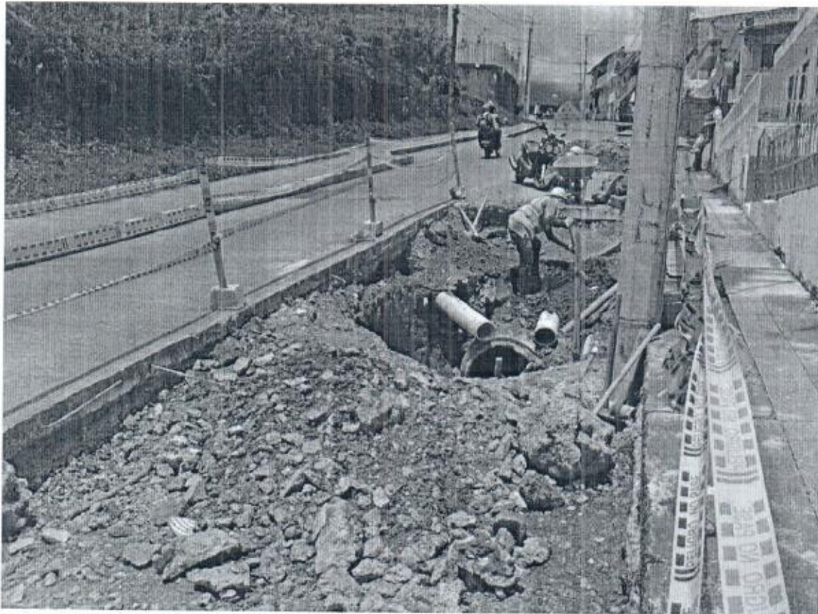
DEMOLICION DE CAMARA
