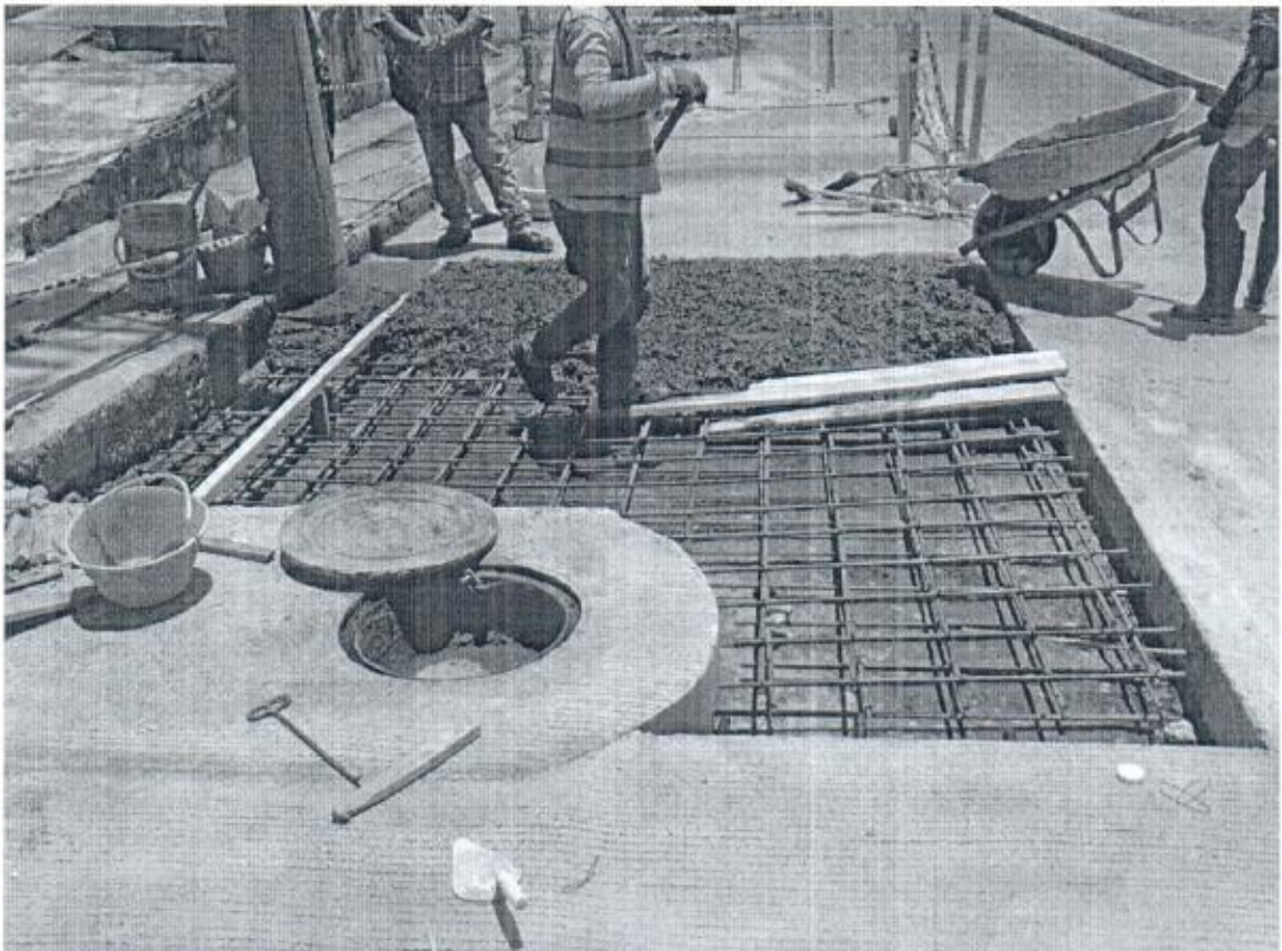
VACIADO DE PAVIMENTO
