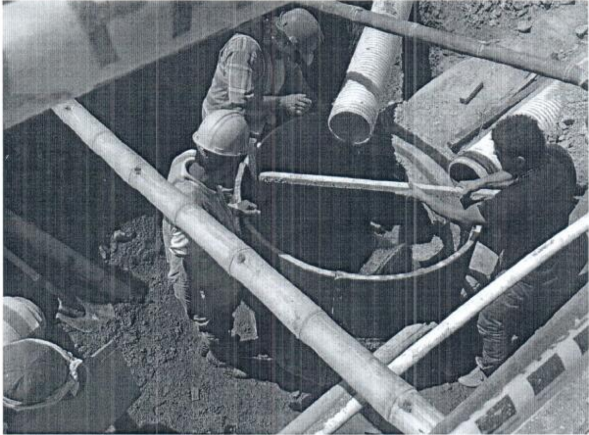
RECONSTRUCCION DE CAMARA
