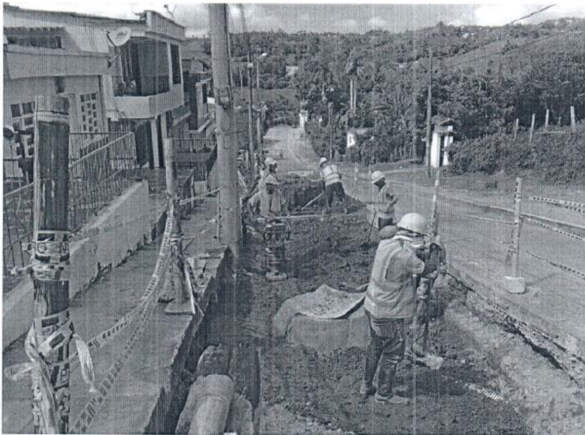
CONFORMACION DEL TERRENO
