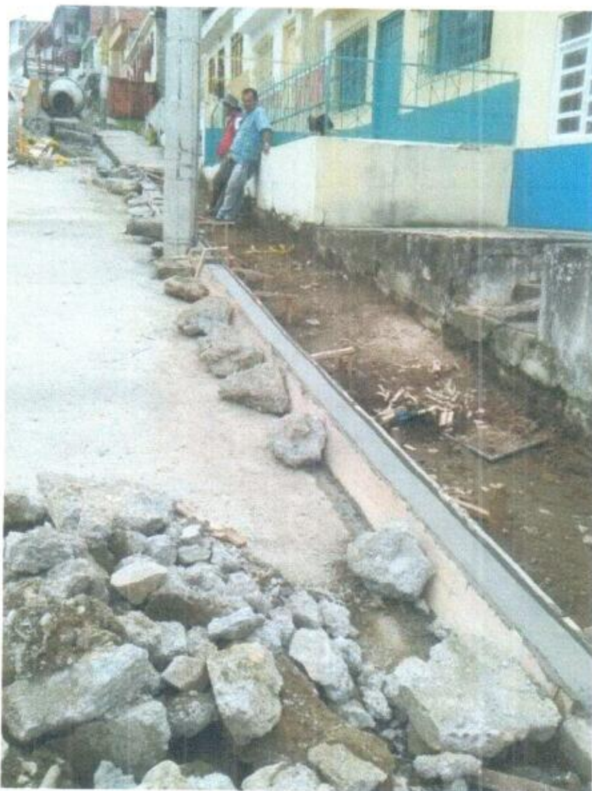
VACIADO DE BORDILLO
