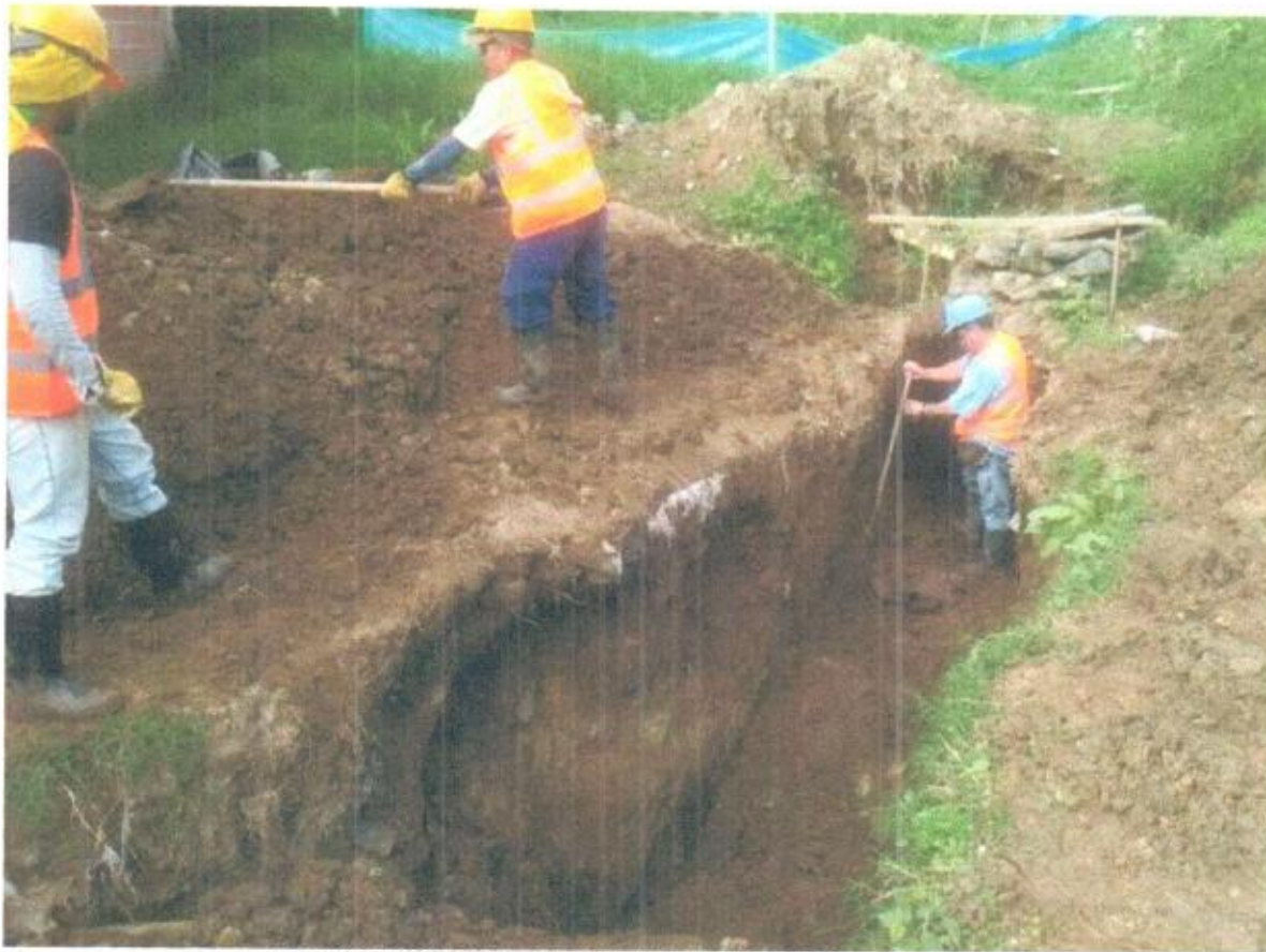
EXCAVACION EN ZANJA MATERIAL COMUN
