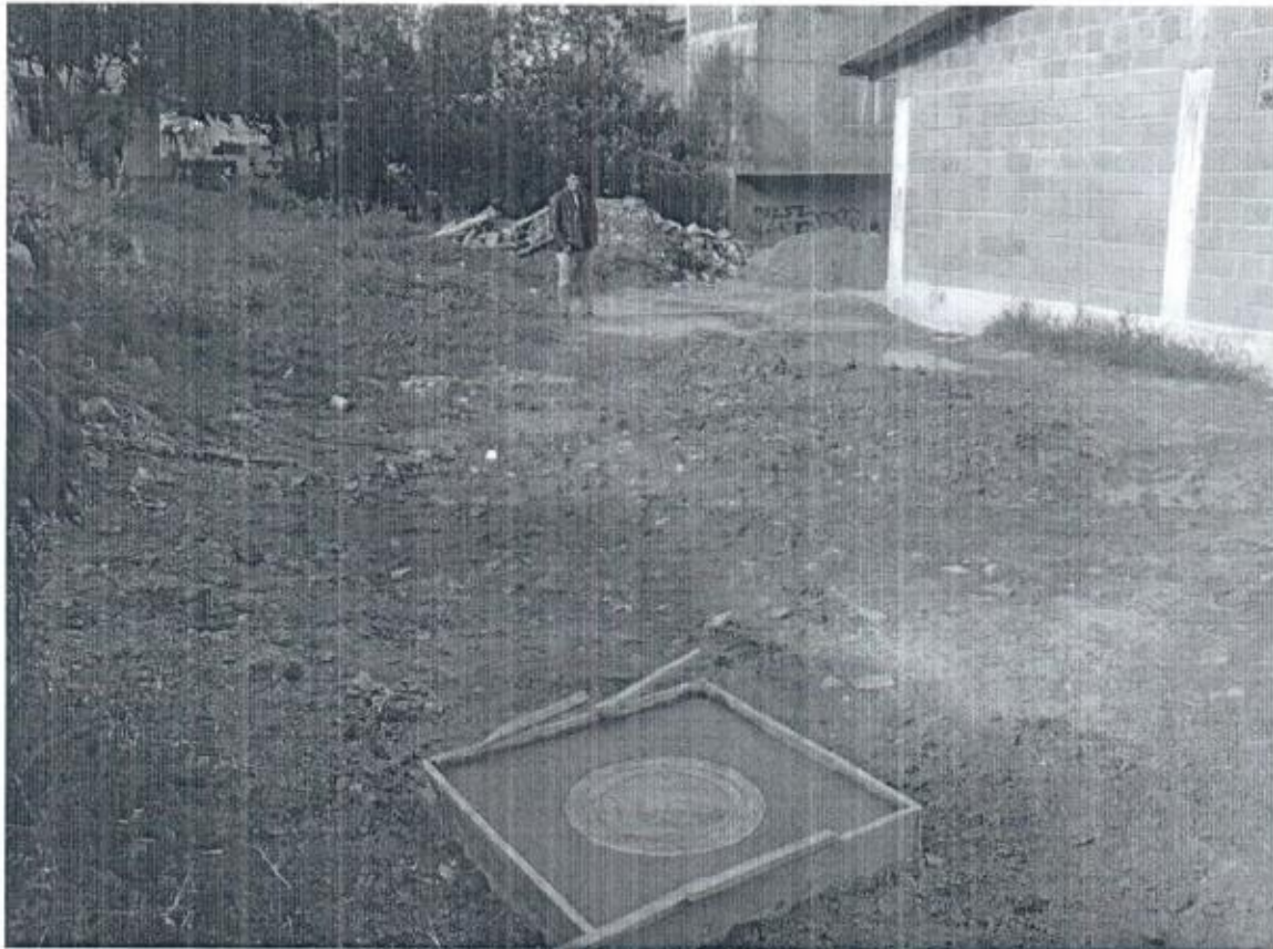
ESTADO FINAL DEL FRENTE DE OBRA
