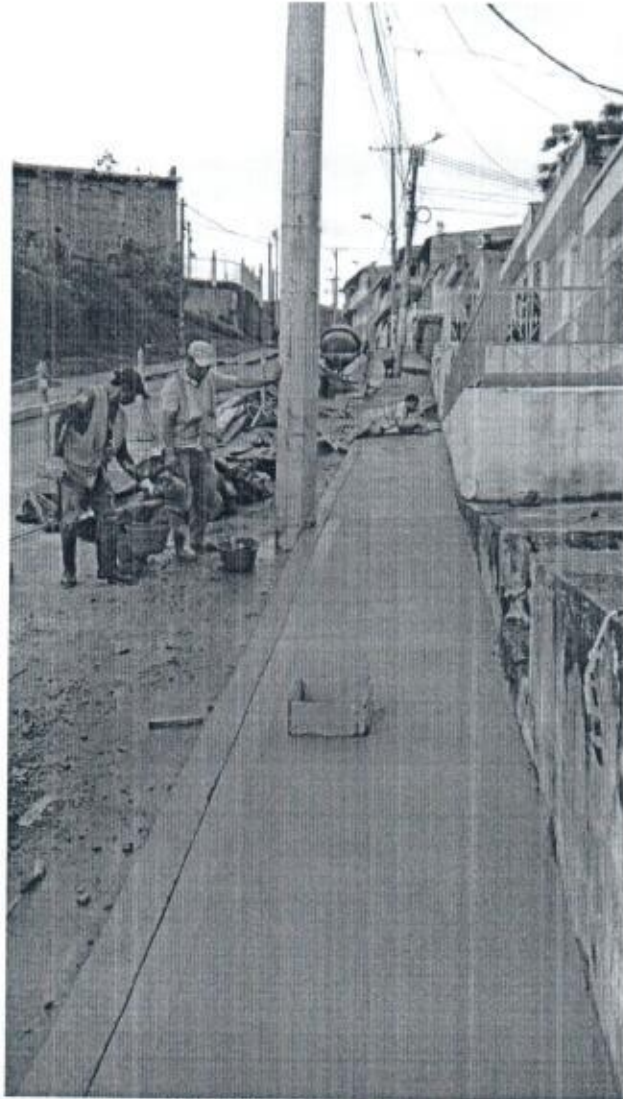
VACIADO DE ACERA
