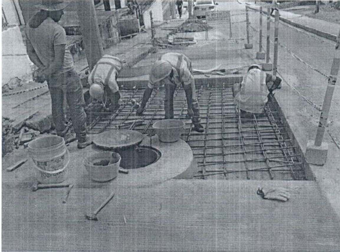
INSTALACION DE ACERO
