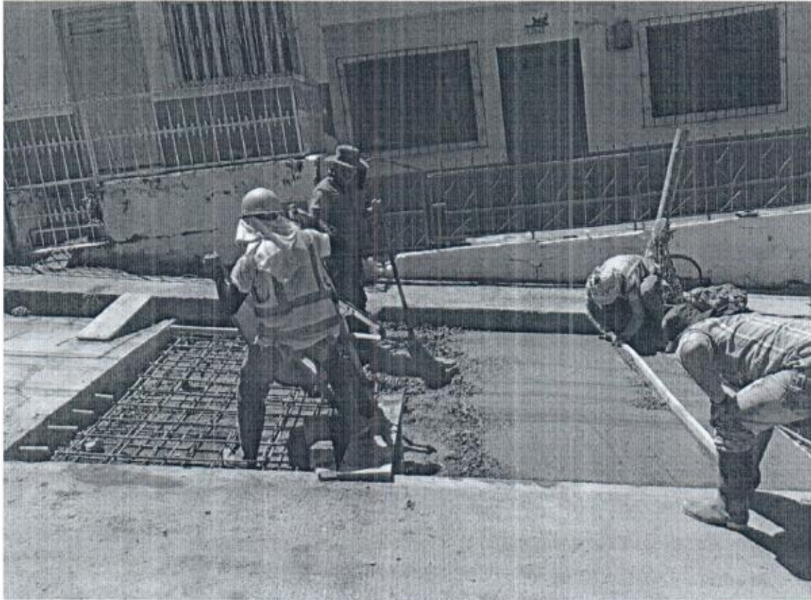
VACIADO DE PAVIMENTO
