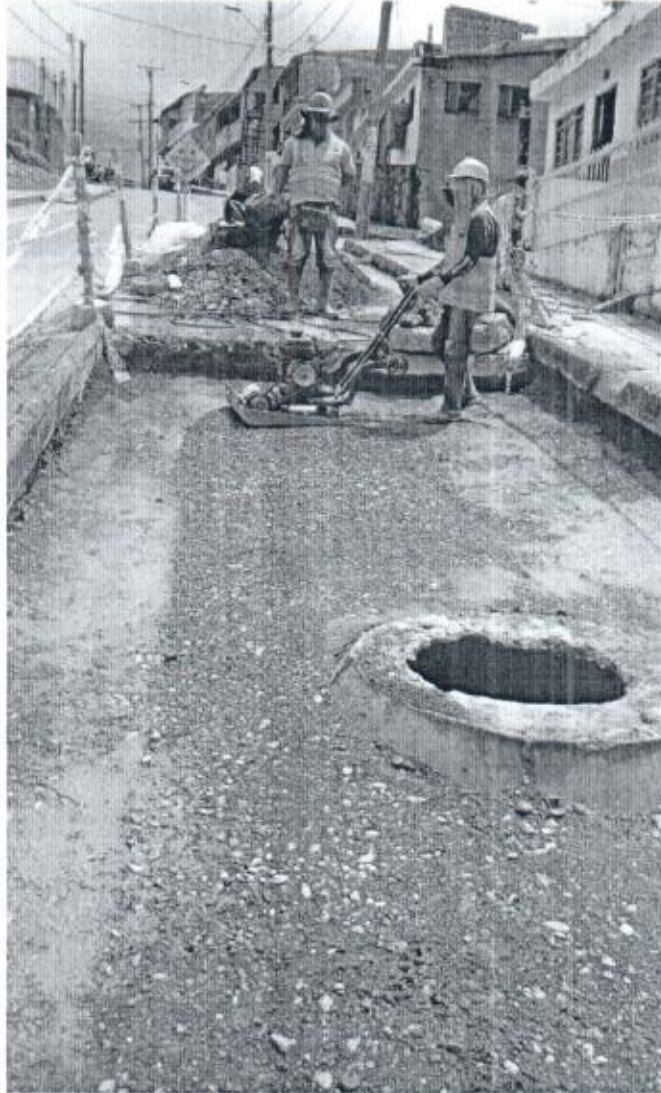
INSTALACION DE SUBBASE
