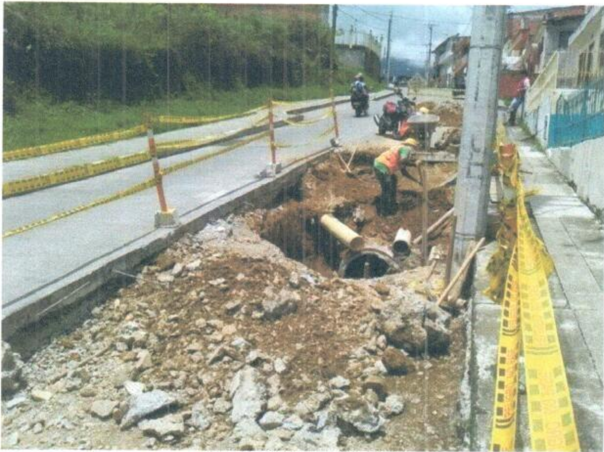
DEMOLICION DE CAMARA
