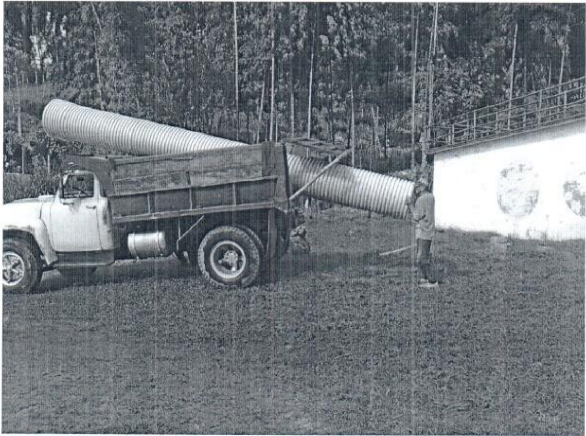
TUBERIA SUMINISTRADA POR EMPOCALDAS
