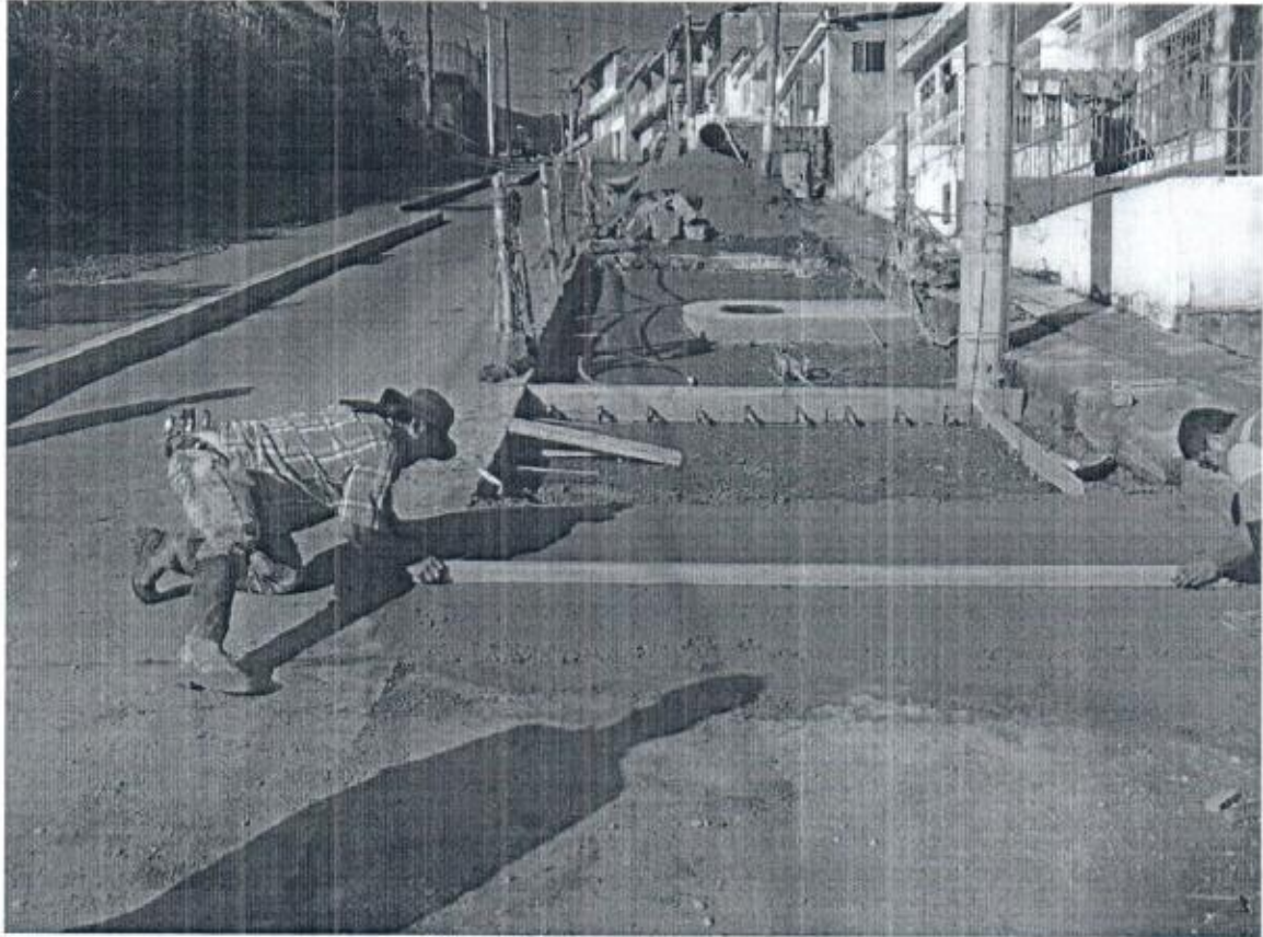
VACIADO DE PAVIMENTO
