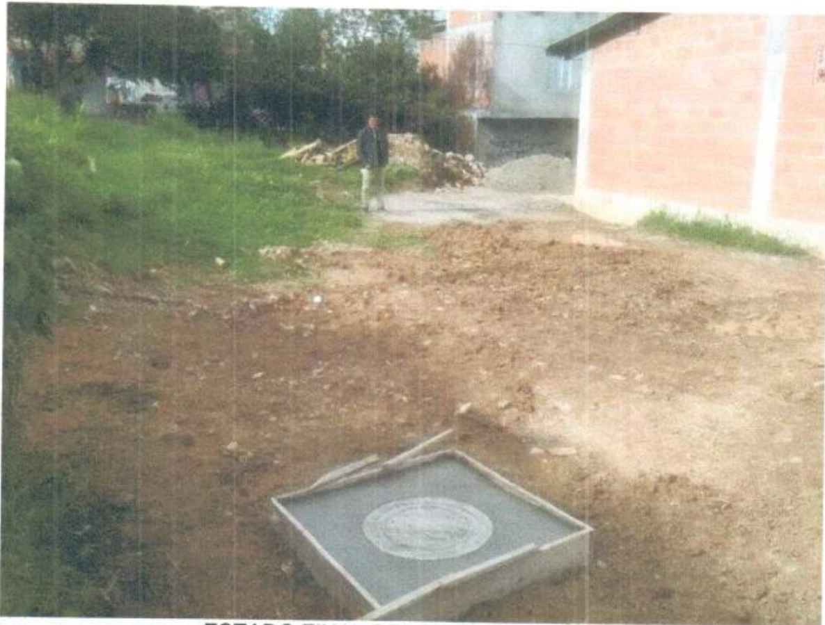
ESTADO FINAL DEL FRENTE DE OBRA
