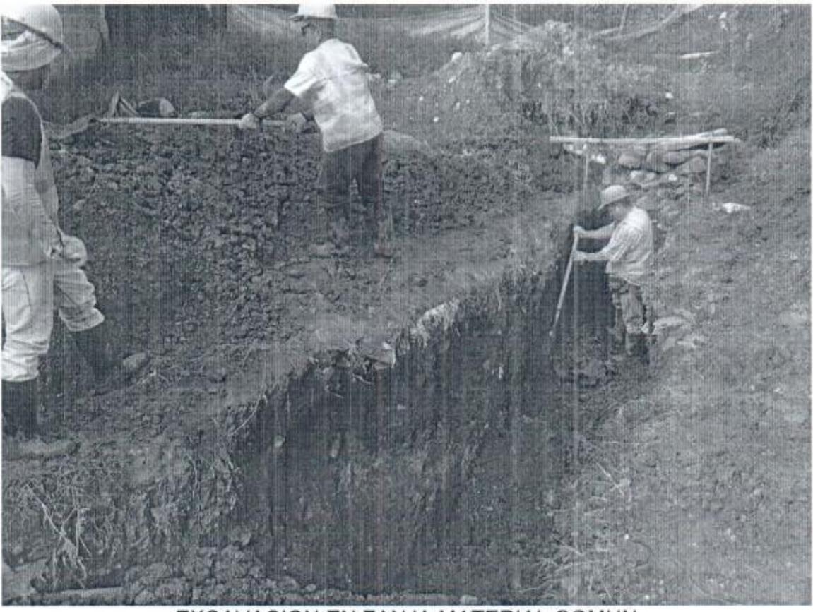
EXCAVACION EN ZANJA MATERIAL COMUN
