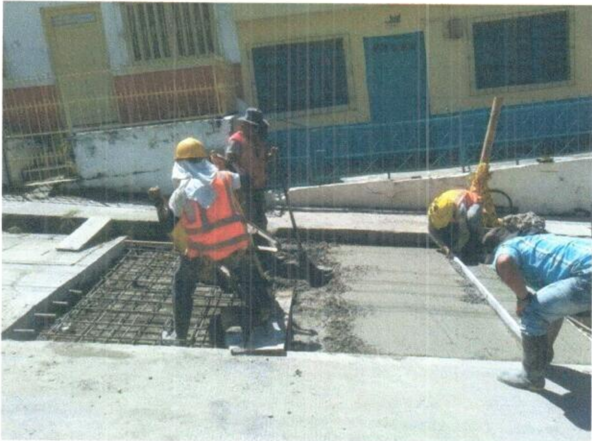
VACIADO DE PAVIMENTO
