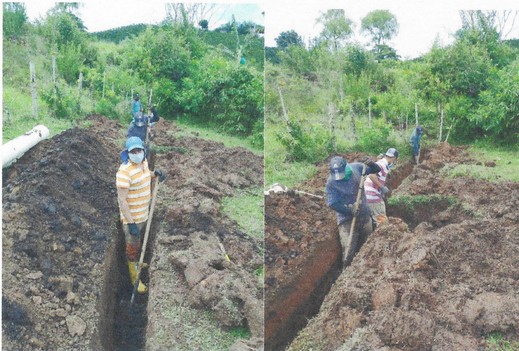
Imagen 2 y 3. Excavaciones en material común
