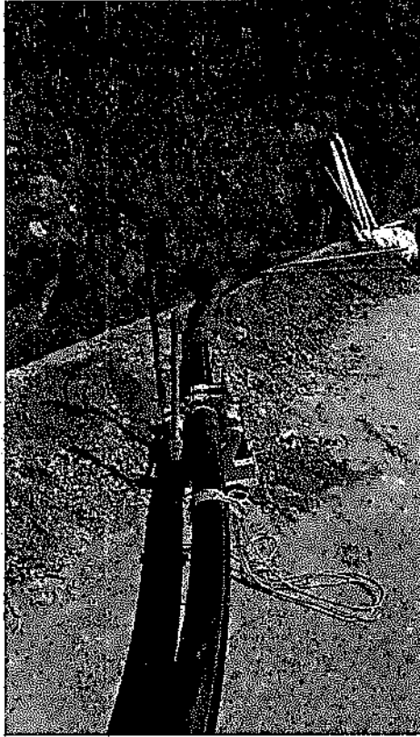
INSTALACIÓN DE TUBERÍA A UN COSTADO DE LA VÍA QUE CONDUCE DE SAN JOSE AL MUNICIPIO DE RISARALDA CADAS
