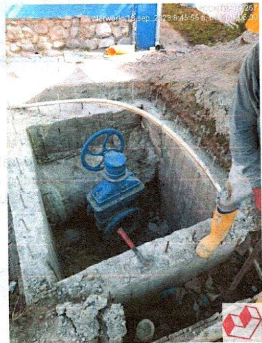
Ilustración 23: sobre-excavación en recamara de 1.8 x 1.4
