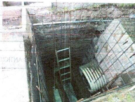
Ilustración 4: corte de tubería es concreto para cañuelas
