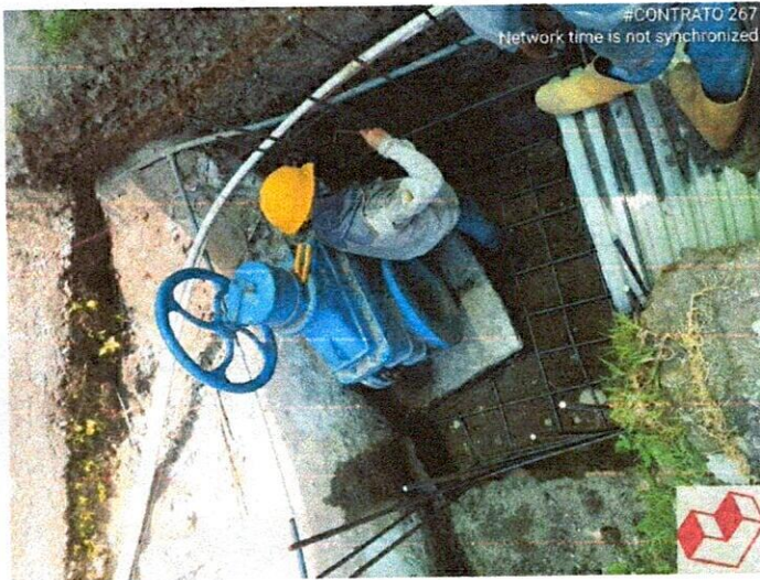
Ilustración 21: Acero de refuerzo para recamara de 1.8 x 1.4
