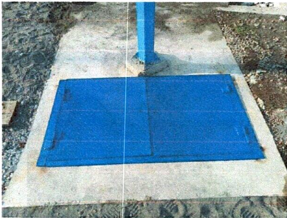
Ilustración 24: Tapa de recamara de 1,8 x 1,4
