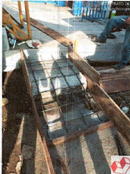
Ilustración 3: Acero para rampa
