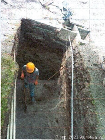
Ilustración 1: Excavación para instalación de tubería de 36"
