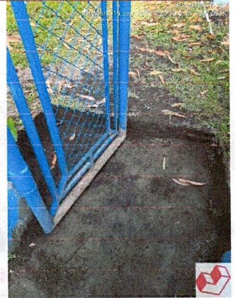
Ilustración 12: Excavación para habilitar puerta
