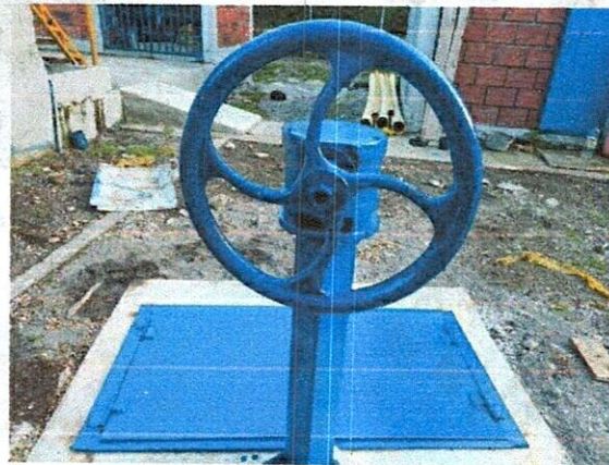
Ilustración 24: Tapa de recamara de 1,8 x 1,4
