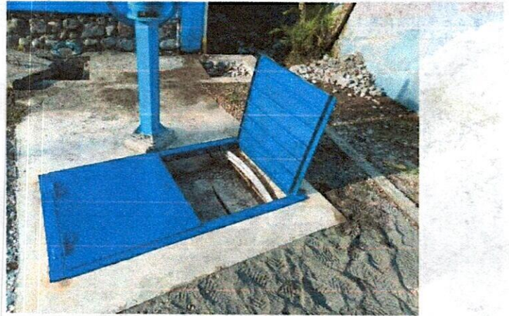
Ilustración 2513: Tapa de recamara de 1,8 x 1,4
