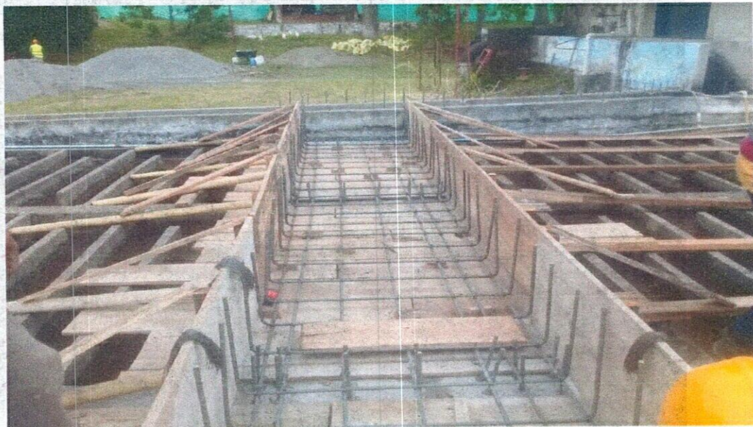
ENCOFRADO PARA FUNDICIÓN EN CONCRETO E INSTALACIÓN DE HIERRO
