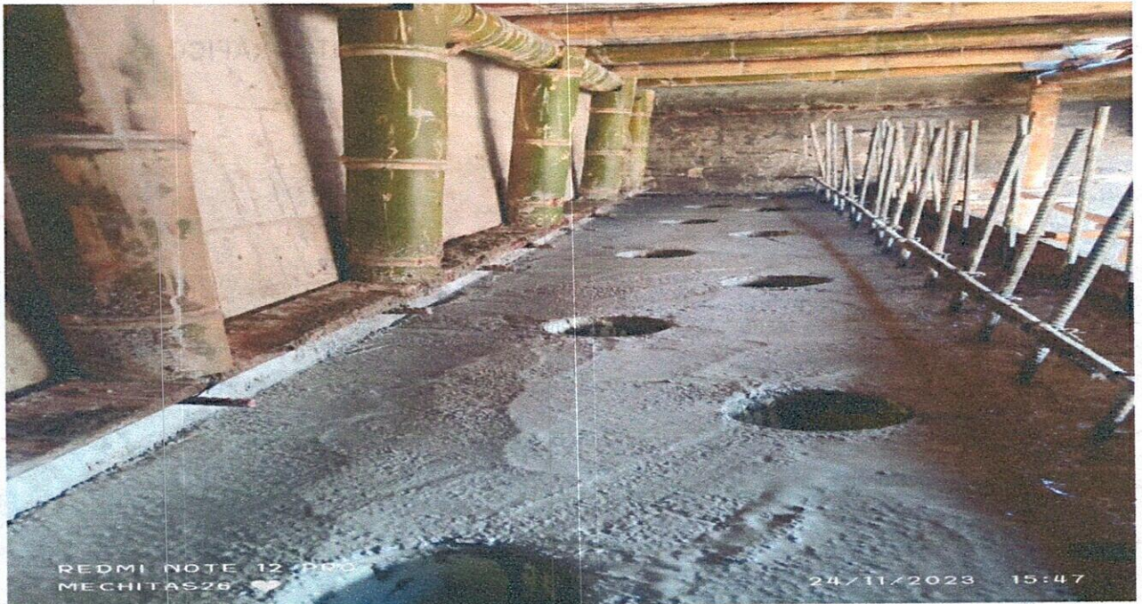
ACABADO EN CONCRETO REFORZADO
