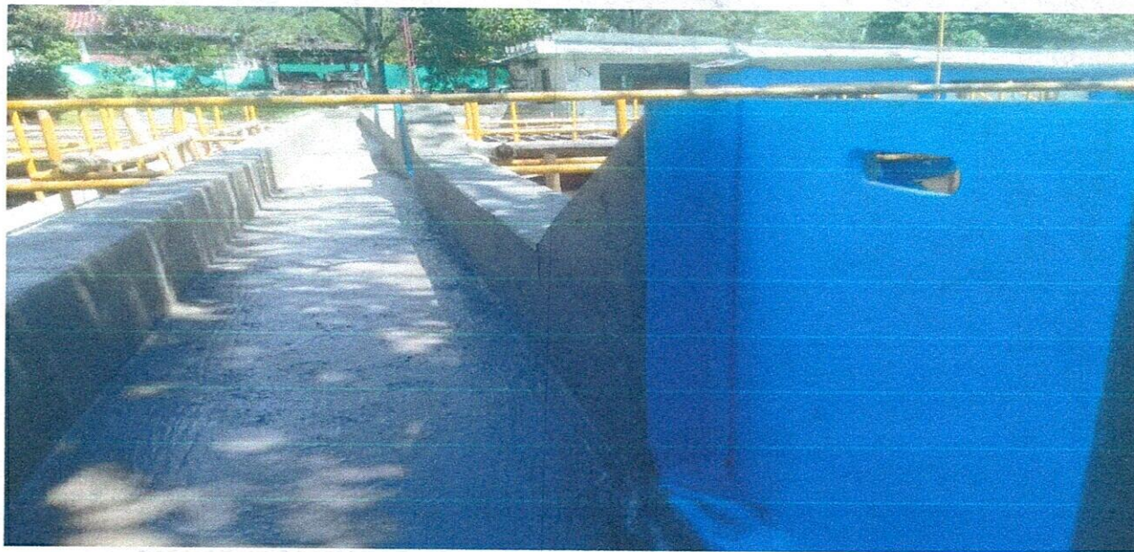
LOSA VACIADA EN CONCRETO REFORZADO
