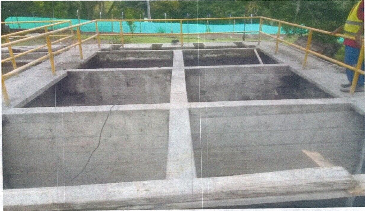
ACABADO DE TANQUES
