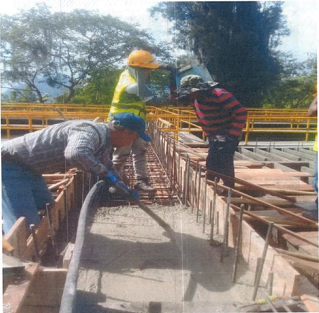
VACIADO EN CONCRETO INYECTADO
