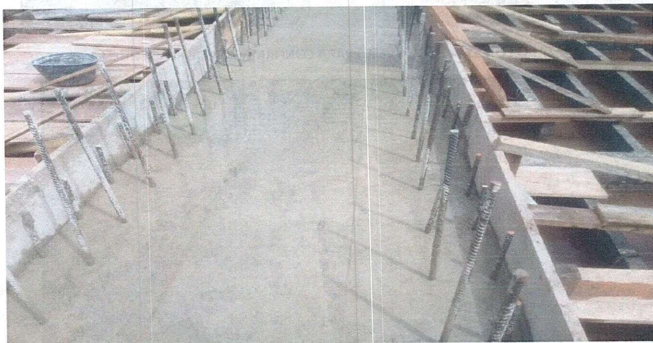
ACABADO EN CONCRETO REFORZADO
