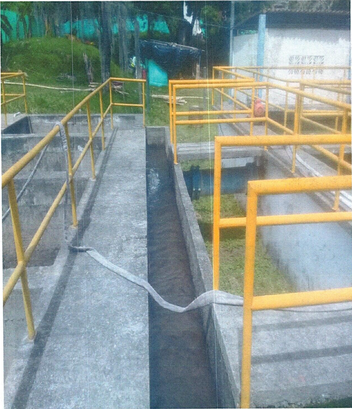
ACABADO FINAL DE CAMINADEROS EN CONCRETO CON BARANDAS METALICAS
