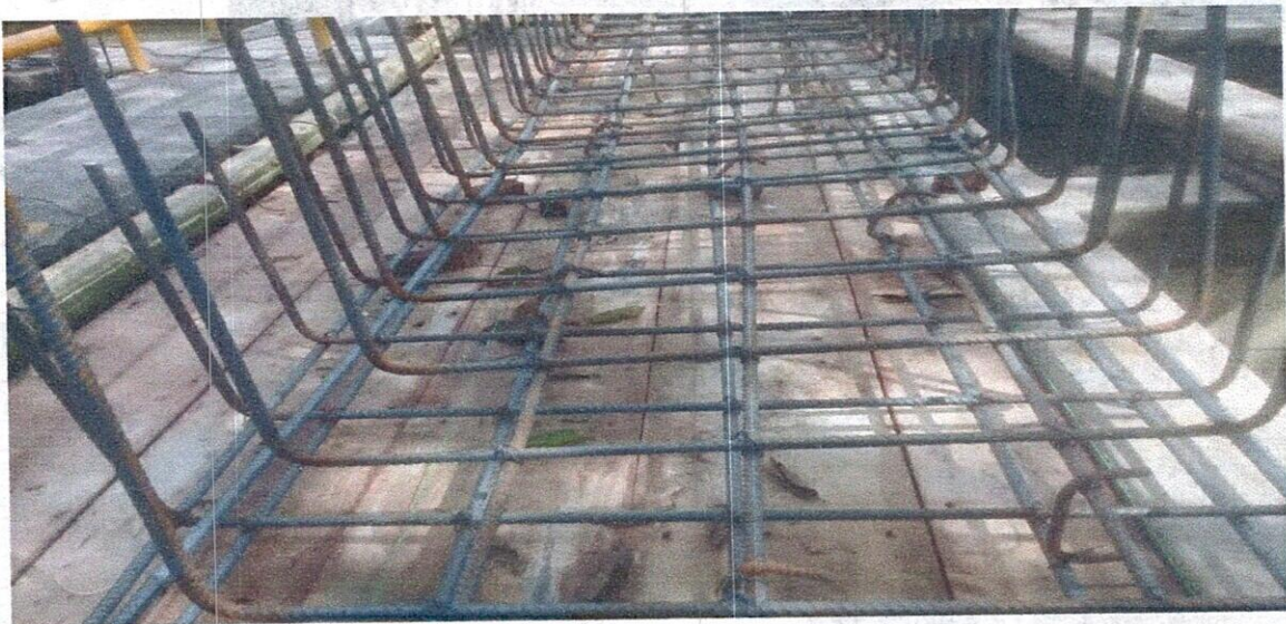
INSTALACIÓN Y FIGURADO DE HIERRO
