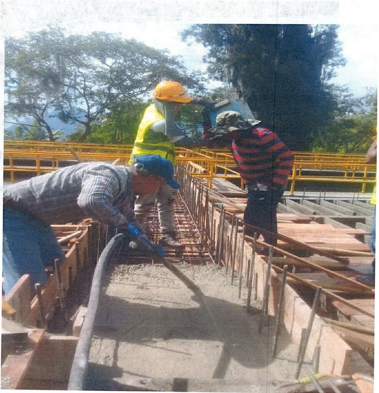
VACIADO EN CONCRETO INYECTADO
