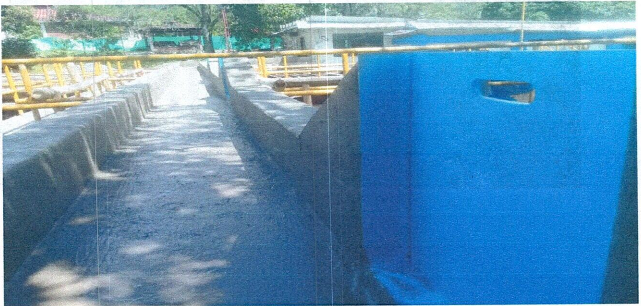
LOSA VACIADA EN CONCRETO REFORZADO
