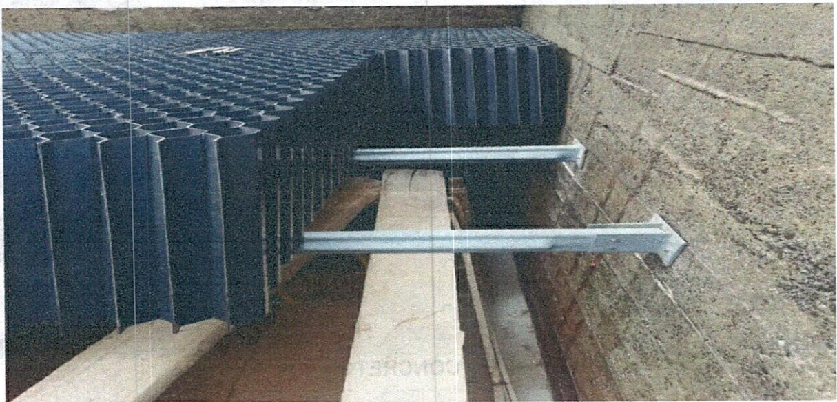
INSTALACIÓN DE VIGAS METÁLICAS
