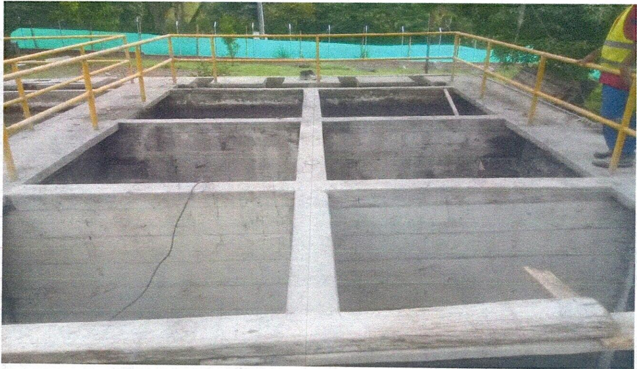
ACABADO DE TANQUES
