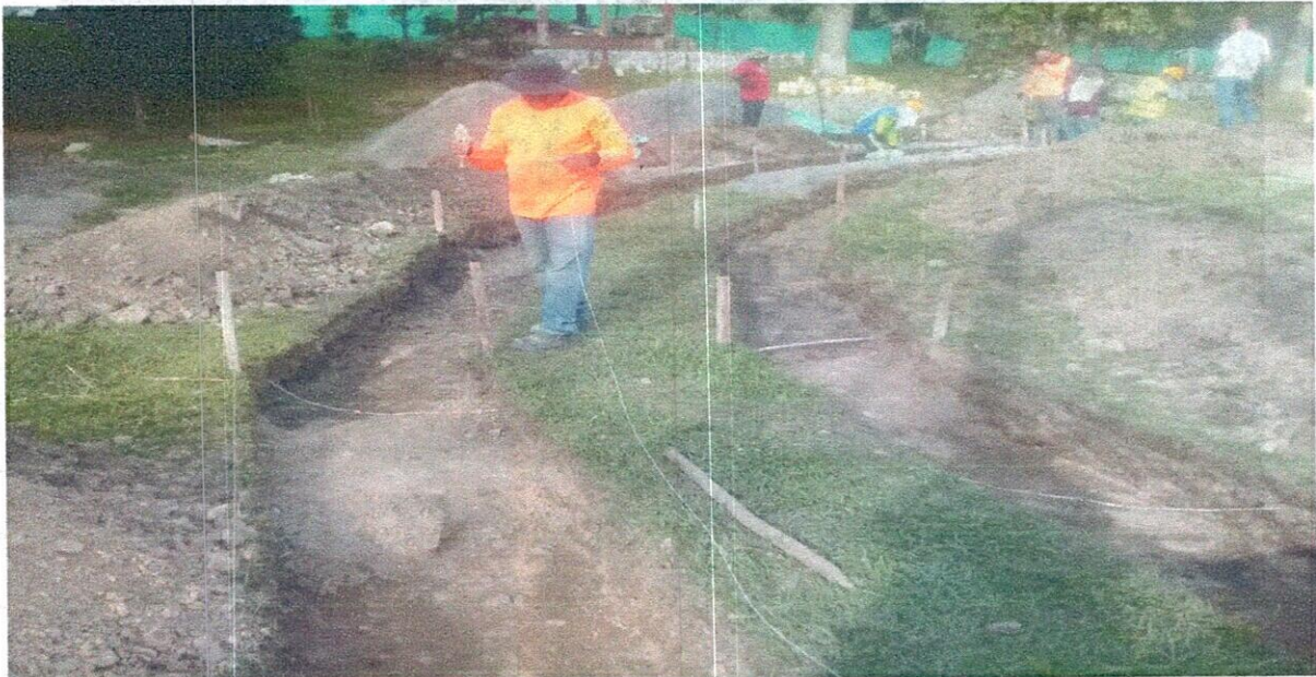
TRAZADO CON ESTACAS Y NIVELES PARA CONFIRMACIÓN DE PLACA HUELLA
