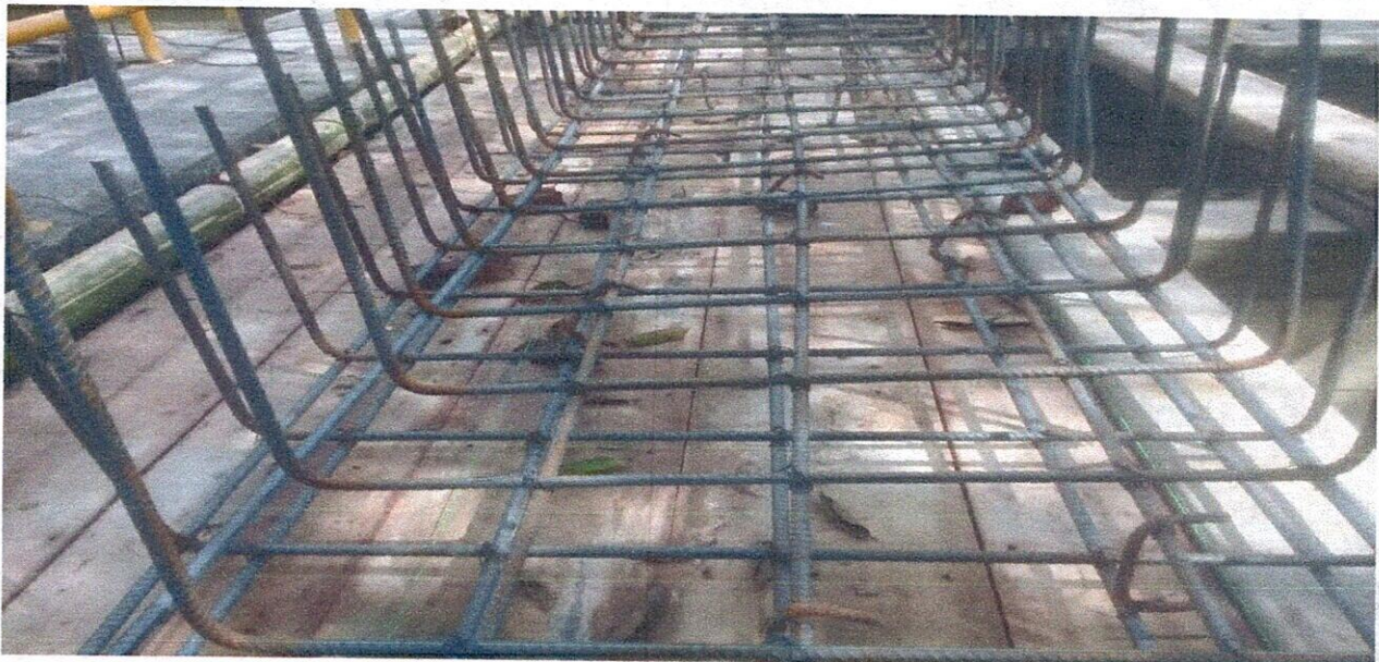
INSTALACIÓN Y FIGURADO DE HIERRO
