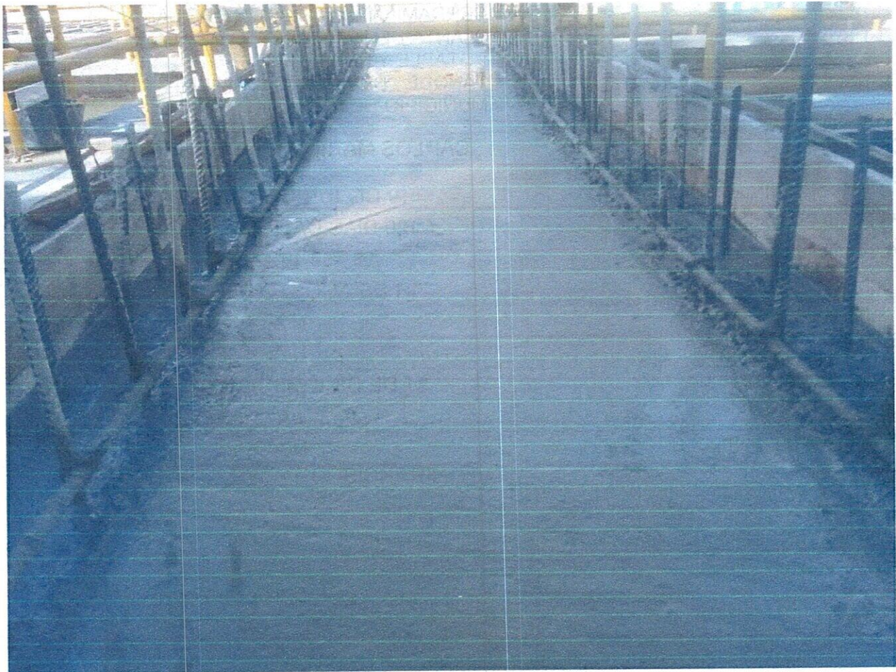
VACIADO EN CONCETO DE LOSA
