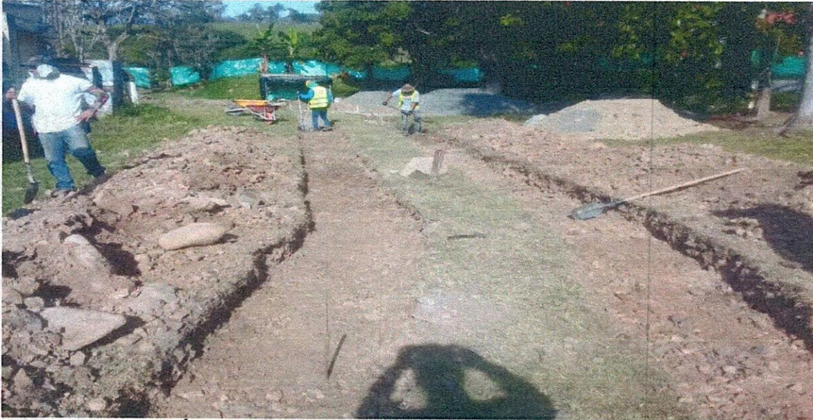
NIVELACIÓN DEL TERRENO POR LAS CINTAS EN CONCRETO
