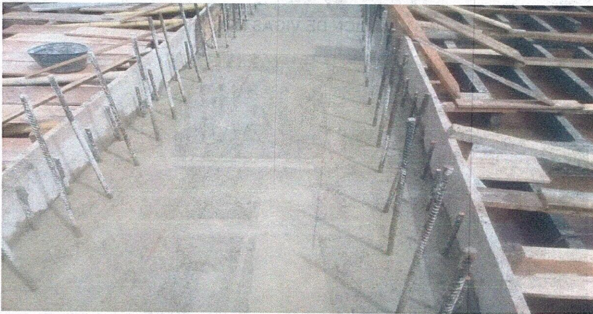
ACABADO EN CONCRETO REFORZADO
