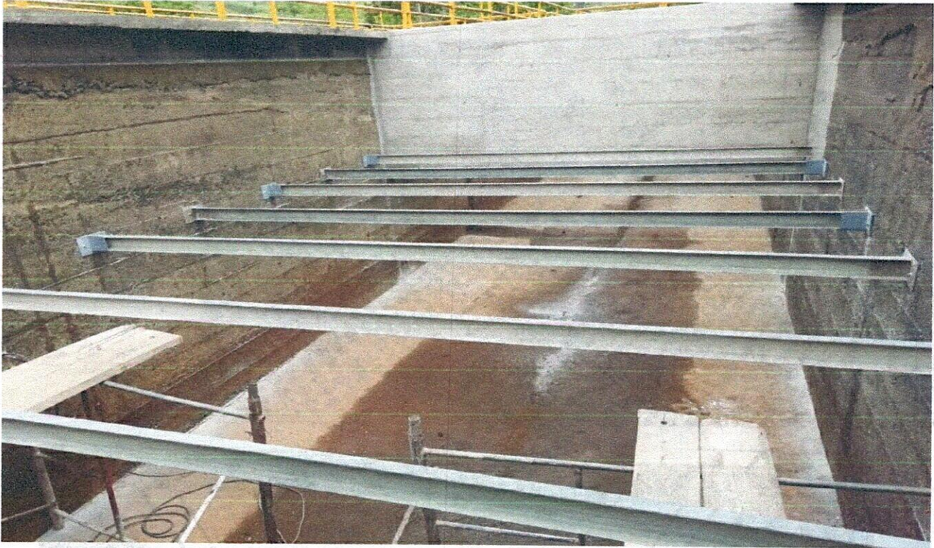
INSTALACIÓN DE VIGAS METÁLICAS
