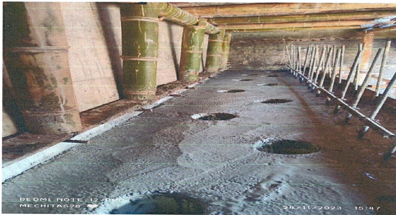
ACABADO EN CONCRETO REFORZADO
