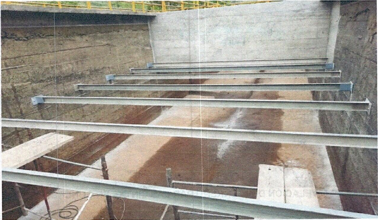
INSTALACIÓN DE VIGAS METÁLICAS
