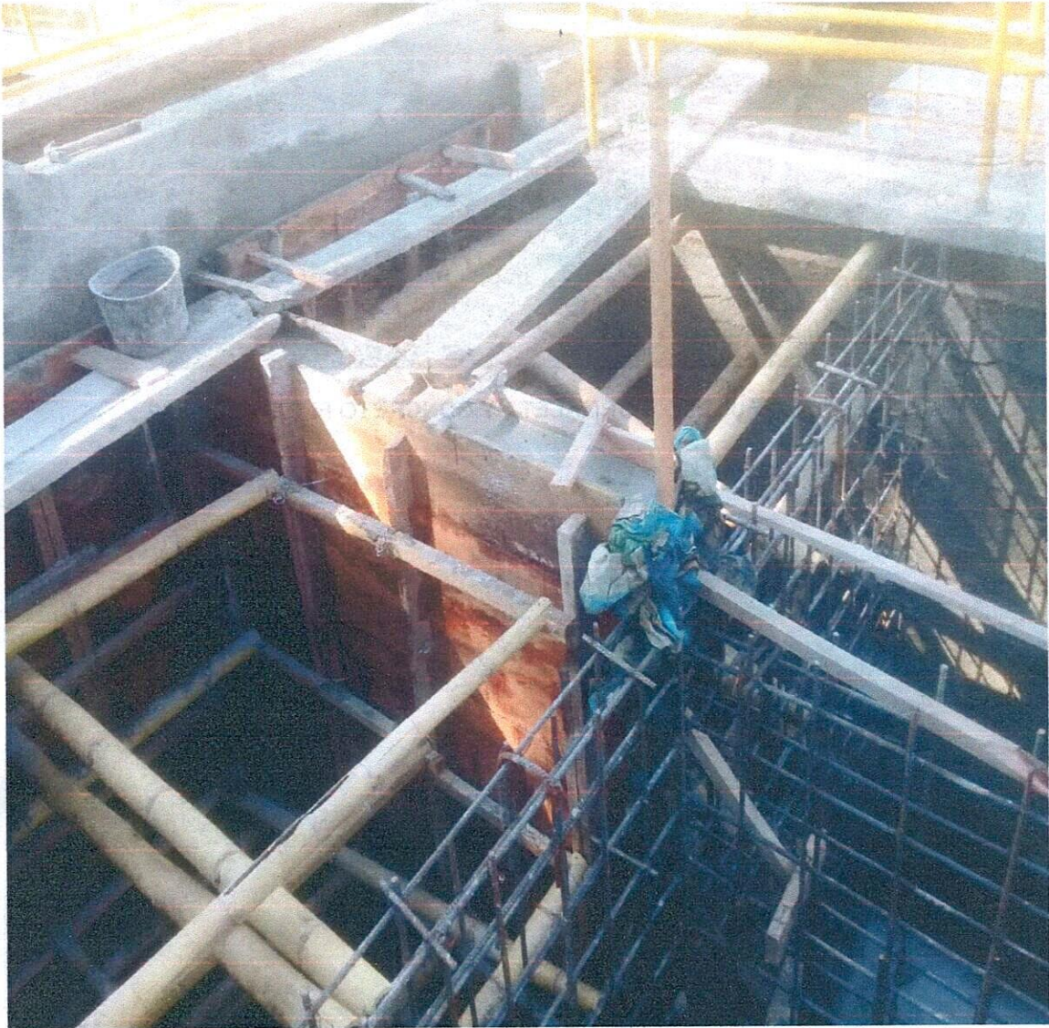
ACERO DE REFUERZO, FORMAleta Y CONCRETO FLOCULADOR 2
