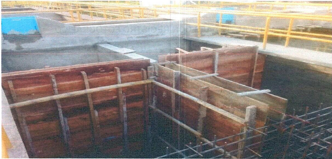
ACERO DE REFUERZO, FORMAleta Y CONCRETO FLOCULADOR 2
