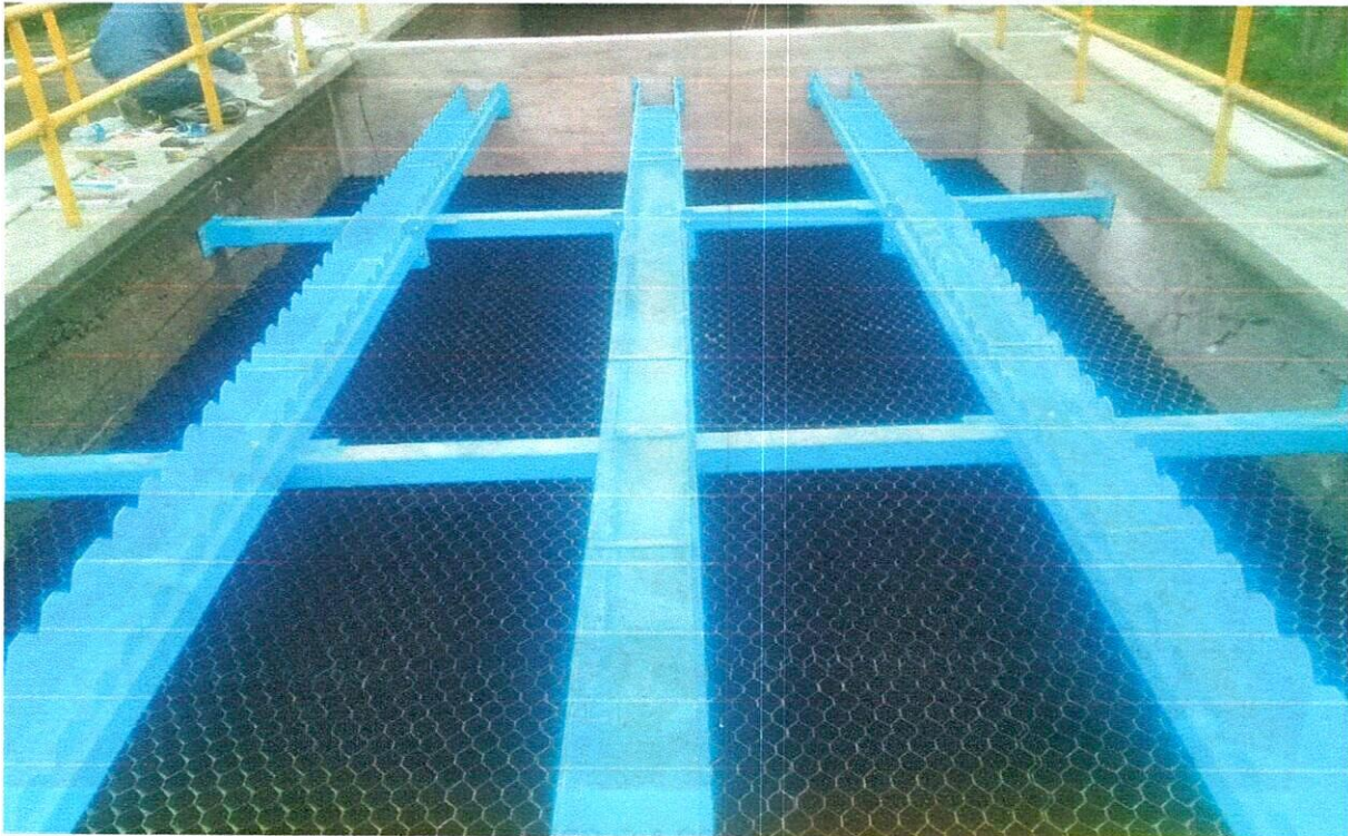
CANALETA DE RECOLECCIÓN Y MÓDULO DE SEDIMENTADOR 2
