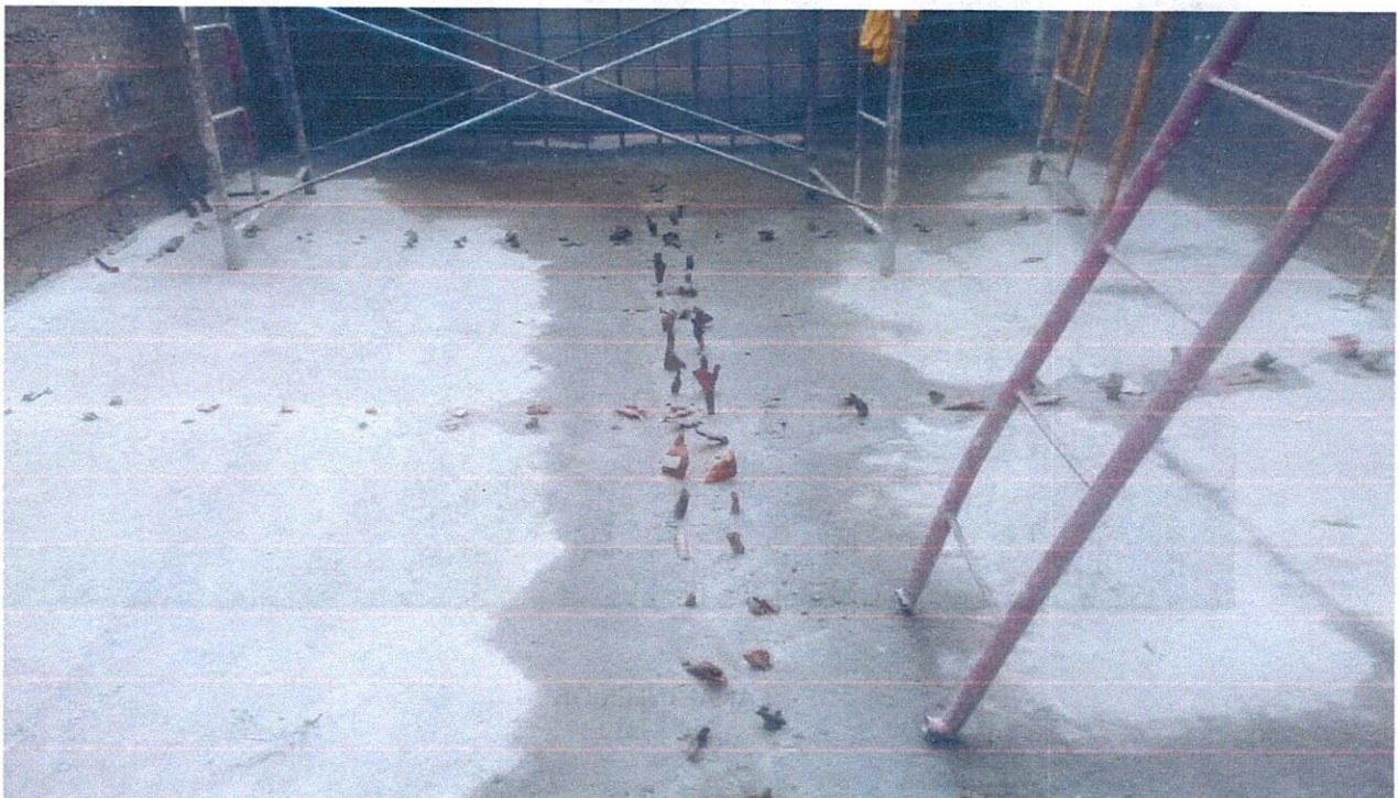
PERFORACIÓN PARA ANCLAJES FLOCULADOR 2
