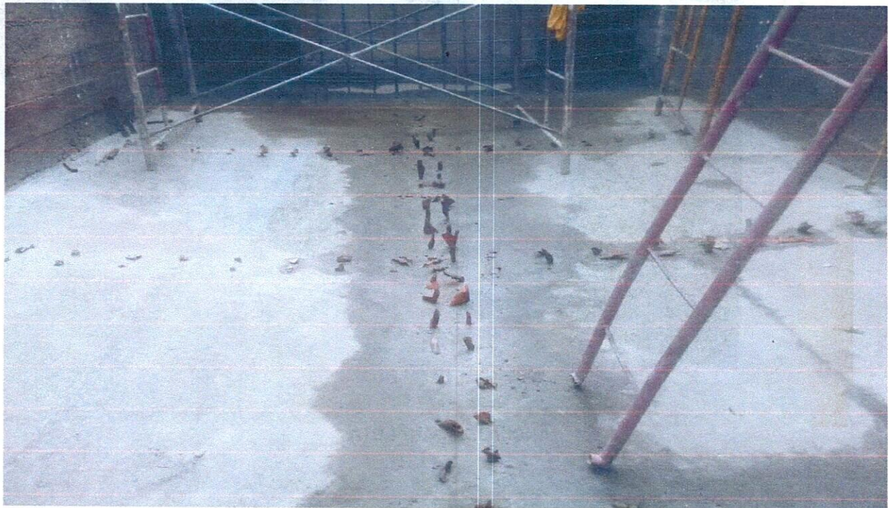
PERFORACIÓN PARA ANCLAJES FLOCULADOR 2
