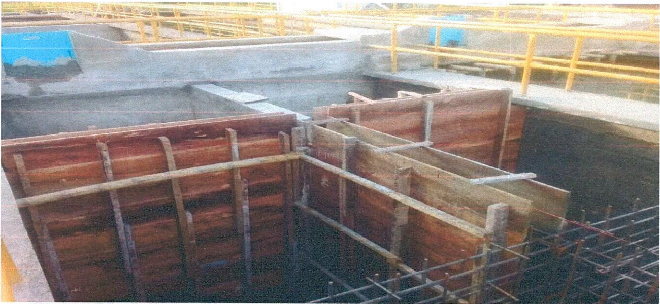
ACERO DE REFUERZO, FORMALETA Y CONCRETO FLOCULADOR 2
