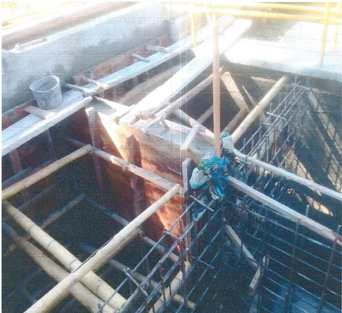
ACERO DE REFUERZO, FORMALETA Y CONCRETO FLOCULADOR 2
