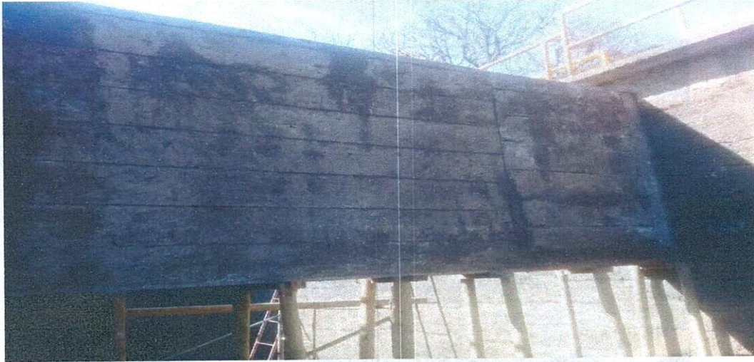
CONCRETO PARA MURO INTERIOR DEL TANQUE
