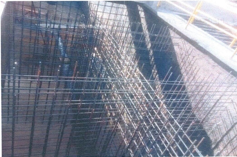
ACERO DE REFUERZO, FORMAleta Y CONCRETO FLOCULADOR
