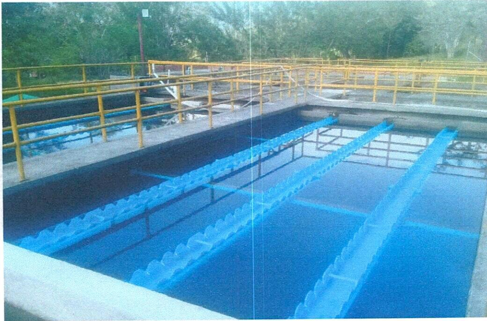
ANCLAJE DE CANALETA
