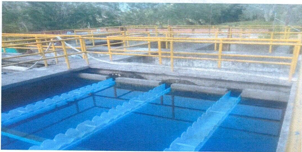
ANCLAJE DE CANALETA
