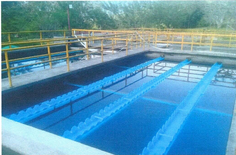
ANCLAJE DE CANALETA
