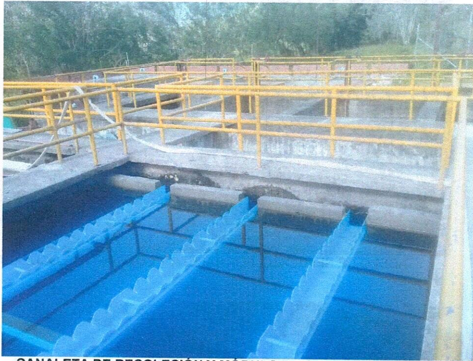
CANALETA DE RECOLECCIÓN Y MÓDULO DE SEDIMENTADOR
