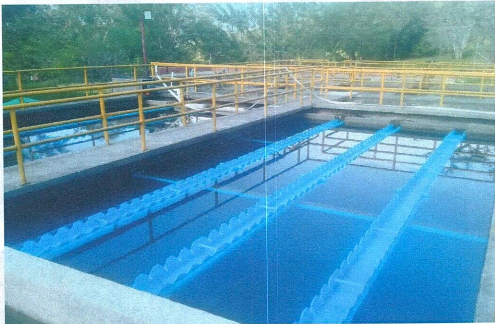
ANCLAJE DE CANALETA
