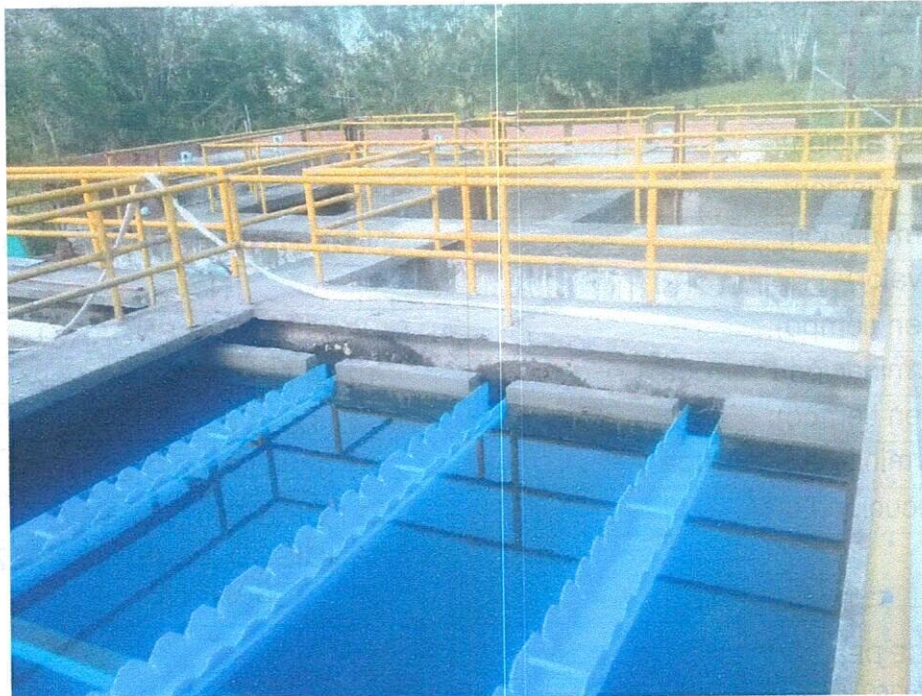
CANALETA DE RECOLECCIÓN Y MÓDULO DE SEDIMENTADOR
