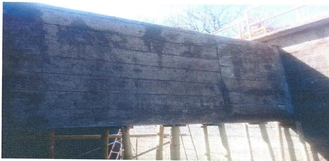
CONCRETO PARA MURO INTERIOR DEL TANQUE
