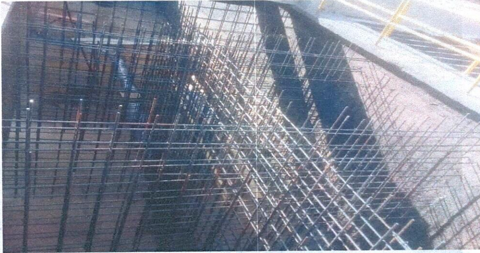
ACERO DE REFUERZO, FORMALETA Y CONCRETO FLOCULADOR
