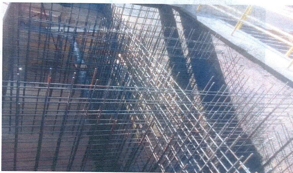
ACERO DE REFUERZO, FORMALETA Y CONCRETO FLOCULADOR
