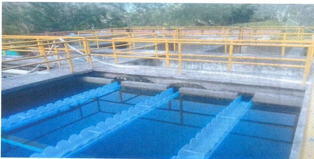
ANCLAJE DE CANALETA
