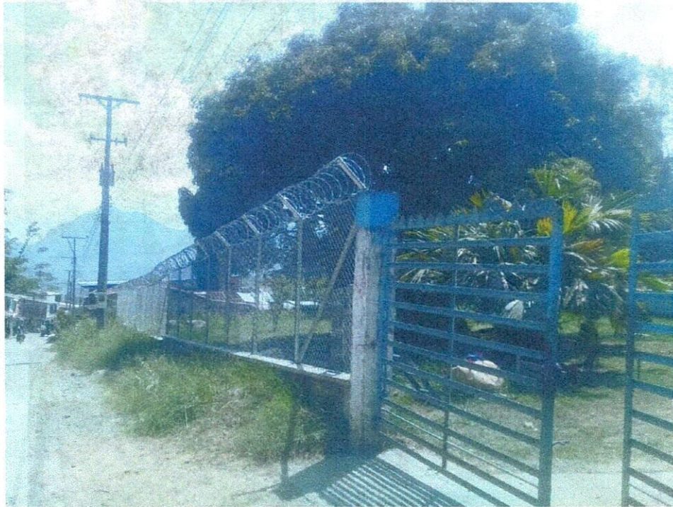
INSTALACIÓN DE CONCERTINA EN ACERO INOXIDABLE
