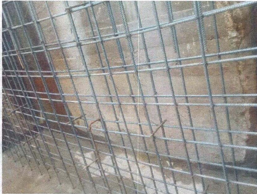
CERO DE REFUERZO EN PANTALLA NUEVA FLOCULADOR 2
