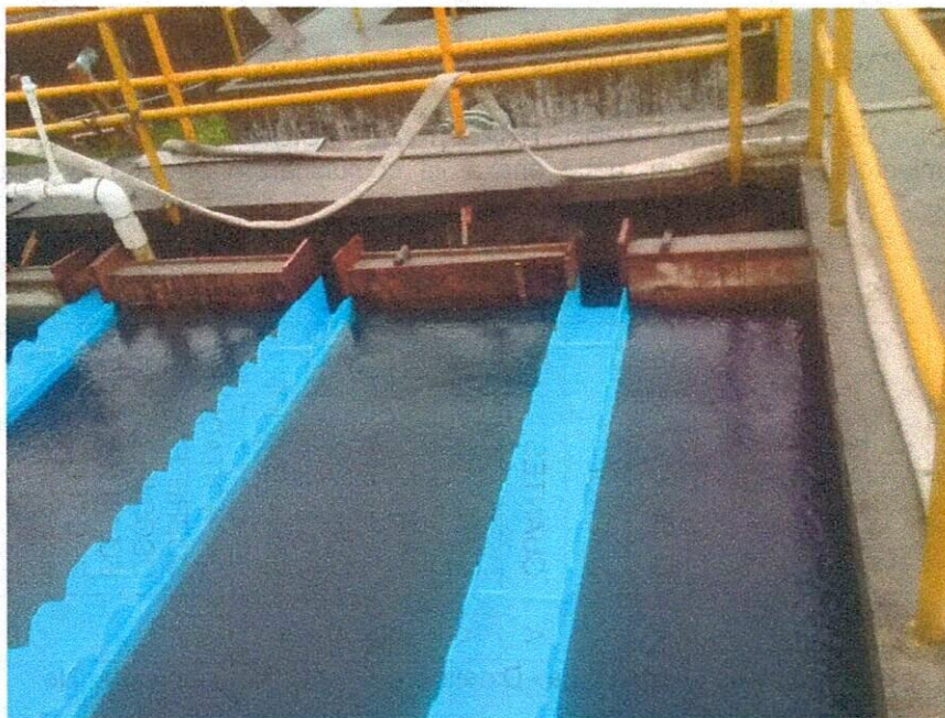
DEMOLICION VIGA PARA APOYAR CANALETA EN SEDIMENTADOR
