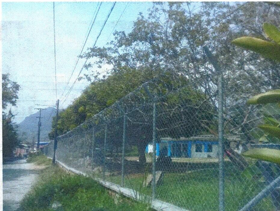
INSTALACIÓN DE CONCERTINA EN ACERO INOXIDABLE
