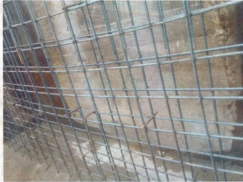
ACERO DE REFUERZO EN PANTALLA NUEVA FLOCULADOR 2
