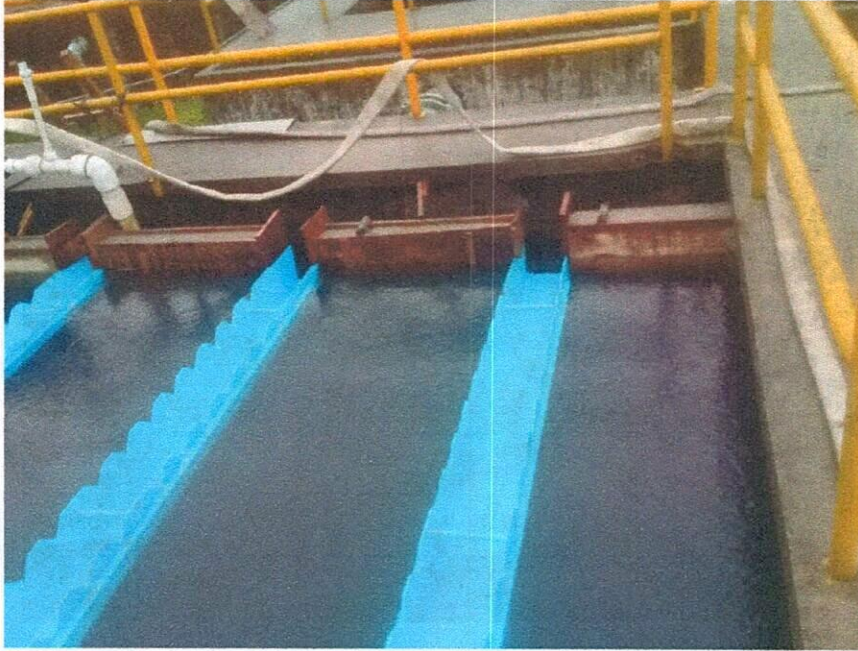
DEMOLICIÓN VIGA PARA APOYAR CANALETA EN SEDIMENTADOR
