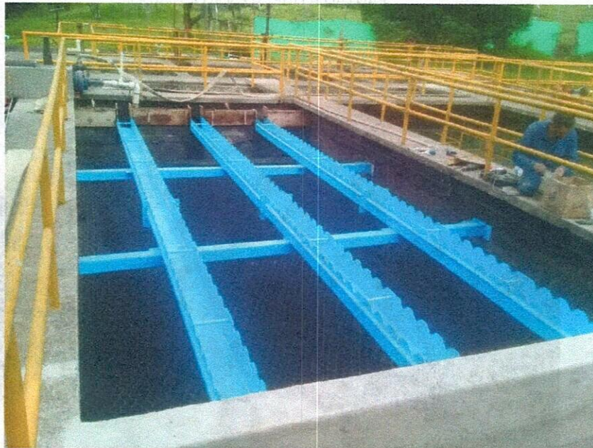
DEMOLICION VIGA PARA APOYAR CANALETA EN SEDIMENTADOR
