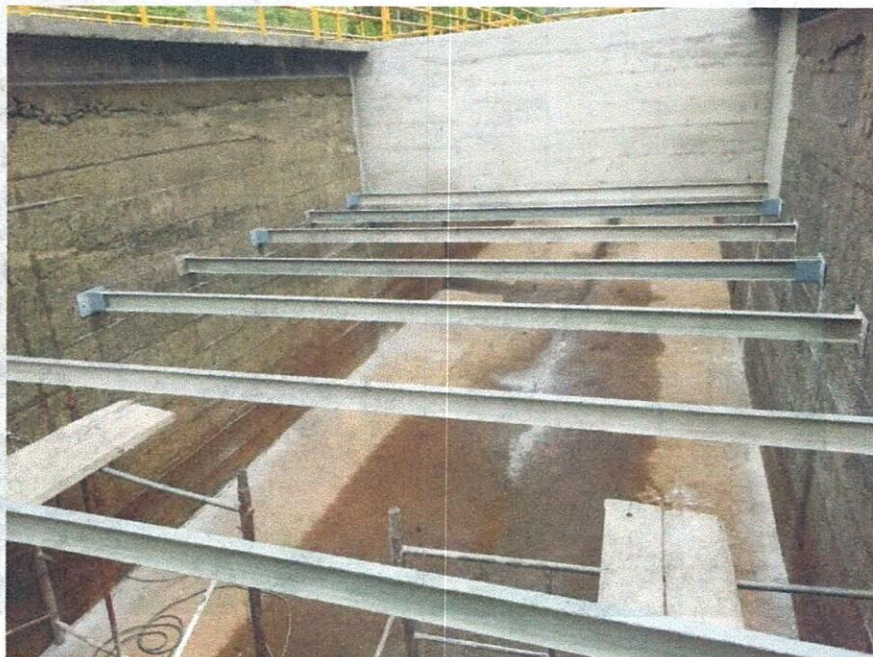
ELEMENTOS ACCELERADOS CON SIKA SET
