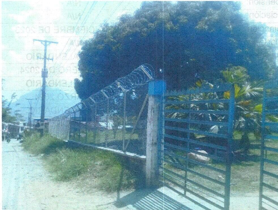
INSTALACIÓN DE CONCERTINA EN ACERO INOXIDABLE
