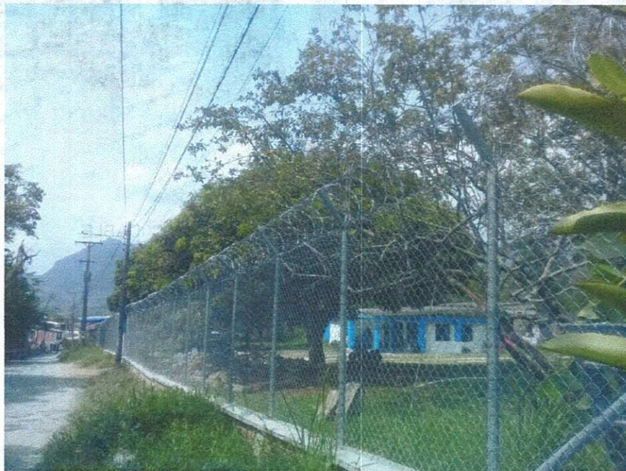
INSTALACIÓN DE CONCERTINA EN ACERO INOXIDABLE
