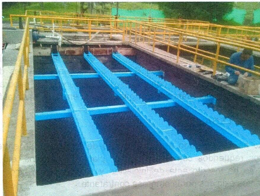
DEMOLICION VIGA PARA APOYAR CANALETA EN SEDIMENTADOR
