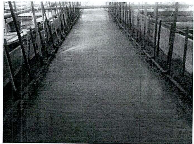
VACIADO CANAL DE ENTRADA DE AGUA MEZCLADA
