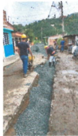
Imagen 6 Barrio el Túnel
