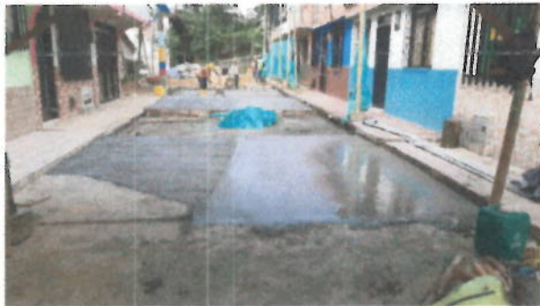
Imagen 3 Calle 4A entre carrera 8 y 9
