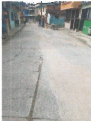
Imagen 7 Barrio el Túnel
