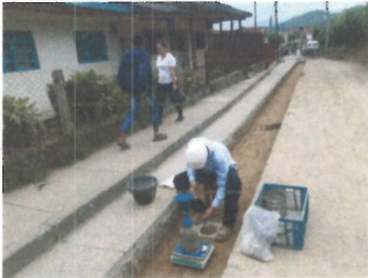
Imagen 5 Barrio el Túnel
