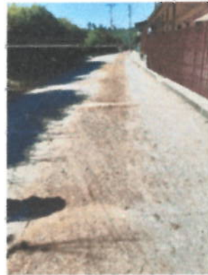
Imagen 8 Barrio el Túnel
