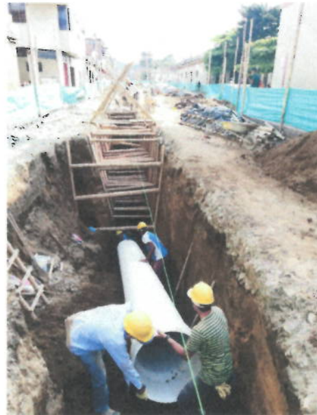
Imagen 4 Calle 13 entre carrera 5 Y 6
