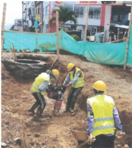
Imagen 3 Calle 13 entre carrera 5 Y 6
