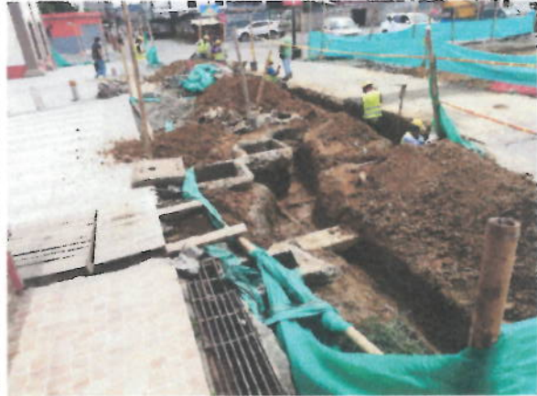
Imagen 6 Calle 13 entre carrera 7 y 5
