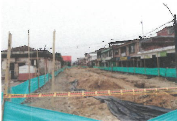
Imagen 7 Calle 13 entre carrera 7 y 6
