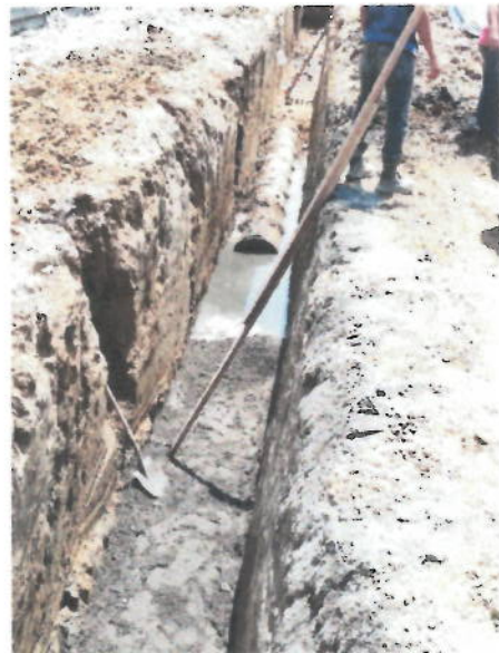
Imagen 3 Calle 13 entre carrera 7 y 6
