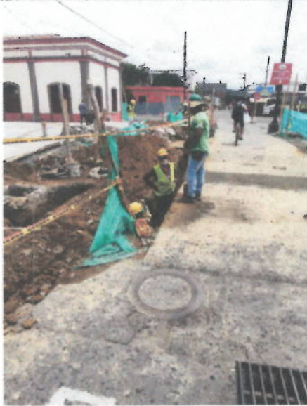
Imagen 5 Calle 13 entre carrera 7 y 5
