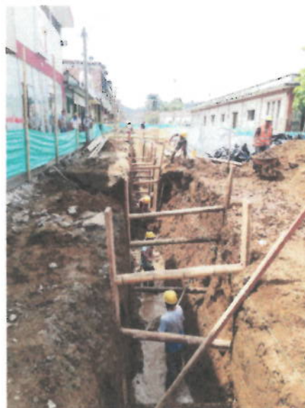
Imagen 8 Calle 13 entre carrera 7 y 6
