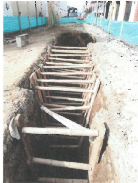
Imagen 2 Calle 13 entre carrera 5 Y 6
