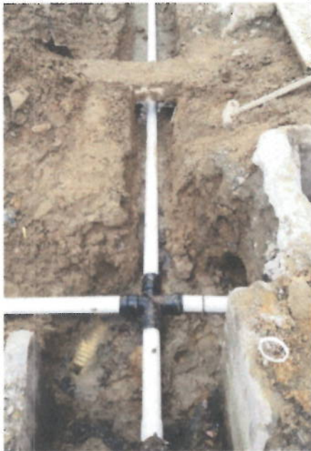
Imagen 7 Calle 13 entre carrera 7 y 5
