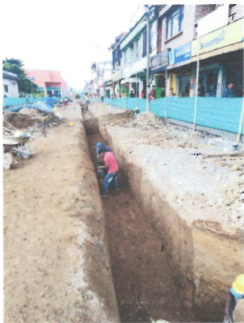
Imagen 5 Calle 13 entre carrera 7 y 6
