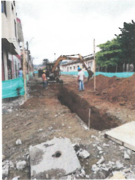
Imagen 1 Calle 13 entre carrera 7 y 6
