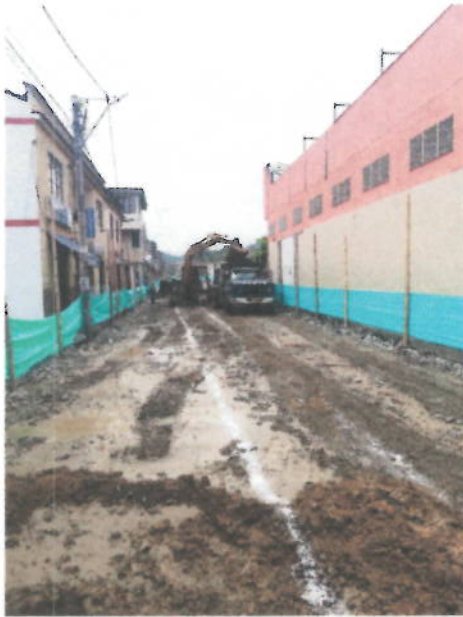
Imagen 1 Calle 13 entre carrera 6 Y 5
