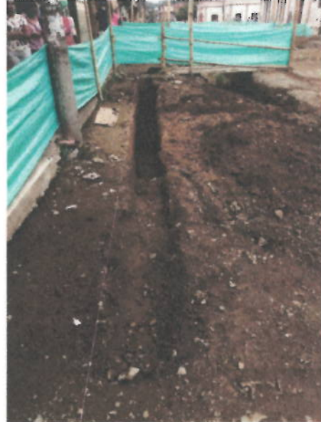
Imagen 2 Calle 13 entre carrera 7 y 5
