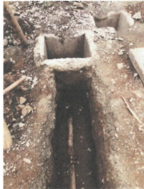
Imagen 6 Calle 13 entre carrera 7 y 5
