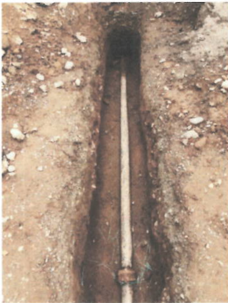
Imagen 5 Calle 13 entre carrera 7 y 5
