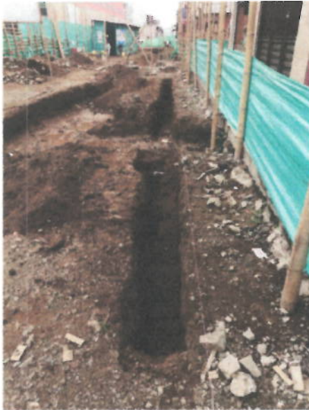
Imagen 4 Calle 13 entre carrera 7 y 5
