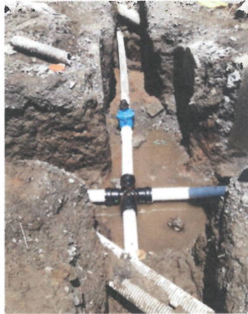
Imagen 8 Calle 13 entre carrera 7 y 5
