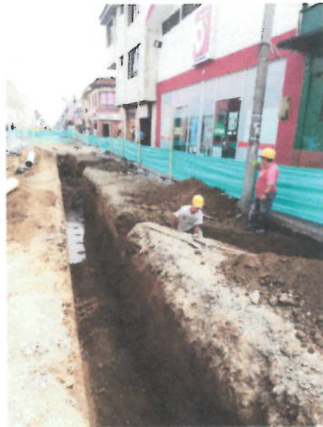
Imagen 2 Calle 13 entre carrera 7 y 6
