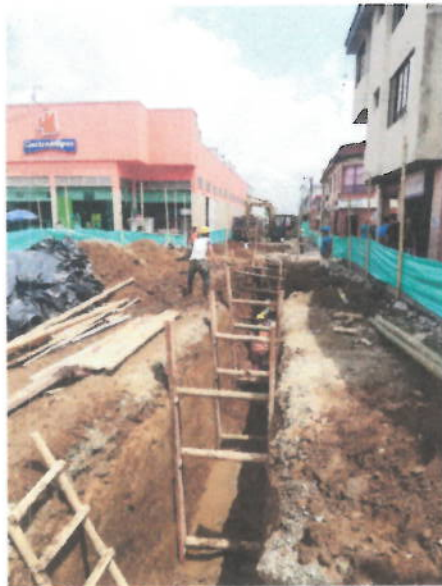
Imagen 2 Calle 13 entre carrera 7 y 6
