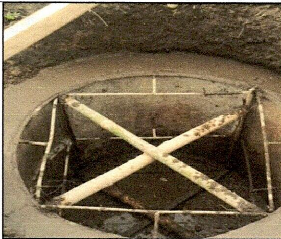
FOTO 13. Cámara de caída D=1.5, H<3,04
