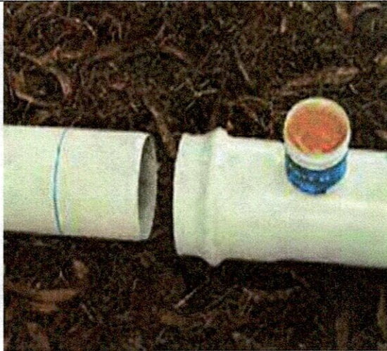
FOTO 14. Empalme tubería acueducto
