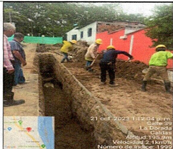
FOTO 12. Rellenos compactados con material de la obra.
