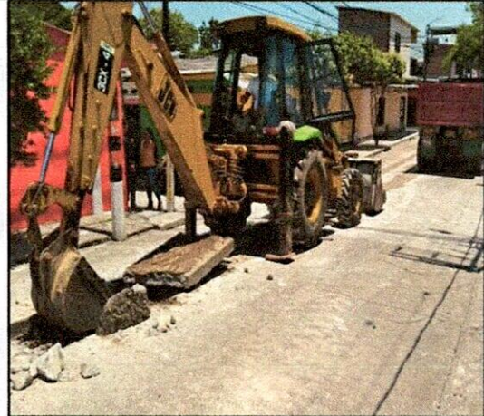
FOTO 4. Demolición de pavimento en concreto hidráulico
