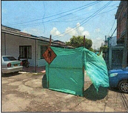
FOTO 3. Suministro, transporte e instalación señales preventivas.
