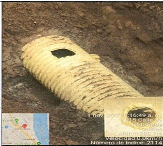
FOTO 9. Instalación empalme para PVC corrugada de 16 X 6.
