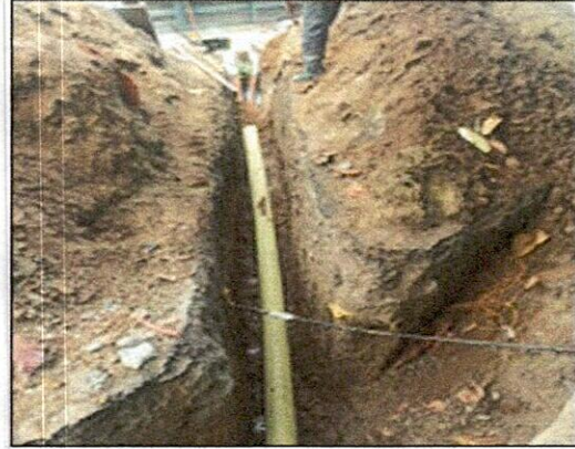
FOTO 8. Instalación tubería 6" – Domiciliarias
