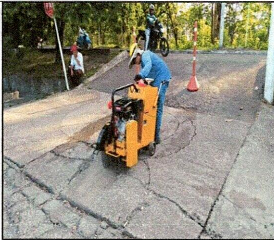
FOTO 5. Corte mecanizado de pavimento
