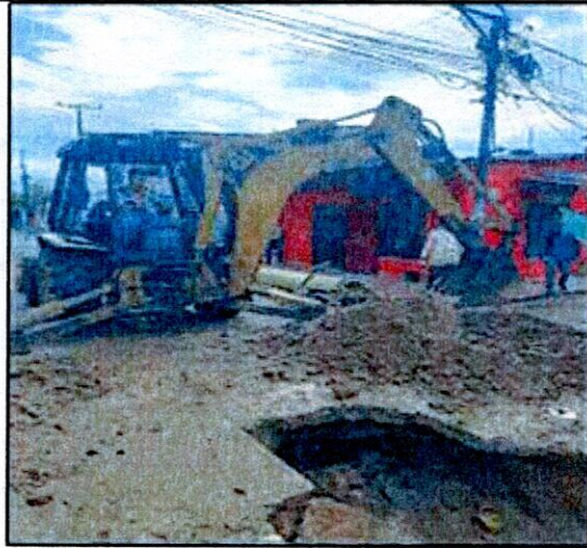
FOTO 3. Demolición de pavimento en concreto hidráulico.
