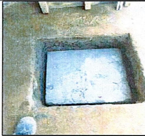
FOTO 11. Caja de inspección domiciliaria de 0,50m x 0,50m en concreto 3000 psi (incluye base, cañuela y tapa en concreto)
