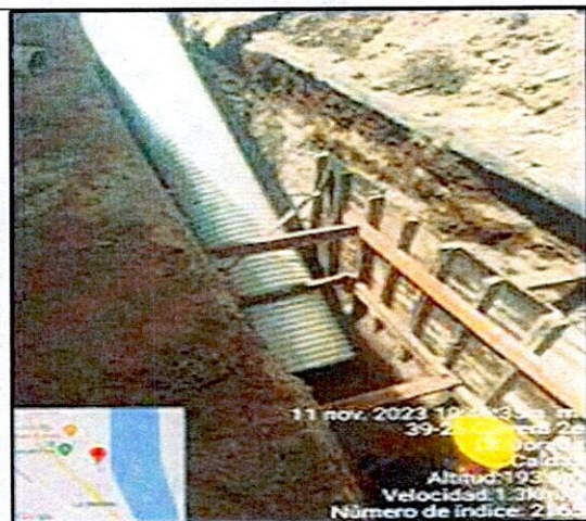
FOTO 7. Instalación de tubería PVC corrugada.
