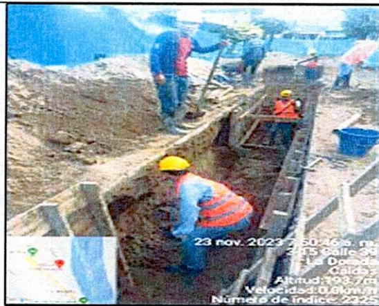
FOTO 6. Excavación en zanja - Material común 0,0 a 2,0 Mts
