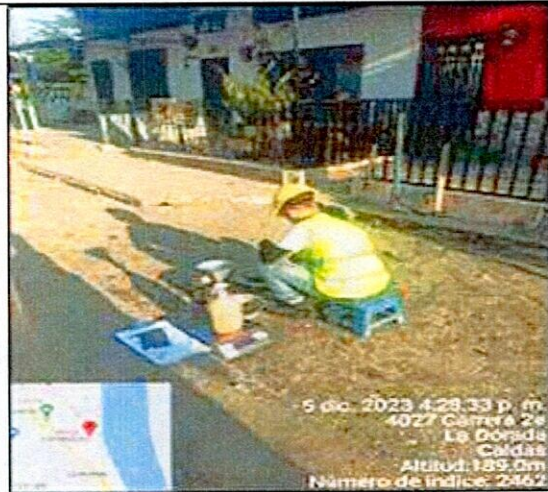
FOTO 16. Instalación de Sub Base.
