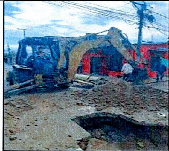
FOTO 4. Demolición de pavimento en concreto hidráulico.
