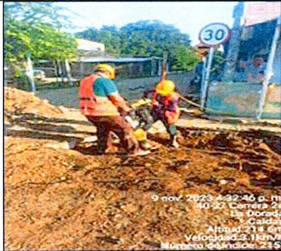
FOTO 14. Rellenos compactados con material de la obra
