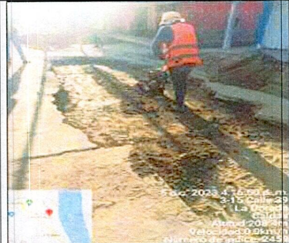
FOTO 17. Instalación de Sub Base.
