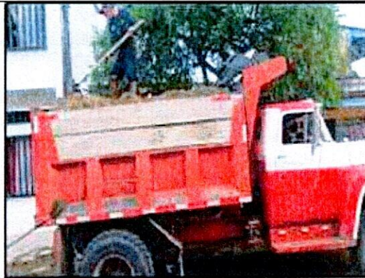
FOTO 18. Instalación de Sub Base.
