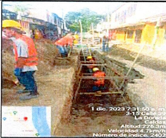
FOTO 5. Excavación en zanja - Material común 0,0 a 2,0 Mts
