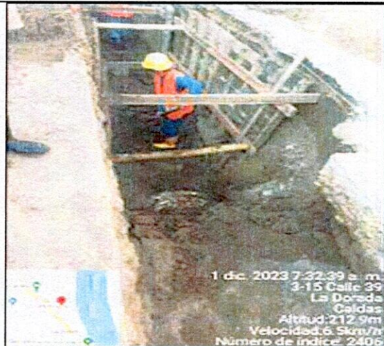
FOTO 14. Entibado horizontal/vertical tipo 2
