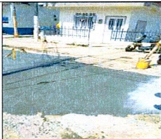
FOTO 20. Instalación de Pavimento MR 42
