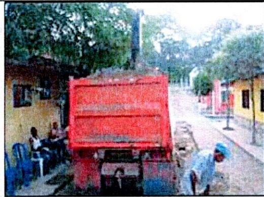
FOTO 19. Instalación de Sub Base.
