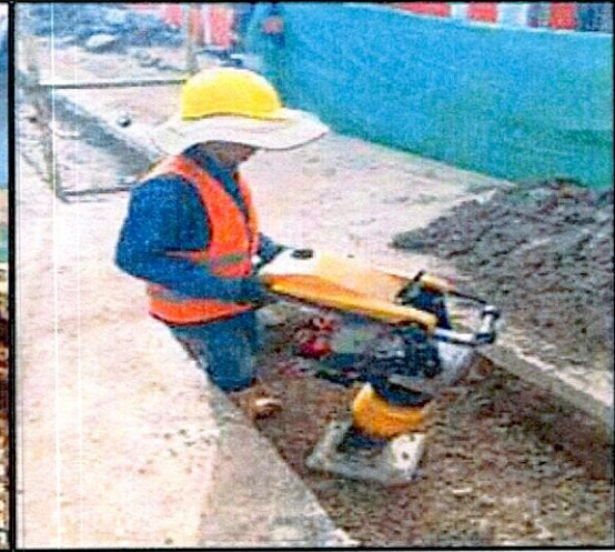
FOTO 15. Rellenos compactados con material de la obra
