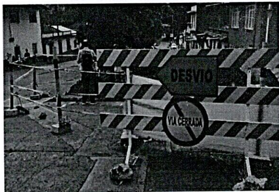
FOTO 3. Señalización, cintas, bombones y yute avenida Calle 9
