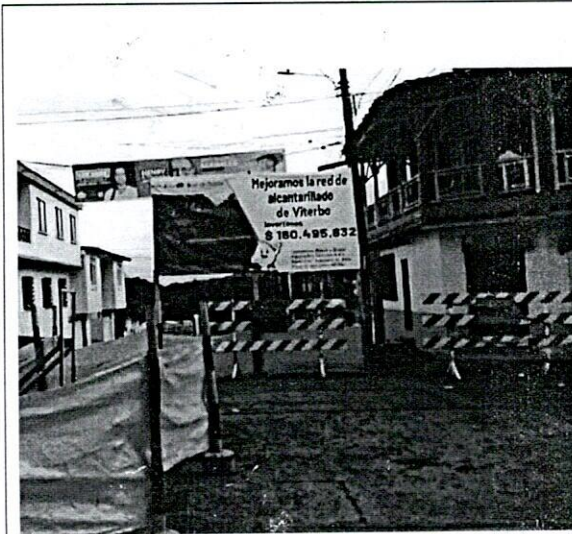
FOTO 1. Valla de la Obra, carrera 6 calle 8
