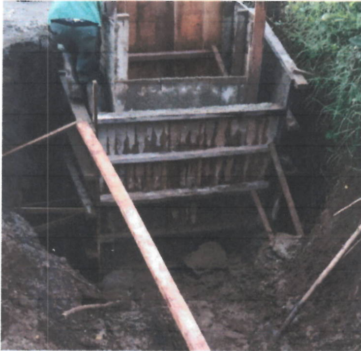
Foto 25. Construcción aliviadero D-29 tipo lateral
