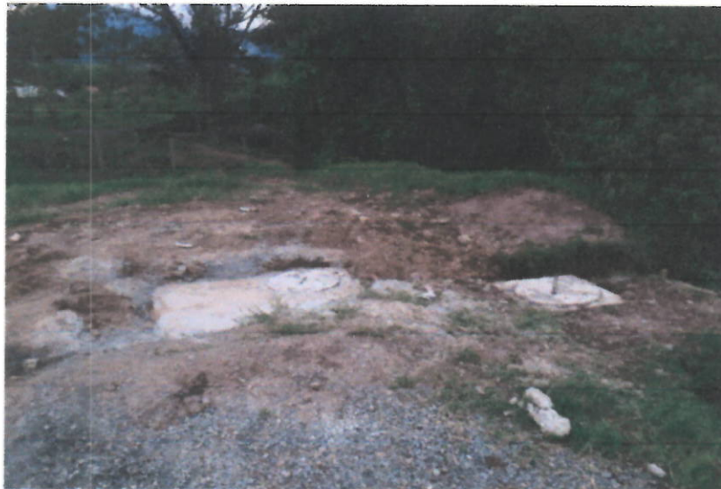
Foto 26. Terminado aliviadero D-28 y C-2
