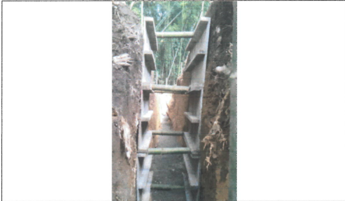
Foto 5. Entibados entre camaras
