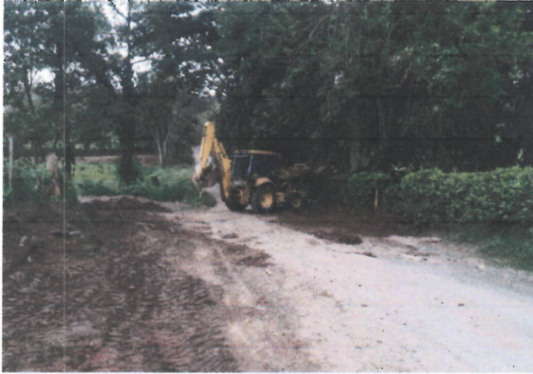
Foto 27. Terminado aliviadero D-29 y entrega de vía
