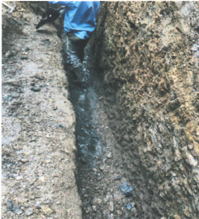
Foto 17. Excavación C-7 y C-8 en conglomerado y presencia de rocas
