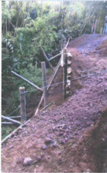
Foto 13. Construcción de trinchos para soportar y mejorar las condiciones del terreno y la zona por donde se instaló la tubería
