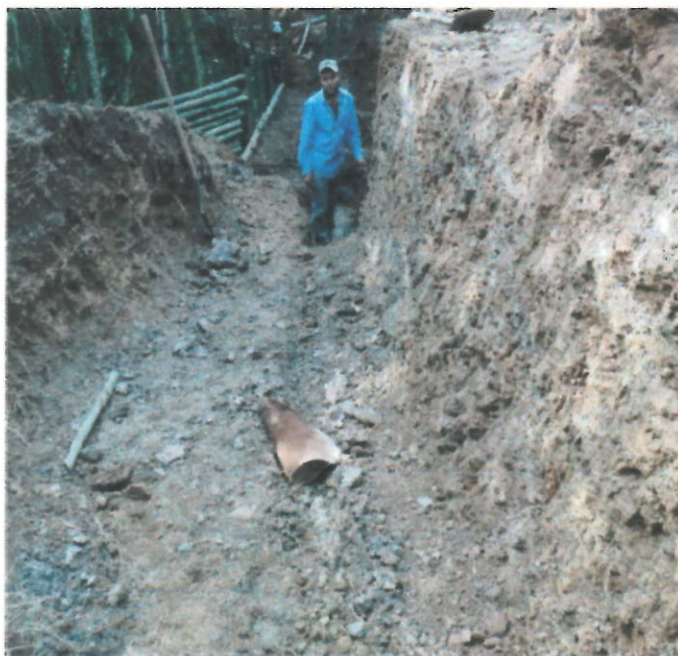
Foto 16. Excavación C-6 y C-7 en conglomerado y presencia de roca
