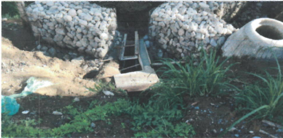
Foto 10. Construcción de gaviones y se organiza canal en concreto existente
