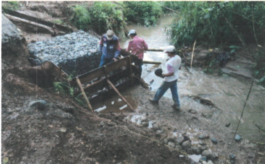
Fotos 12. Solados de limpieza
