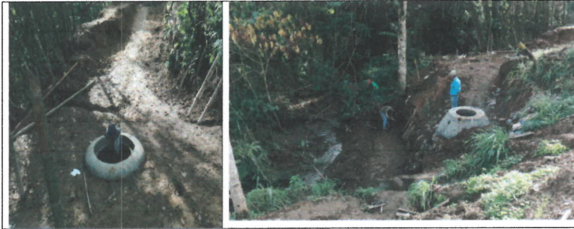
Foto 1 Y 2. Construcción de cámaras
