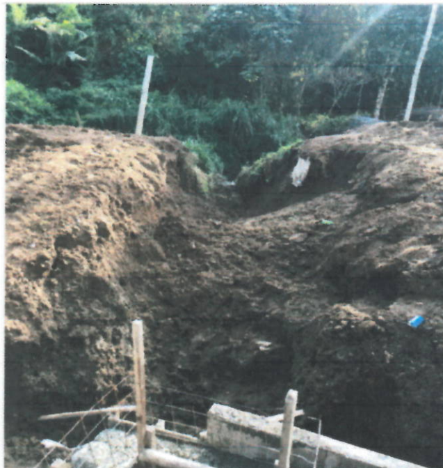
Foto 18. Excavación para descole
