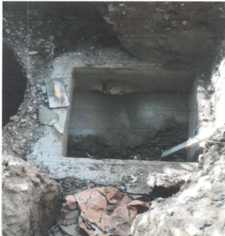
Foto 28. Construcción de cámara ciega entrega descole D-29
