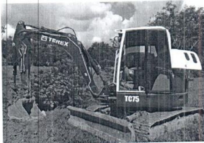
Foto 10. Inicio excavación con retro-excavadora
