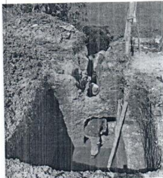
Foto 27. Construcción aliviadero D-28 tipo lateral
