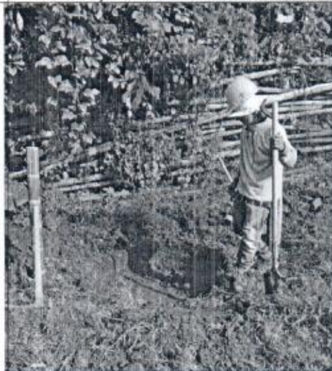
Foto 3 y 4. Visita inicio de obra.
