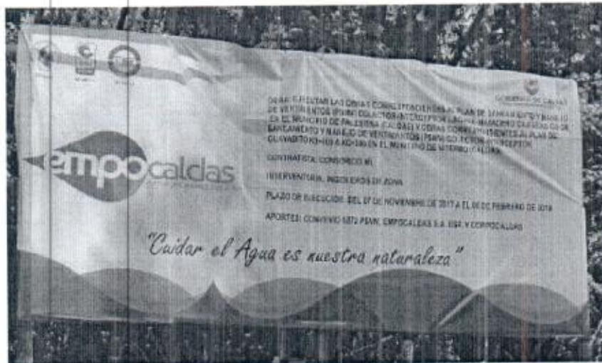
Foto 8. Valla alusiva a la obra.
