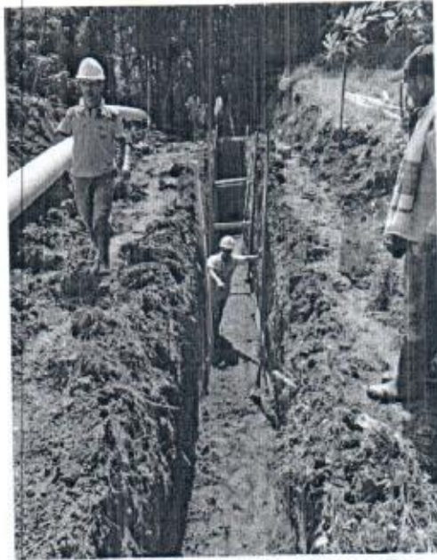
Foto 22. Excavación C-8 y C-7
