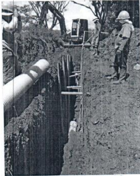
Foto 26. Excavación C-4 y C-3
