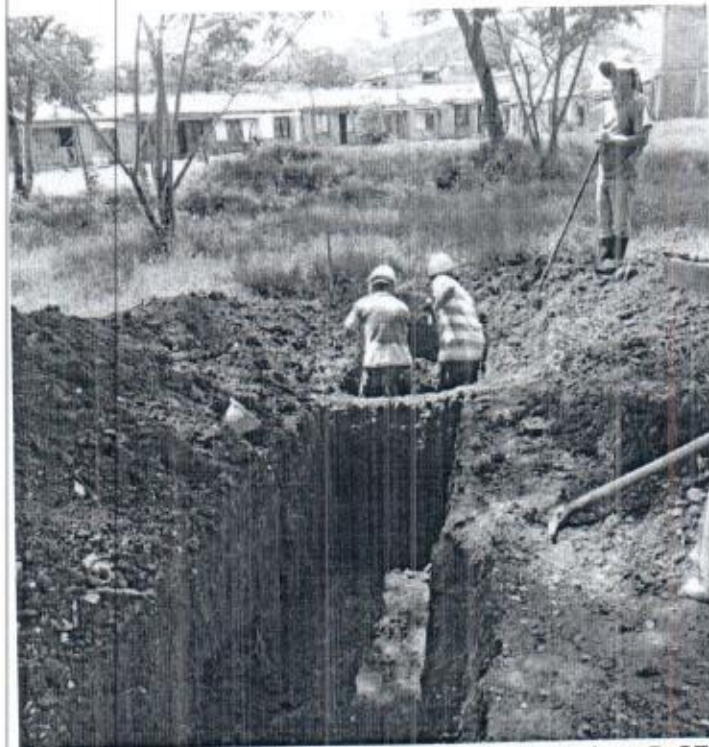
Foto 9. Excavaciones para construcción aliviadero D-27
