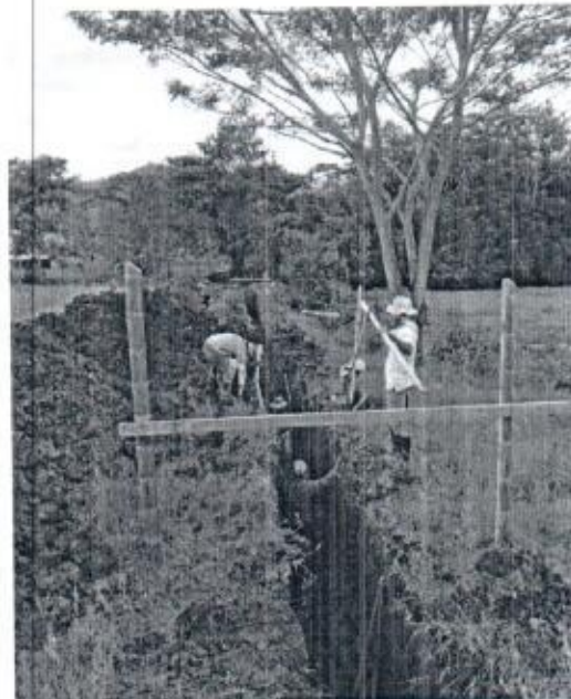
Foto 15. Se instalan hiladeros intermedios para optimizar la instalación
