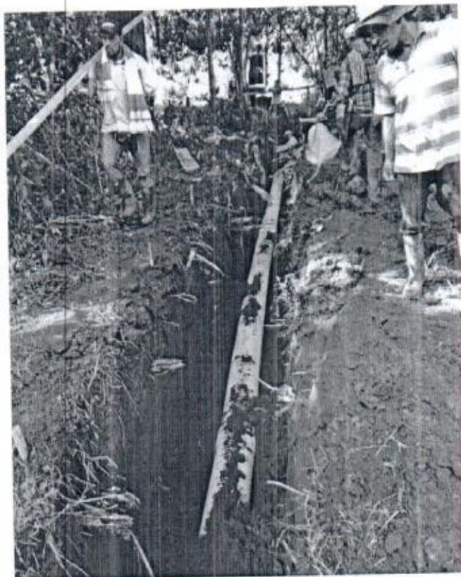
Foto 23. Excavación C-7 y C-6
