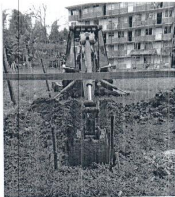
Foto 10. Inicio excavación con retro-excavadora
