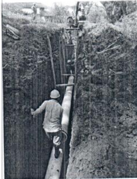
Foto 24. Excavación C-6 y C-5
