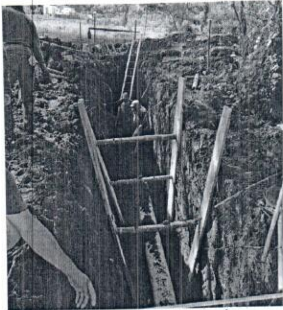
Fotos 12. Instalando tubería.
