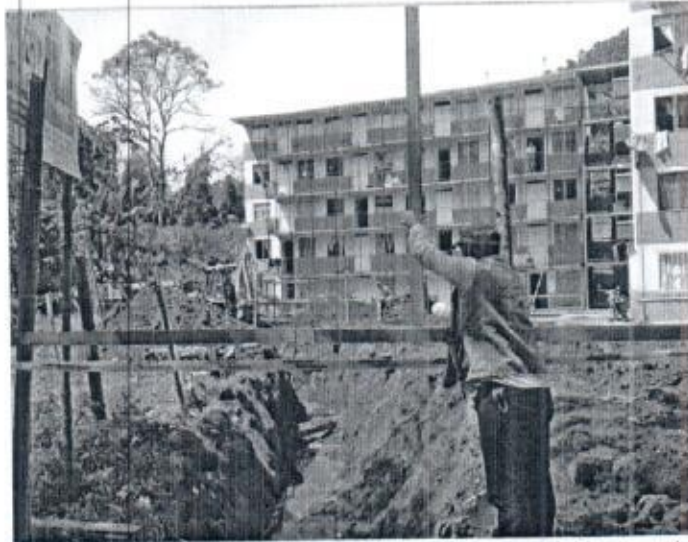
Fotos 15. Chequeo topográfico de los hiladeos y cotas de batea de las cámaras.
