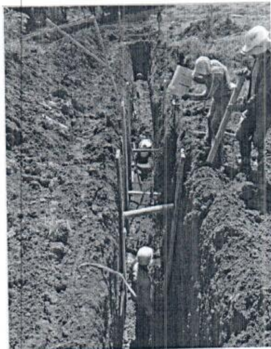
Foto 25. Excavación C-5 y C-4
