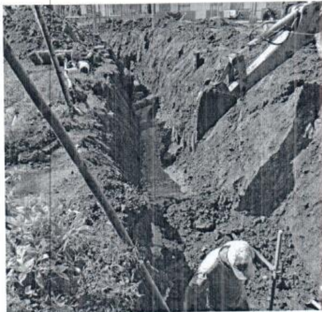
Foto 16. Excavación C-0 y C-1
