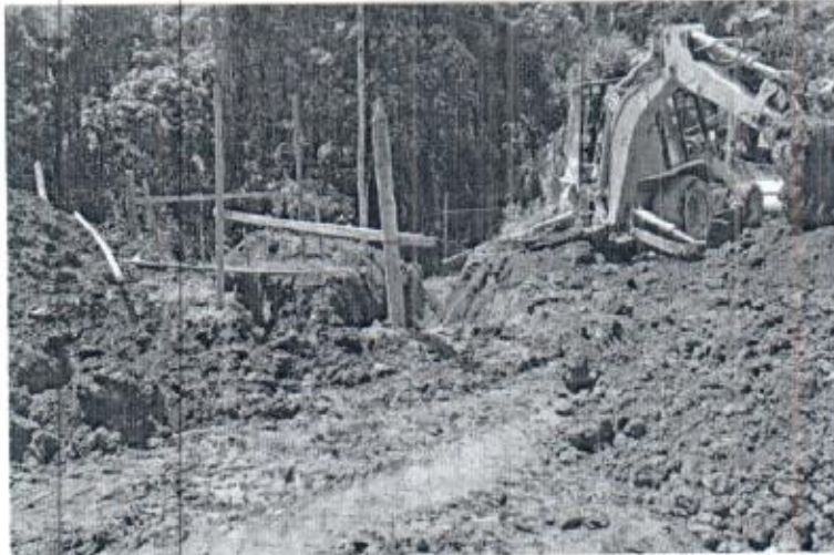
Foto 13. Excavaciones con maquinaria
