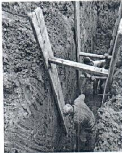
Fotos 20. Entibados para profundidades altas entre C-8 y C-7
