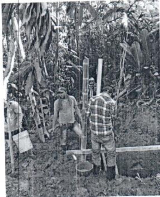
Fotos 18. Chequeo de las cotas de fondo de las cámaras.
