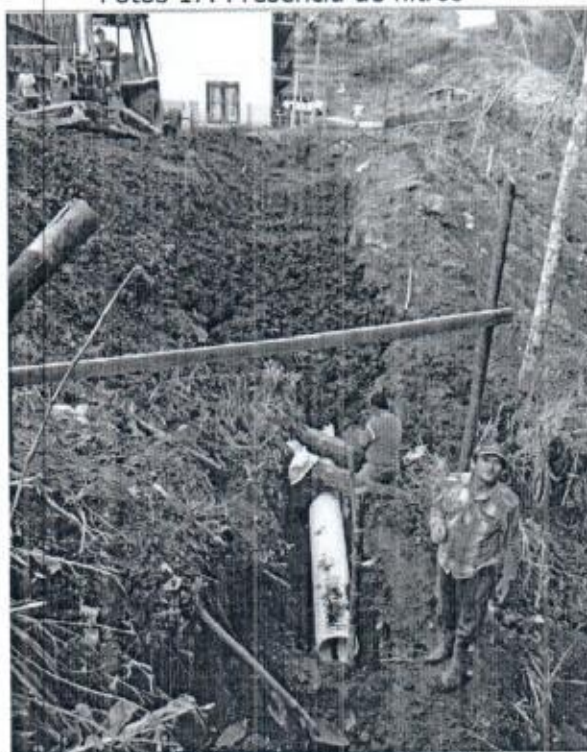
Fotos 18. Instalación de tubería
